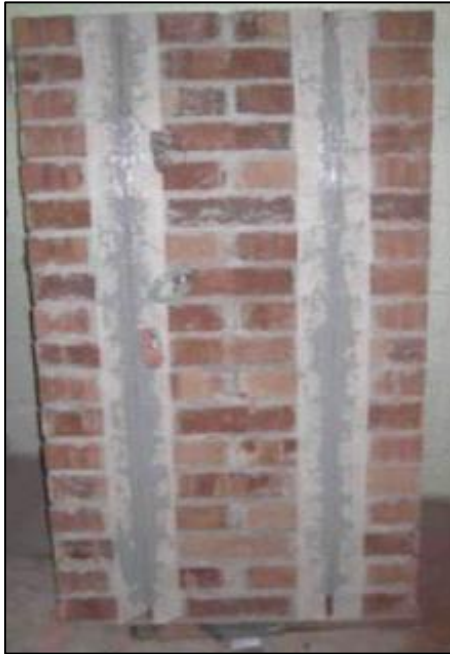
Foto 9 Detalle de Muro Reforzado
