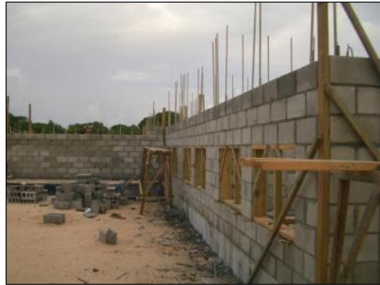
Foto 2 Construcción de Mampostería en Concreto con Barras de FRP
