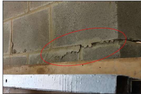
Foto 24 Aplastamiento en el Mortero de Pega
