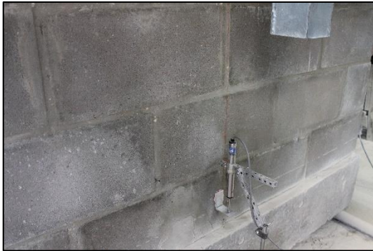
Foto 19 Ubicación LVDT Inferior
