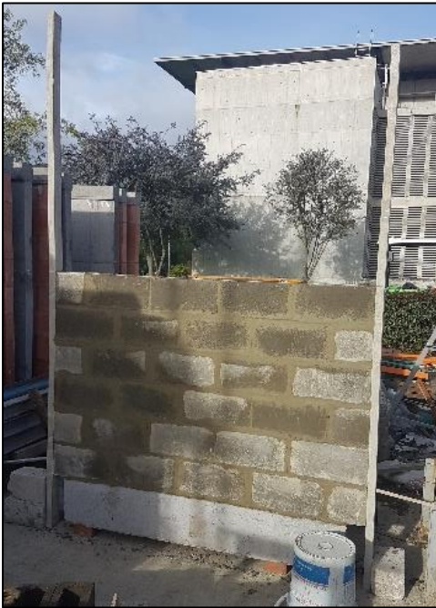
Foto 11 Construcción Parcial de Muros
