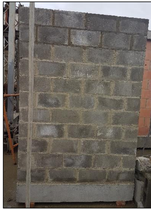
Foto 12 Construcción Final de Muros
