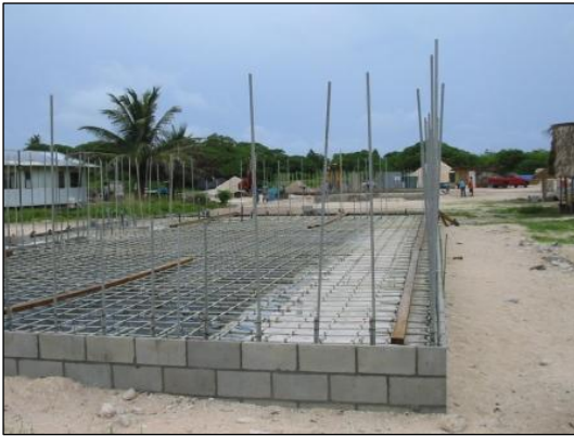
Foto 1 Construcción de Mampostería en Concreto con Barras de FRP
