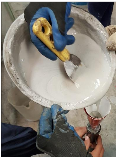
Foto 33 Llenado de Anclajes con Mortero Expansivo
