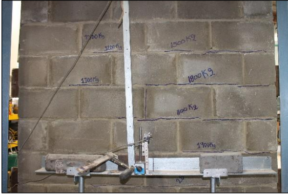
Foto 25 Fisuras Horizontales en el Mortero de Pega
