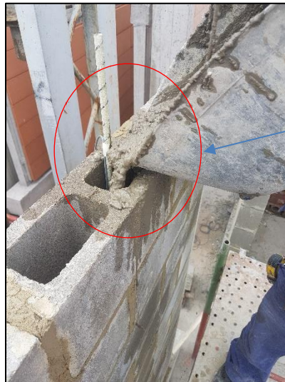
Foto 15 Inyección de las Celdas
