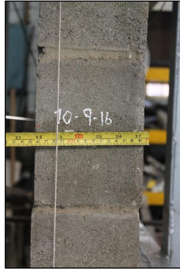
Foto 40 Línea de Plomada Antes de Desplazamientos
