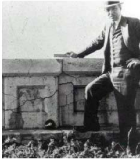
Figura 1-1 Thomas Stanton junto a un muro afectado por la reacción alkali-agregado.
