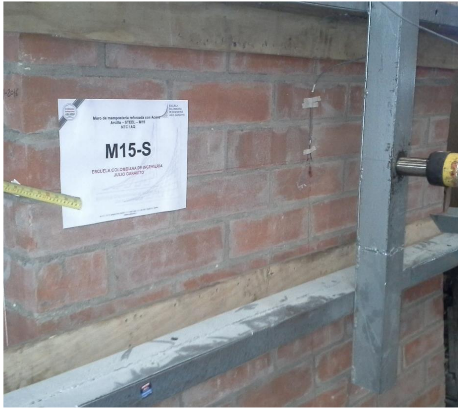
1.) Montaje del muro M15-S
