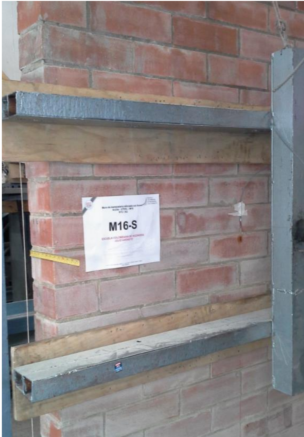
1.) Montaje del muro M16-S
