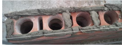
2.) Vista de planta de la colocación del mortero de pega en los ladrillos
