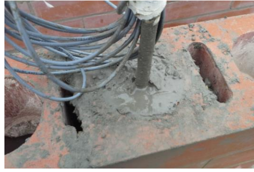
2.) Colocación del mortero de relleno.
