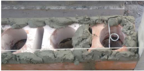
3.) Alambre para centrar el refuerzo longitudinal del muro
