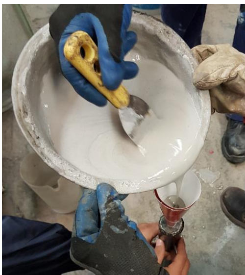
1.) Preparación e inyección del mortero
