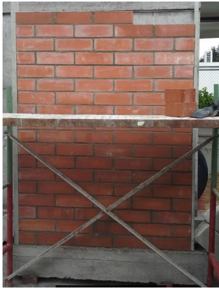
5.) Ubicación y nivelación de la hilera
