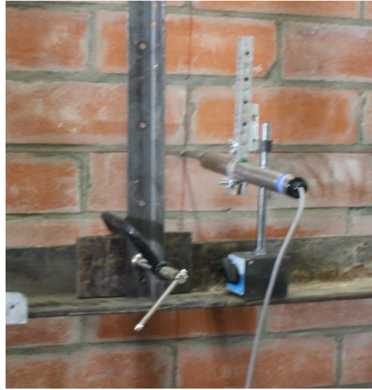
2.) Instalación del deformimetro electrónico LDVT cara de tensión
