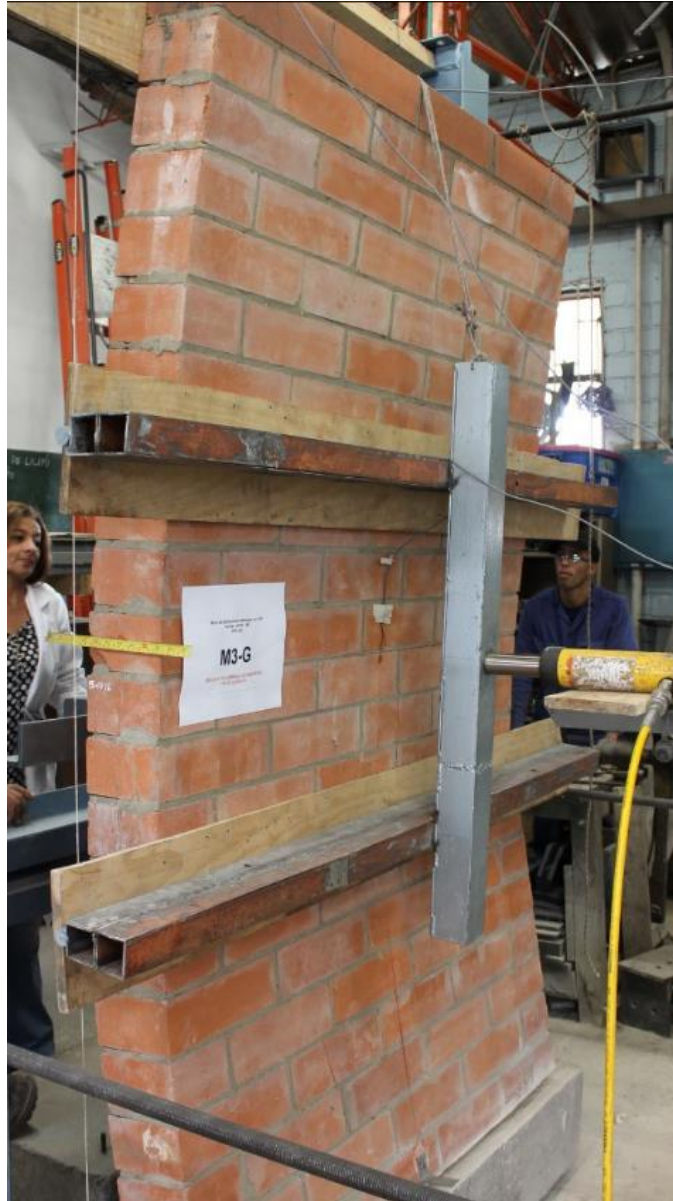
3.) Fisuras en la cara de compresión del muro M3-G
