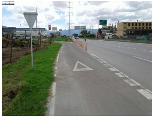
Figura 44. Estado Actual de la Vía – Costado Norte – Sentido Bogotá – Villeta (Elaboración propia) C/N
