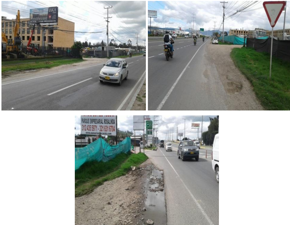
Figura 50. Km. 4+000 al Km. 5+000 – Doble Calzada con 4 carriles y separador central C/S
