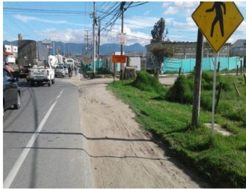
Figura 47. Km. 1+000 al Km. 2+000 – Doble Calzada con 4 carriles y separador central C/S
