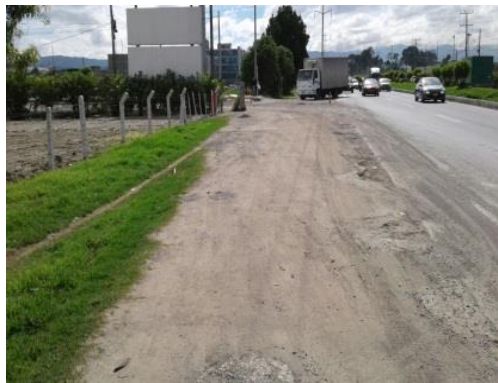
Figura 42. Km. 2+000 al Km. 3+000 – Doble Calzada con 4 carriles y separador central – Puente Peatonal Uniabastos Km. 2+410 C/N
