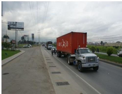
Figura 39. Km. 0+000 al Km. 1+000 – Doble Calzada con 4 carriles y separador central C/N
