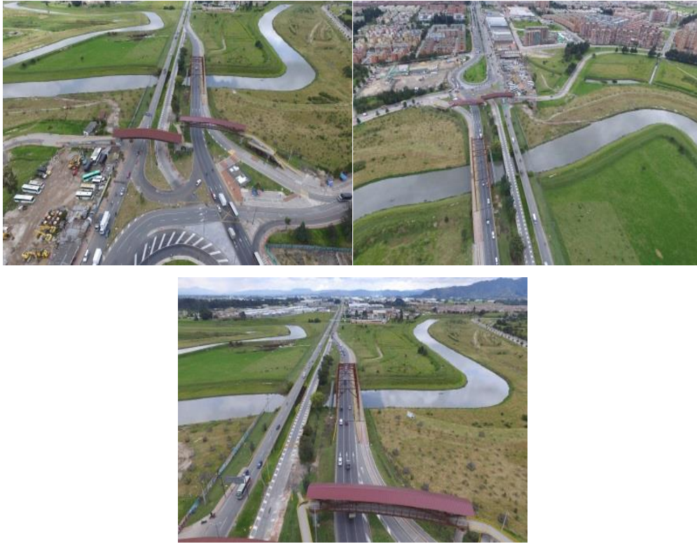
Figura 45. Km. 0+000 – Puente Nuevo El Cortijo Costado Norte y Puente El Cortijo Existente Costado Sur – Puente Peatonal de Guadua Km. 0+000 C/S
