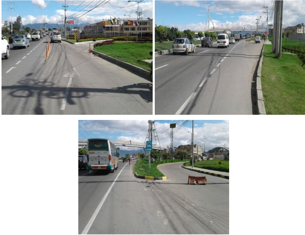
Figura 49. Km. 3+000 al Km. 4+000 – Doble Calzada con 4 carriles y separador central – Puente Peatonal Centro Empresarial Metropolitano Km. 3+750 C/S
