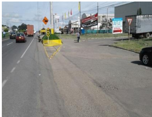
Figura 40. Km. 1+000 al Km. 2+000 – Doble Calzada con 4 carriles y separador central C/N
