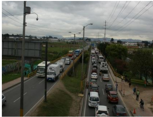
Figura 46. Km. 0+000 – Puente El Cortijo Existente Costado Sur y Costado Norte C/S
