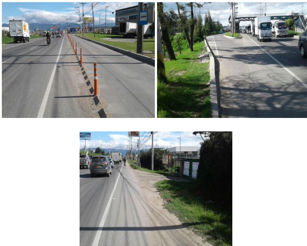
Figura 48. Km. 2+000 al Km. 3+000 – Doble Calzada con 4 carriles y separador central – Puente Peatonal Uniabastos Km. 2+410 C/S
