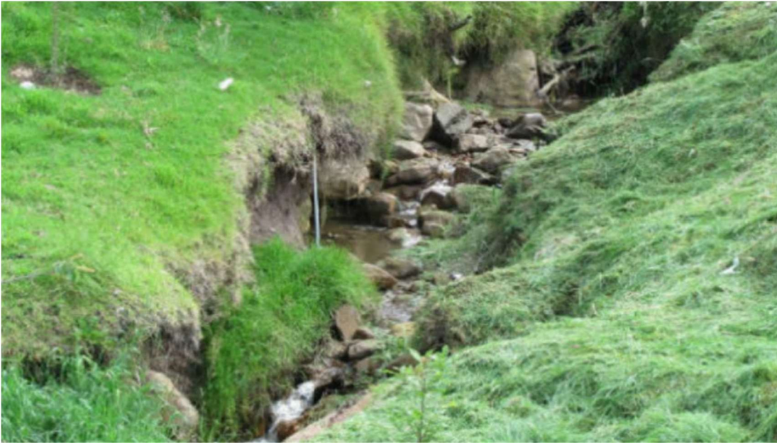
Figura 7. Erosión en un cauce urbano de montaña
