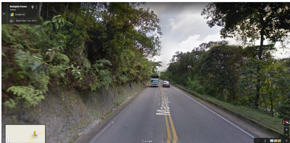
Fotografía 4-3. Tramo 5007. Fresno – Honda.
