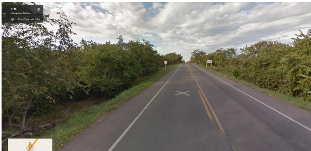
Fotografía 2-6. Tramo 4506. Neiva - Castilla
