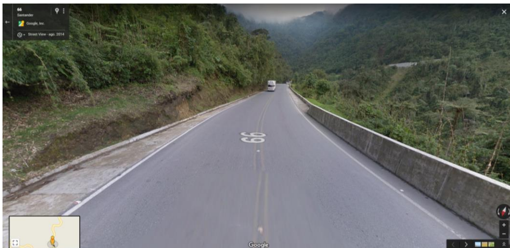
Fotografía 5-10. Tramo 6603. Bucaramanga – Pamplona.
