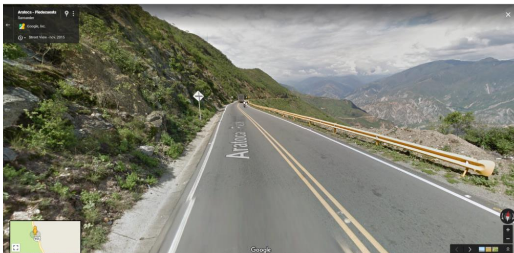
Fotografía 4-9. Tramo 45A07. San Gil – Bucaramanga.
