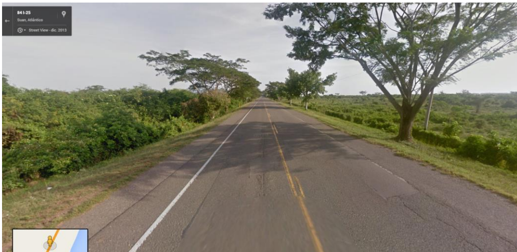
Fotografía 2-3. Tramo 2516. Calamar - Barranquilla
