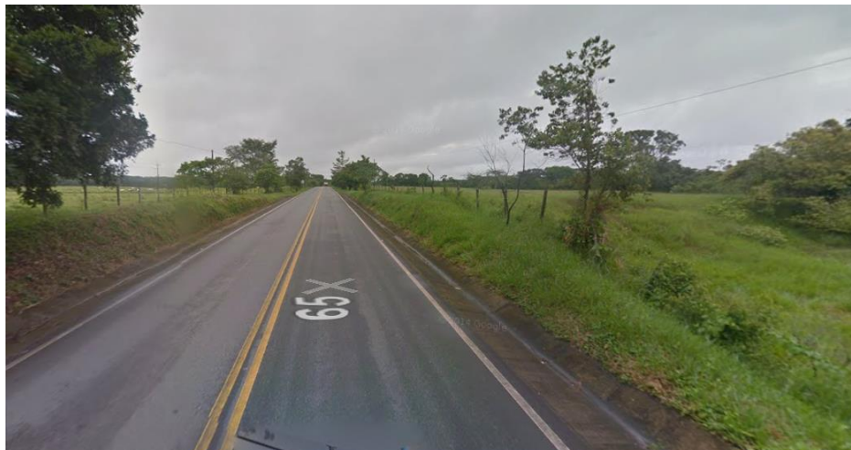
Fotografía 3-3. Tramo 6510. Villavicencio – Barranca de Upía
