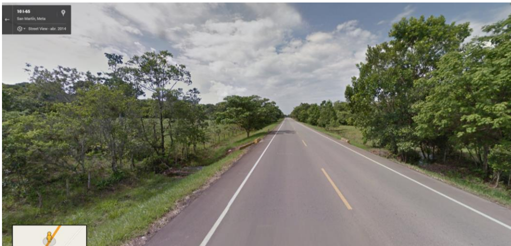
Fotografía 2-8. Tramo 6509. Ye de Granada - Villavicencio
