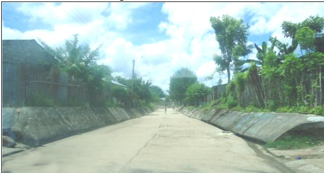
Figura 4-9 Fotografía de aspecto típico de la calle canal de La Bodega. Las bocacalles son ingresos de canales laterales.
