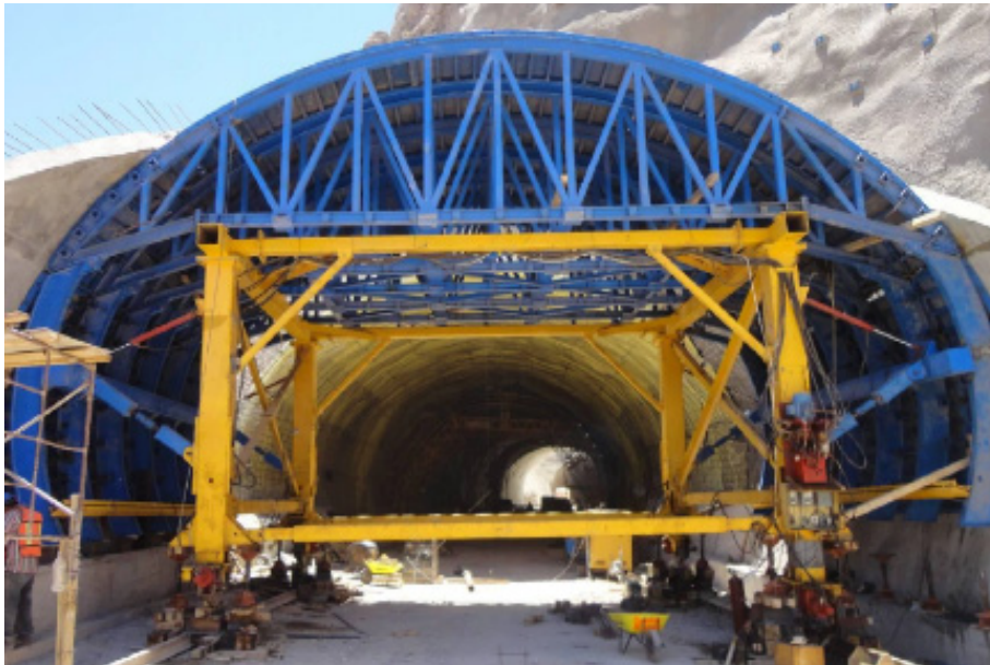
Figura 136. Características de la logística para la colocación del concreto in situ. Fuente: (AMITOS, Descripción General del espacio Subterráneo, 2011, págs. 1 -91)
