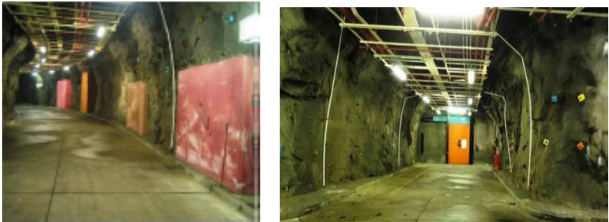
Figura 14. Proyecto Tau Shat Wan Túnel - Explosivos Magazín. Fuente: (Kong, 2006). Proceedings of the 30th International Geological Congress y Chan & Ng.
