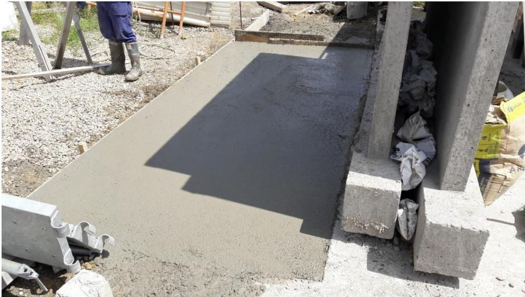
*Figura 6. Losas fundidas para ensayos de tensión.
