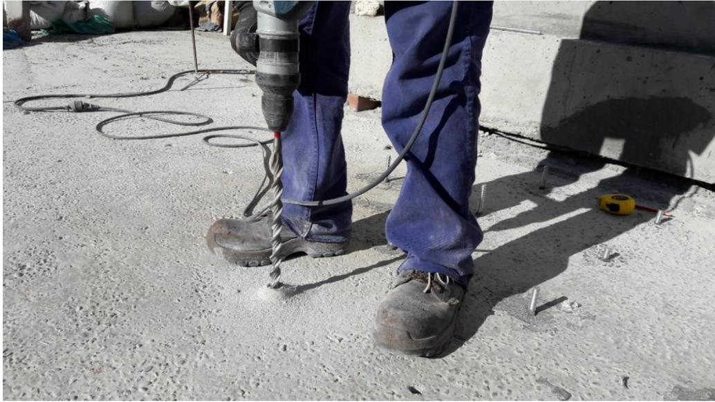
*Figura 10. Perforación de las losas con taladro rotopercutor.
