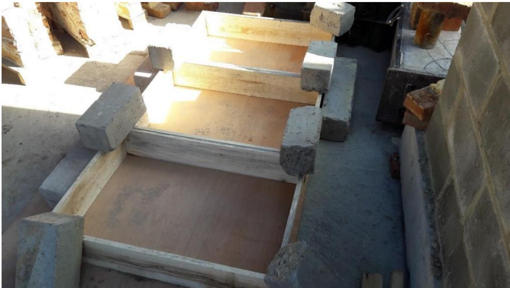
*Figura 7. Formaleta de las losas para ensayos de cortante.
