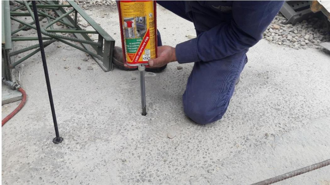
*Figura 12. Inyección del producto epóxico en la perforación.
