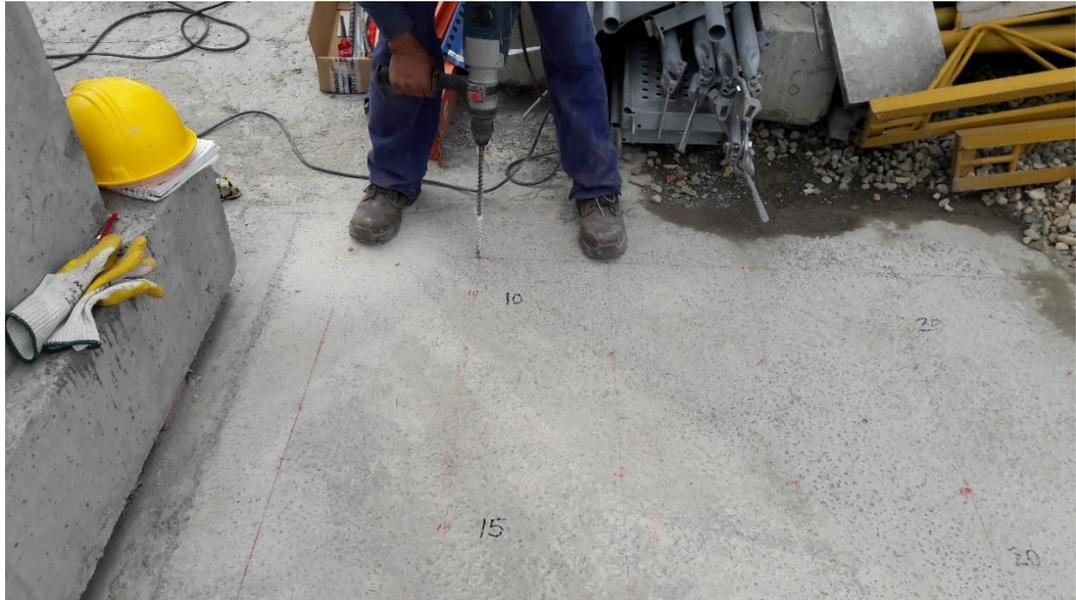
*Figura 9. Perforación de los primeros anclajes.*
