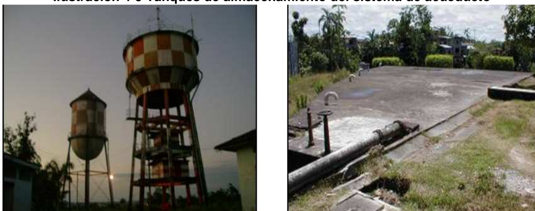
Ilustración 4-5 Tanques de almacenamiento del sistema de acueducto
