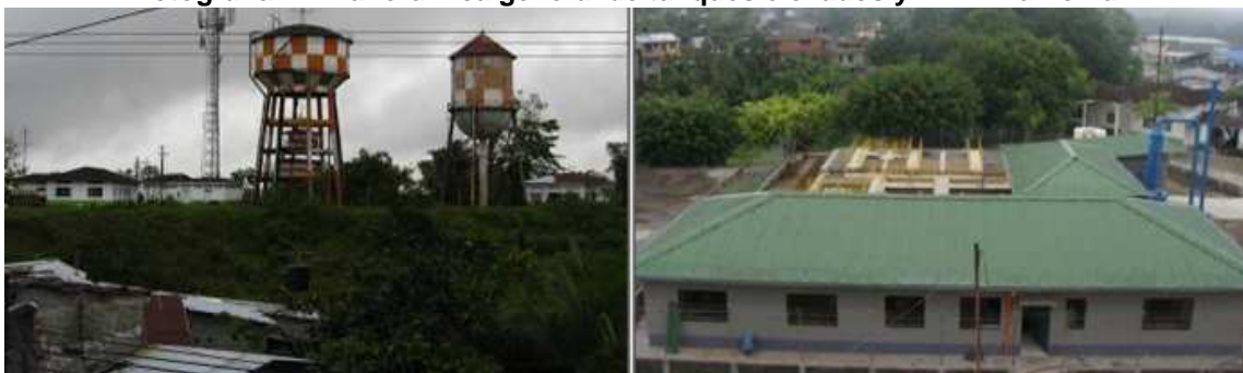
Fotografía 4-2 Panorámica general de tanques elevados y PTAP La Loma
