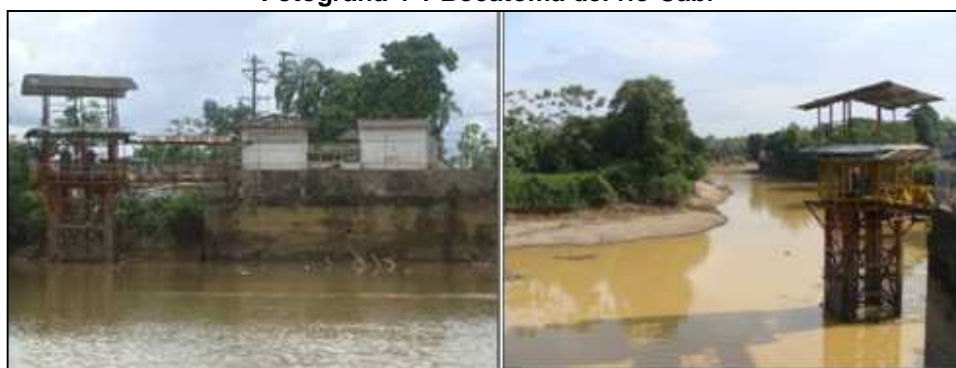
Fotografía 4-1 Bocatoma del río Cabí
