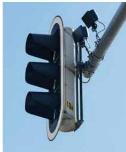
Figura 44 Sistema de detección por Radar Fuente: SIEMENES, 2011.
