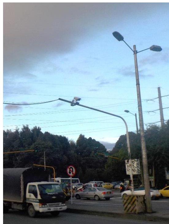
Figura 42 Cámaras de video detección Placas AK 68 Fuente: El autor adaptado de la SDM
