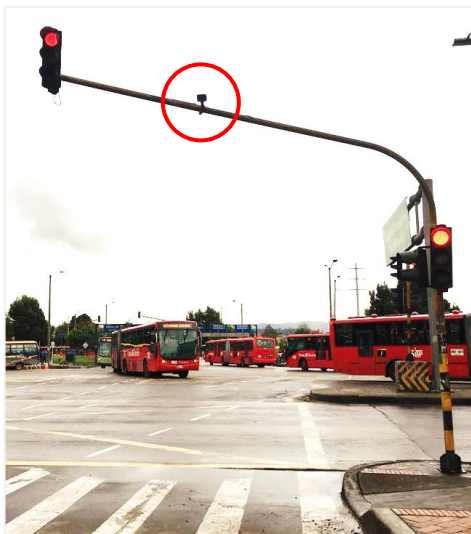
Figura 43 Sistema de detección por Radar - CL 80 Fuente: El autor adaptado de la SDM.
