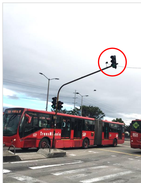
Figura 34 Cámaras para tráfico semiactuado CL 80 Fuente: El autor adaptado de la SDM
