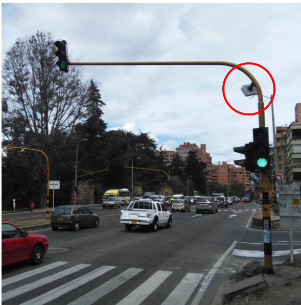
Figura 35 Sensor wifi-bluetooth carril mixto Fuente: El autor adaptado de la SDM
