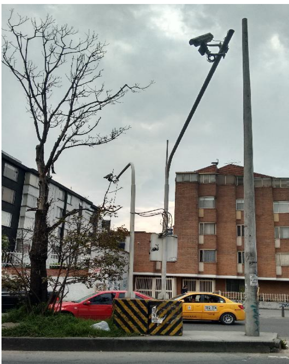
Figura 41 Cámaras de video detección de Placas Fuente: Información oficial SDM Centro de Gestión
