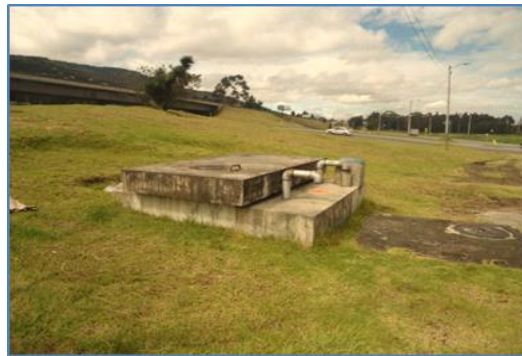
Imagen 2 Caja de válvula de cierre de 16" -Estación Ferrocarril-La Caro. Fuente: Propia autoría
