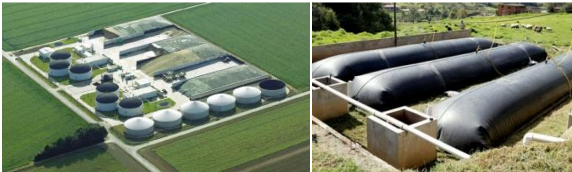
Figura 14. Iz. Planta de Biogas en Aiterhofen, Alemania. Der: Biodigestor Sabana de Bogotá Colombia. Fuente: EBA. SchmackBiogasGmbH y Contexto Ganadero.
