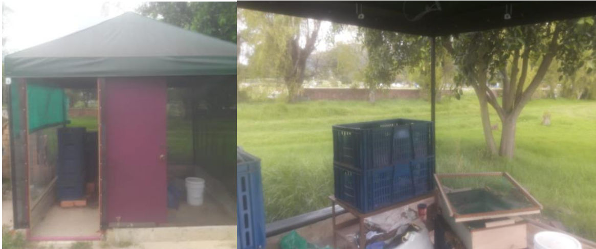
Figura 19. Piloto de compostaje luego de las adecuaciones del cerramiento.
