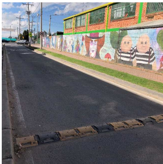
Figura 47. Reductor de Velocidad Cra. 5ª Este. Fuente: Inspección 2018
