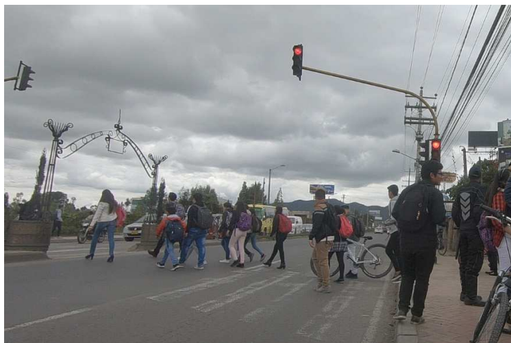
Figura 36. Paso peatonal semaforizado mal demarcado. Fuente: Inspección 2018
