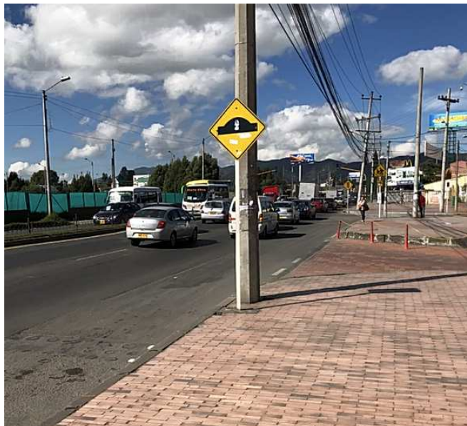
Figura 43. Señalización vertical pendiente de retirar. Fuente: Inspección 2018
