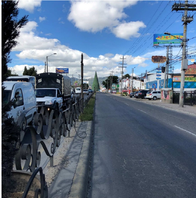
Figura 34. Deficiente demarcación en la Av. Pradilla. Fuente: Inspección (2018)
