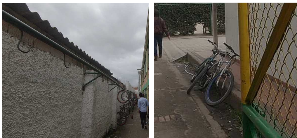
Figura 41. Estacionamiento de bicicletas. Fuente: Inspección 2018
