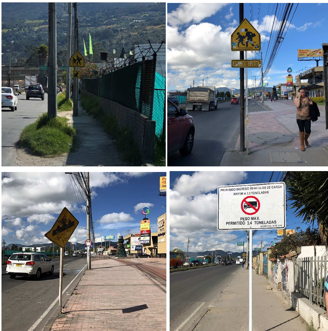
Figura 42. Estado señalización vertical. Fuente: Inspección 2018
