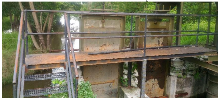
Ilustración 28. Estructura de compuertas
