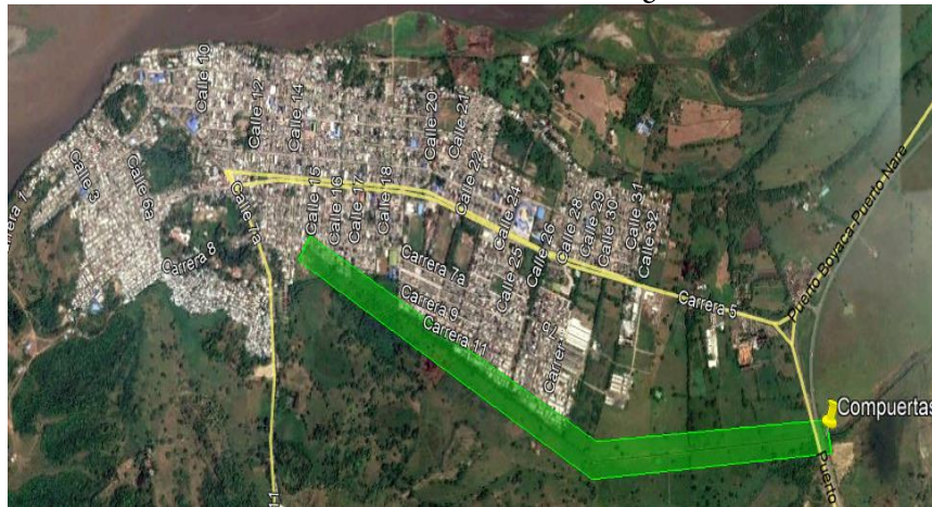
Ilustración 6. Localización Canal El Progreso.
