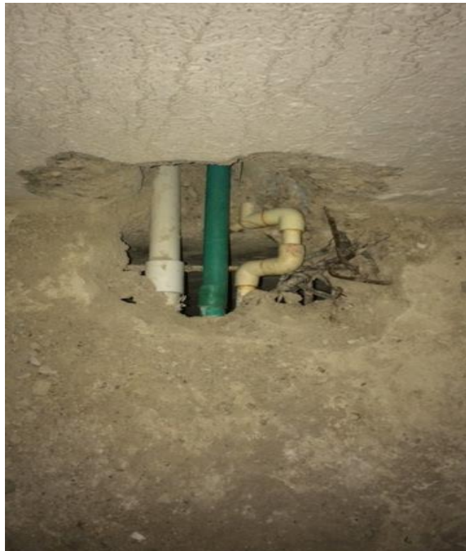
Ilustración 11.10 Reparación de red de suministro en placa de concreto en Sistema Industrializado por perforación de taches durante proceso de testereado de muros.
