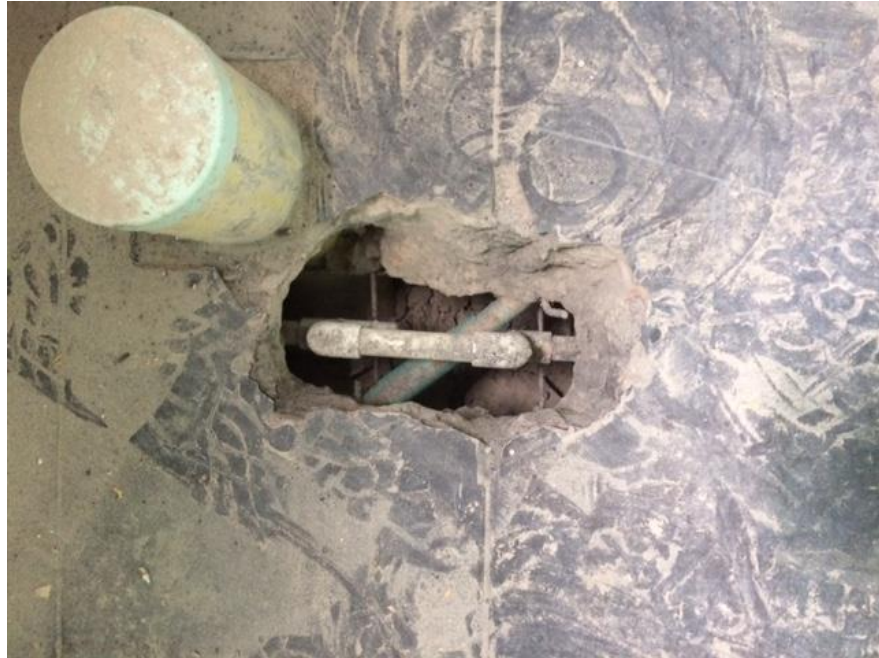
Ilustración 11.9 Reparación de red de suministro en placa de concreto de piso 1 por perforación de tornillos para soporte de tubería colgante en sótano.
