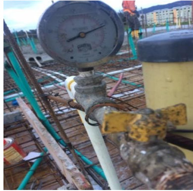
Ilustración 11.7 Manómetro durante prueba de presión de Placa de entepiso.
