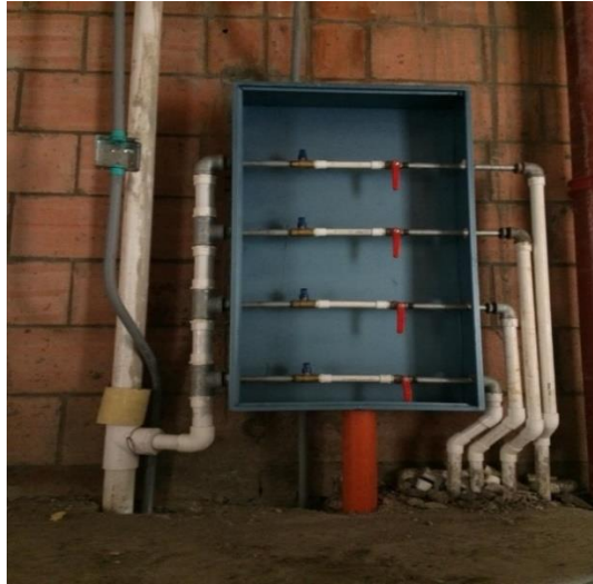
Ilustración 11.5 Cajilla medidores para 4 apartamentos, red matriz 2 1/2", piso tipo proyecto Venti.
