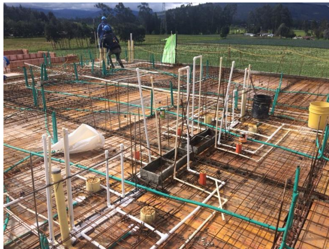
Ilustración 11.1 Armado de red de suministro para placa de entrepiso
