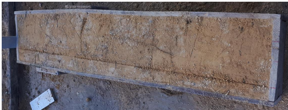
Fotografía 4.5 Acabado de la cama de arena para soporte de los muros de compresión diagonal
