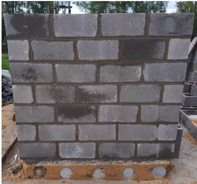
Fotografía 4.13 Muro de mampostería para ensayo a compresión diagonal terminado
