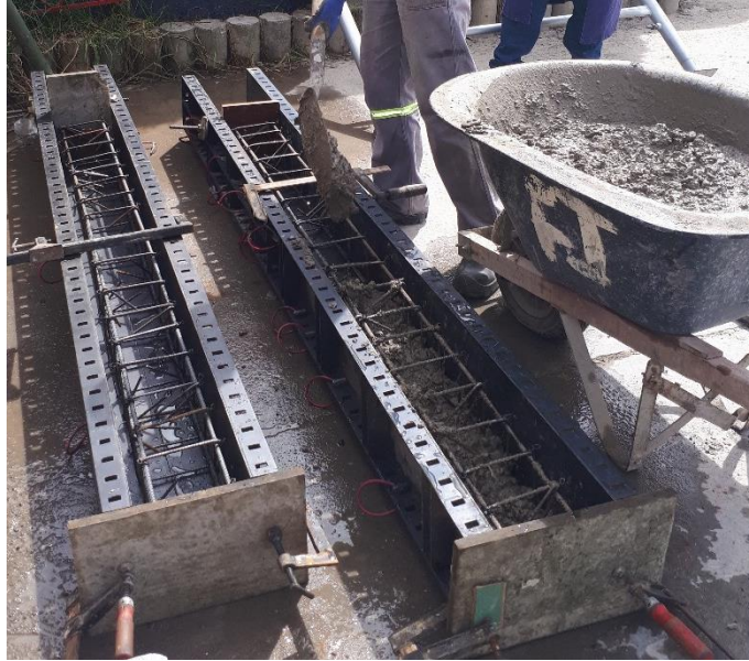
Fotografía 4.15 Ubicación del refuerzo dentro de la formaleta y colocación del concreto
