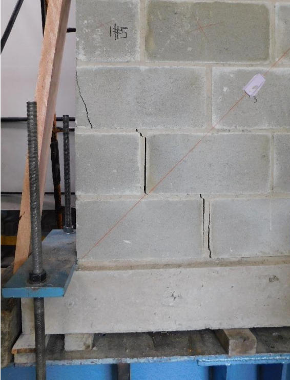
Fotografía 5.50 Fisuras de la parte inferior izquierda en la cara frontal
