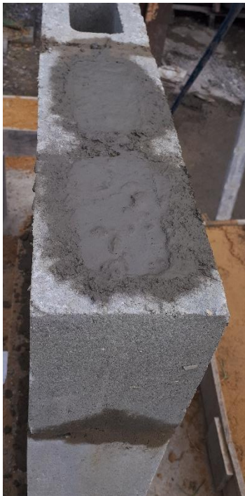
Fotografía 4.12 Relleno de las celdas de esquina del muro
