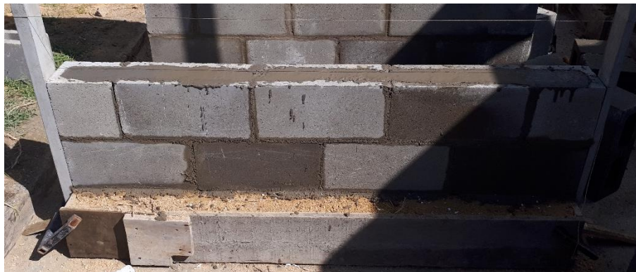
Fotografía 4.7 Relleno de la segunda hilada del muro MD-2#4/60
