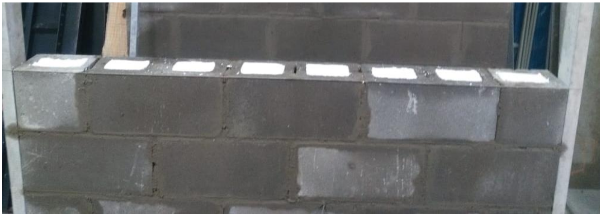
Fotografía 4.22 Colocación de icopor para sellar las celdas de mampostería
