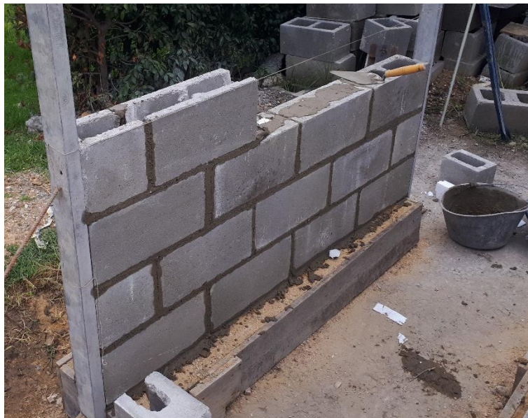
Fotografía 4.9 Ubicación y nivelación de la hilera
