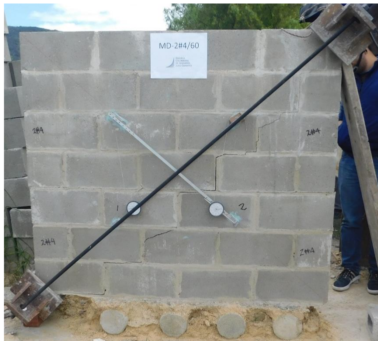
Fotografía 5.23 Fisuras en la cara frontal del muro MD-2#4/60
