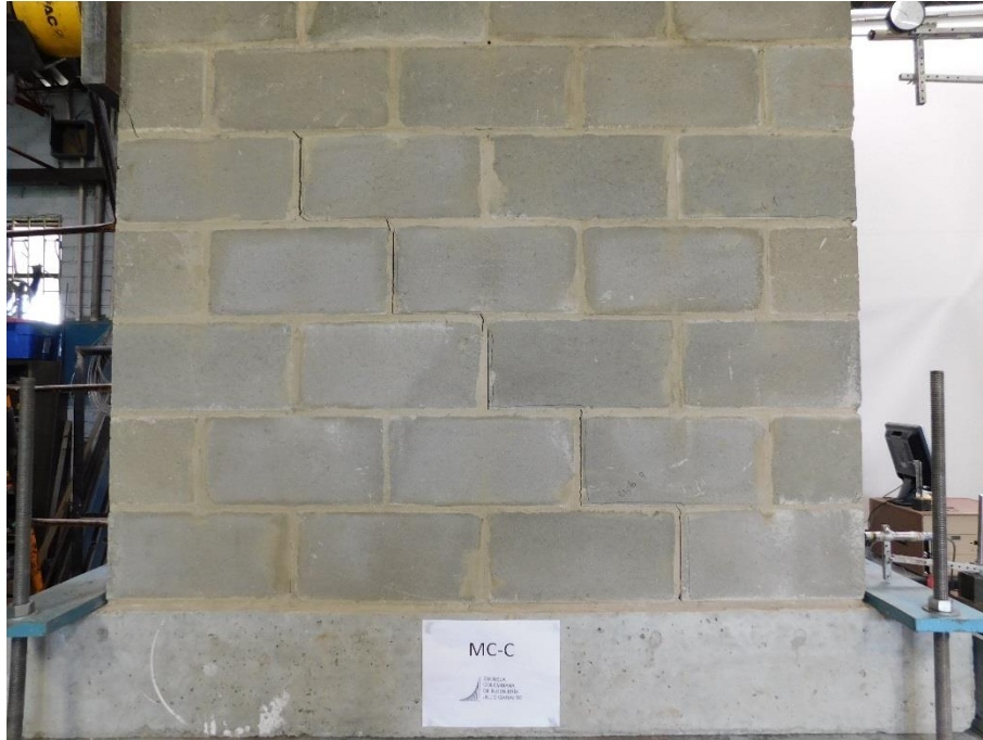
Fotografía 5.41 Fisura escalonada de la parte inferior en la cara frontal
