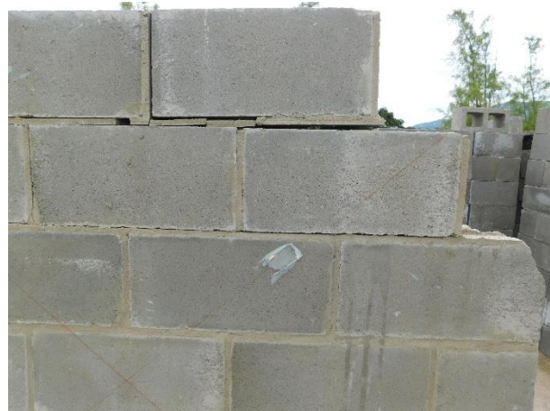
Fotografía 5.22 Fisuras de la parte superior derecha en la cara posterior
