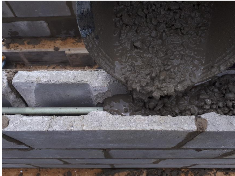
Fotografía 4.11 Relleno de las celdas de mampostería con el mortero de relleno
