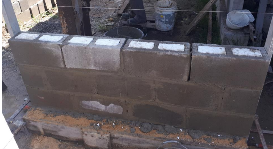
Fotografía 4.8 Colocación de icopor para sellar las celdas de mampostería
