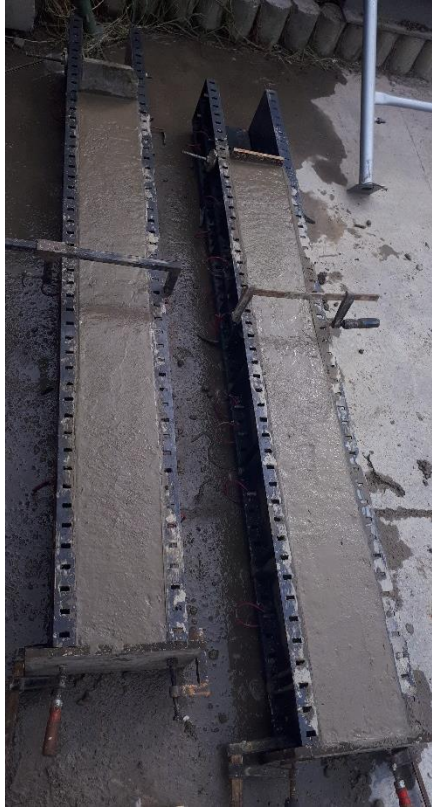
Fotografía 4.17 Acabado de la superficie de las vigas
