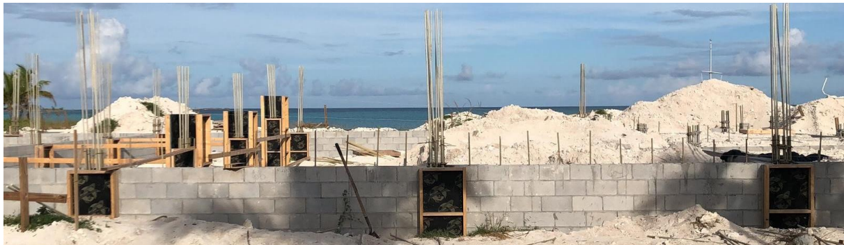
Fotografía 1.1 Construcción de mampostería de concreto reforzada con barras de GFRP en las Bahamas (Nanni, n.d.)
