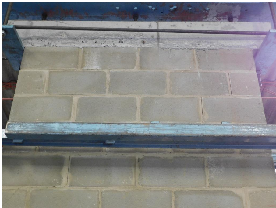
Fotografía 5.46 Fisura escalonada de la parte superior en la cara frontal
