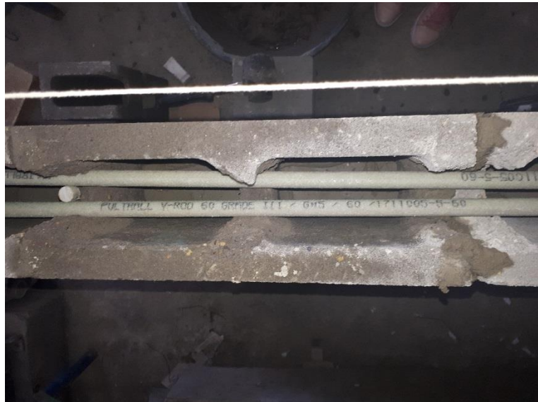
Fotografía 4.19 Colocación de las barras de GFRP en el muro de mampostería de concreto
