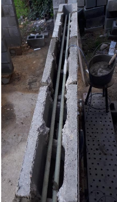
Fotografía 4.10 Colocación de las barras de GFRP
