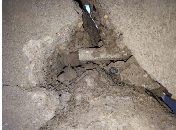
Fotografía 5.33 Verificación de confinamiento de la barra de GFRP en la hilada 6
