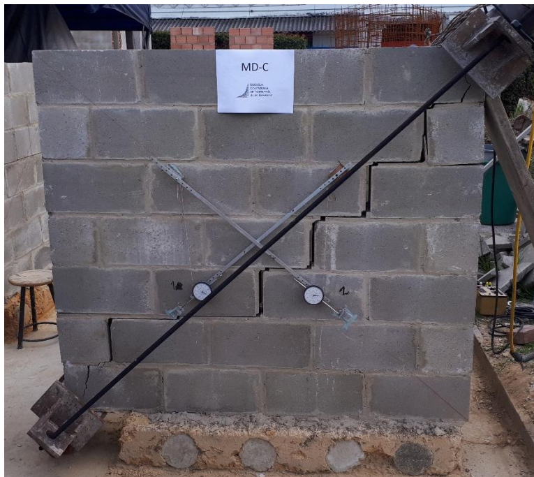
Fotografía 5.7 Fisuras en la cara frontal del muro MD-C
