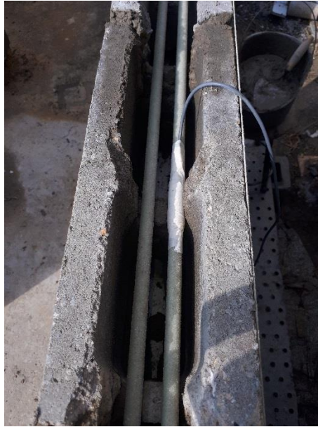
Fotografía 4.25 Barra de GFRP instrumentada y protegida dentro del muro de mampostería
