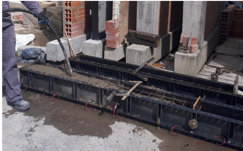
Fotografía 4.16 vibrado del concreto
