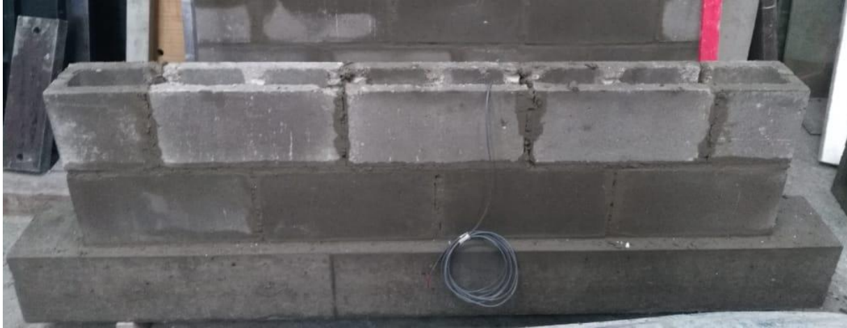
Fotografía 4.18 Viga de cimentación del muro de mampostería con primera y segunda hilada
