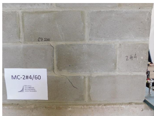
Fotografía 5.69 Fisura escalonada en la parte inferior derecha de la cara frontal
