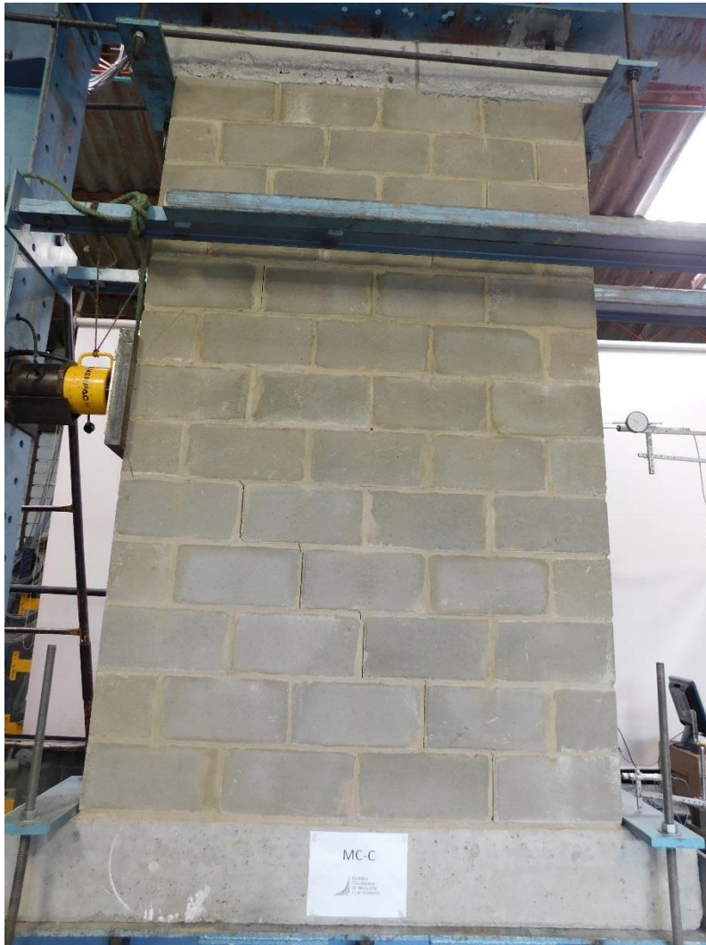
Fotografía 5.40 Fisuras en la cara frontal del muro MC-C
