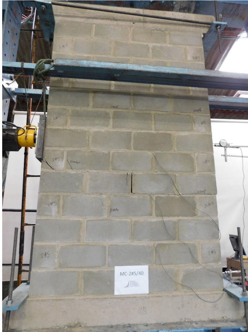
Fotografía 5.83 Fisuras en la cara frontal del muro MC-2#5/40
