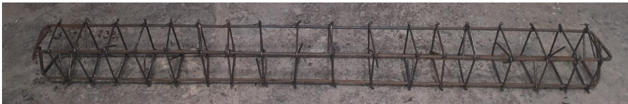
Fotografía 4.14 Armadura de acero de refuerzo de las vigas
