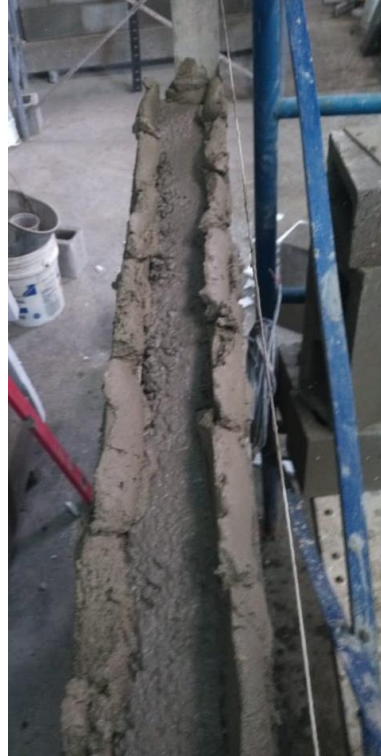
Fotografía 4.21 Colocación del mortero de pega sobre la hilada 2
