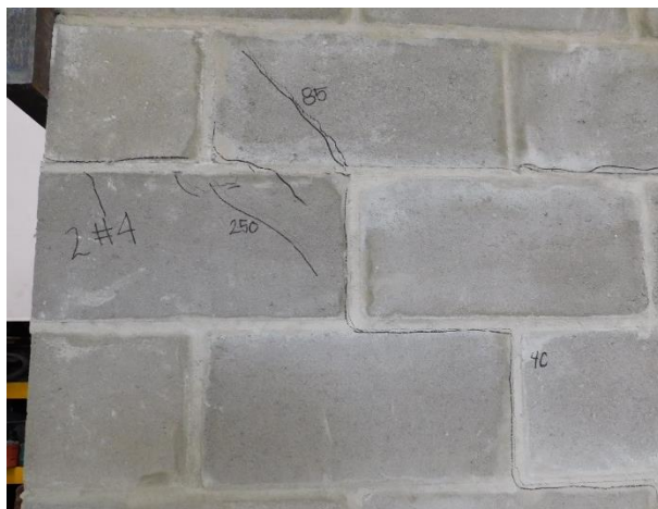
Fotografía 5.68 Fisuras en los bloques de las hiladas 5 y 6 en la parte izquierda de la cara frontal
