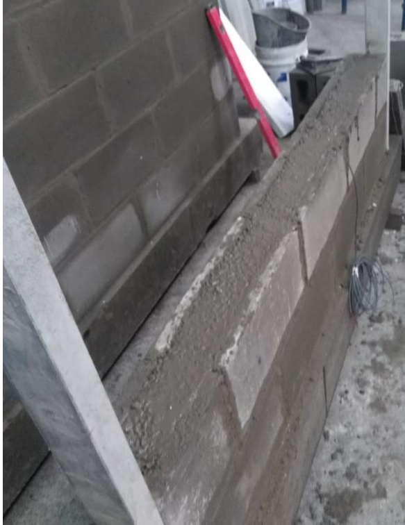
Fotografía 4.20 Colocación del mortero de relleno en la hilada 2
