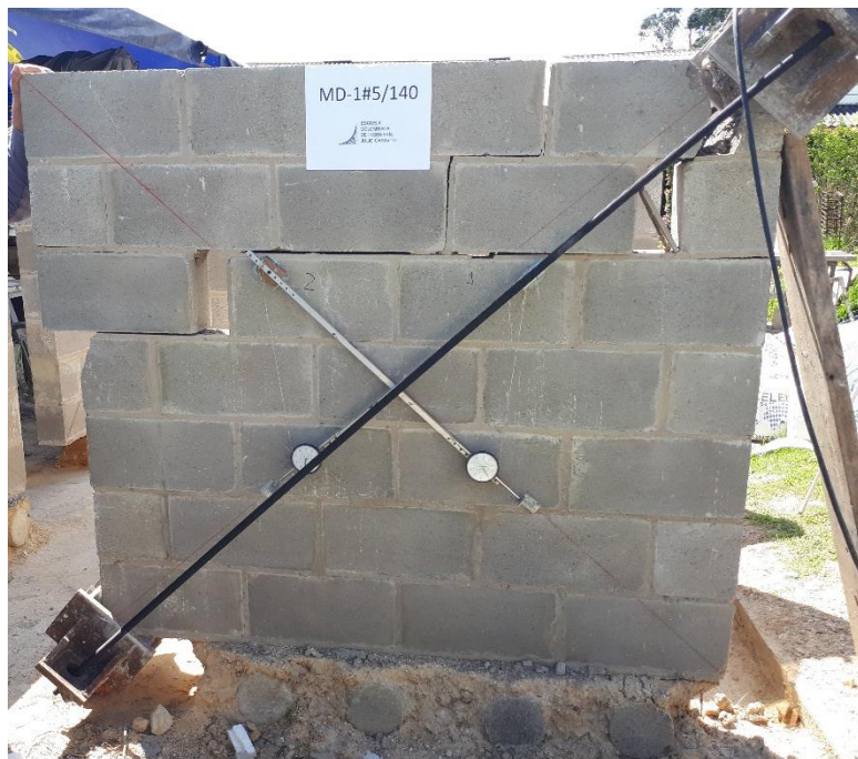
Fotografía 5.13 Fisuras en la cara frontal del muro MD-1#5/140
