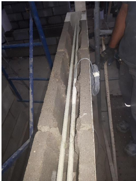
Fotografía 4.19 Colocación de las barras de GFRP en el muro de mampostería de concreto
