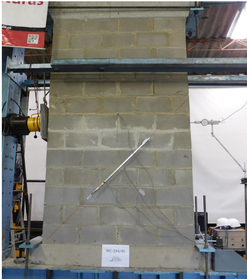
Fotografía 5.74 Fisuras en la cara frontal del muro MC-2#4/40
