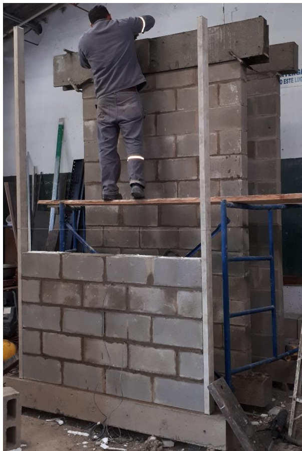
Fotografía 4.23 Elaboración de la viga superior sobre el muro de mampostería
