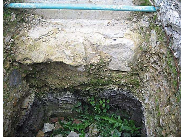
Figura 35. Apique viga de cimentación fachada principal (archivo propio)
