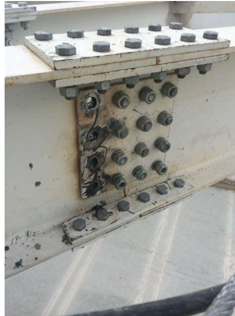
Figura 81. Conexiones incompletas (archivo propio)
