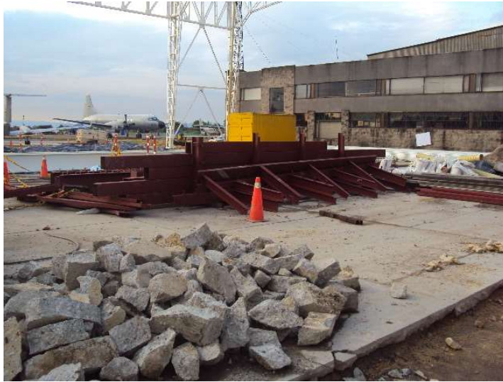
Figura 117. Demolición de placa zona mezanine (archivo propio)
