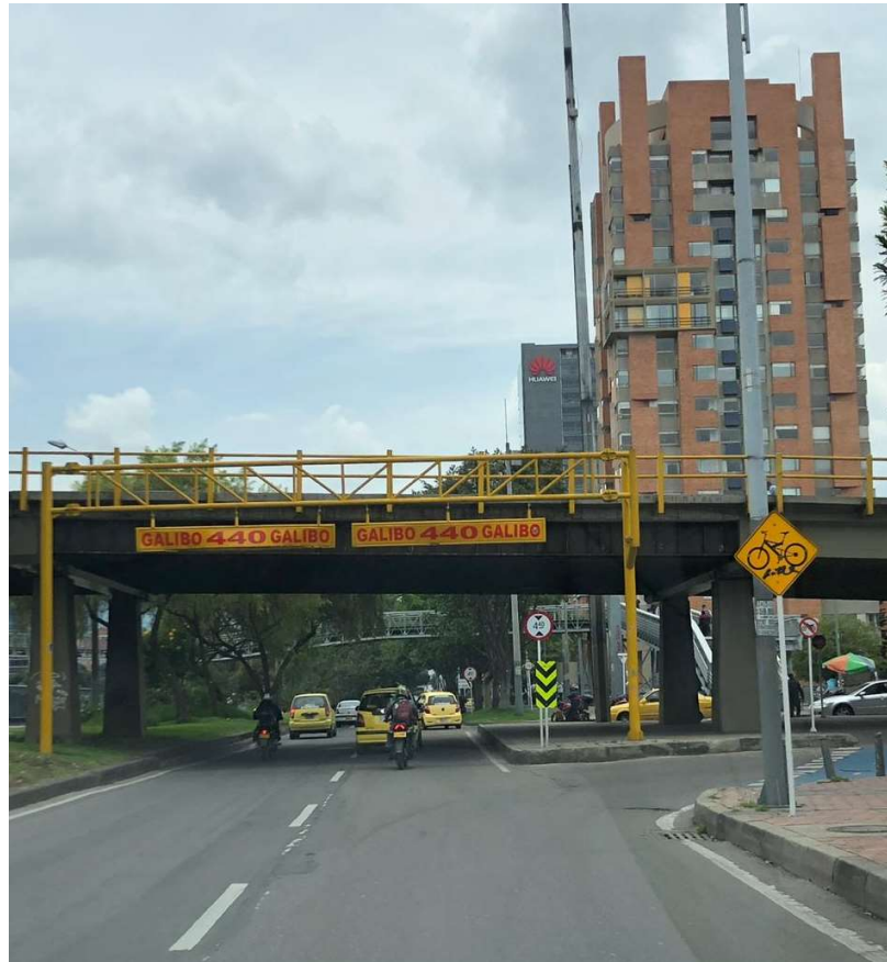
Figura 97. Pórtico calzada lenta autopista norte (archivo propio)
