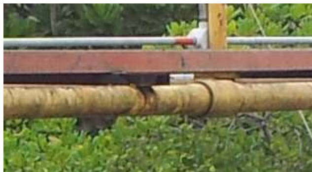
Figura 144. Detalle empalme perfil principal plataforma (archivo contratista)
