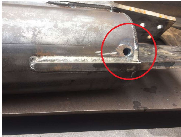
Figura 175. Perforación para drenaje realizada en sitio (archivo propio)
