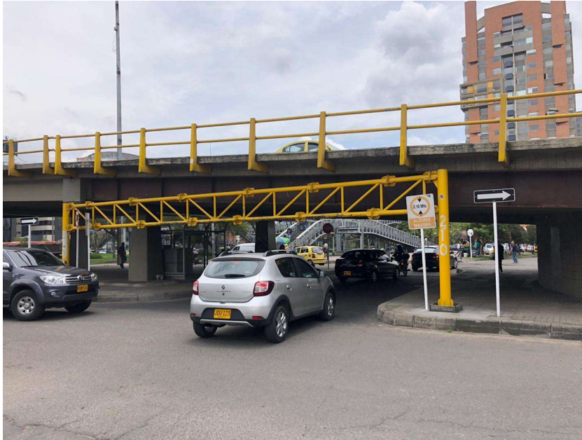
Figura 98. Pórtico cruce diagonal 117 (archivo propio)
