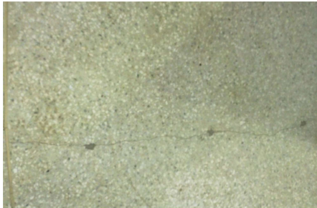
Figura 59. Fisura con tratamiento previo - inyecciones (archivo propio)
