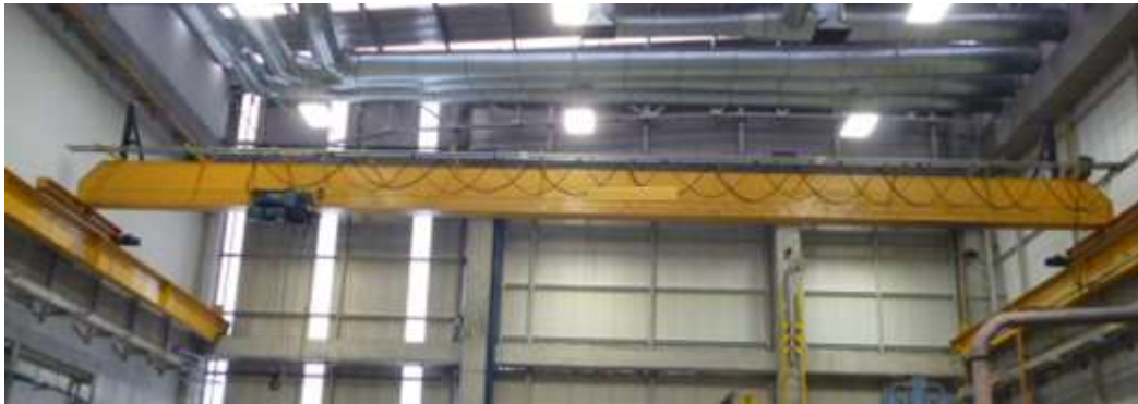
Figura 135. Vista general del puente grúa (archivo propio)
