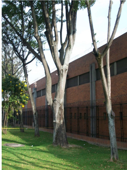
Figura 164. Árboles plantados cerca de la fachada (archivo parque industrial)
