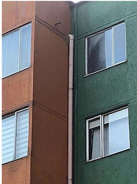
Figura 84. Reemplazo bajante aguas lluvias (archivo propio)
