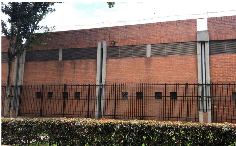
Figura 149. Fachada intervenida (archivo propio)
