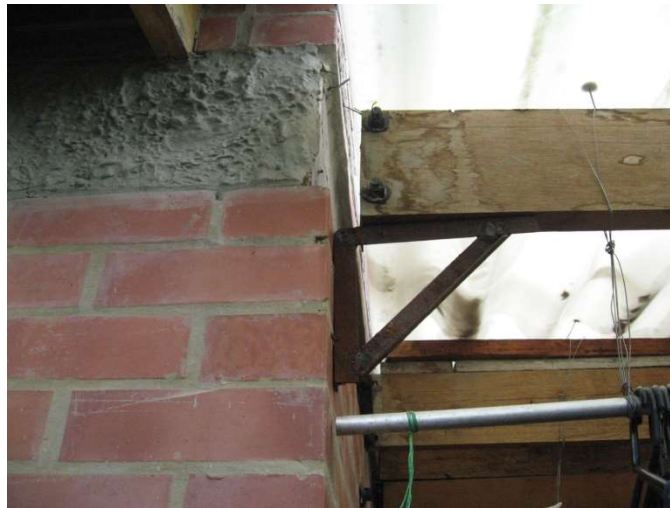
Figura 30. Apoyo temporal de correa de borde (archivo propio)
