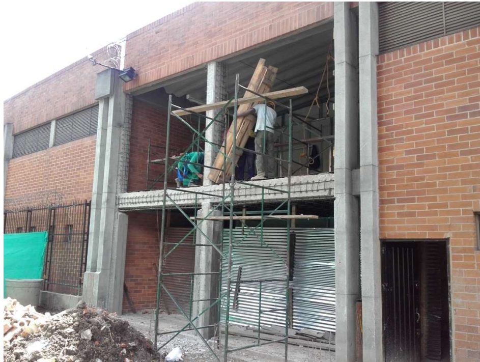
Figura 168. Actividades de reforzamiento de elementos de concreto reforzado (archivo parque industrial)
