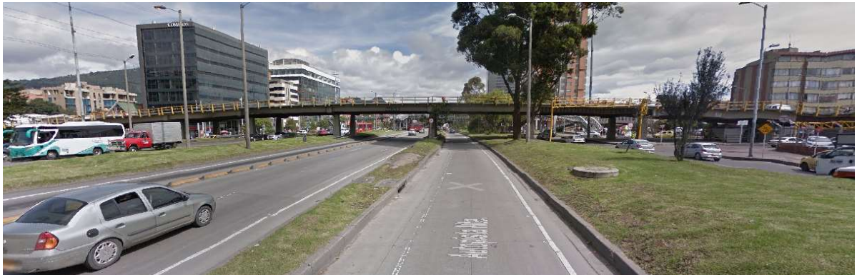
Figura 89. Vista general del puente (www.googlemaps.com)
