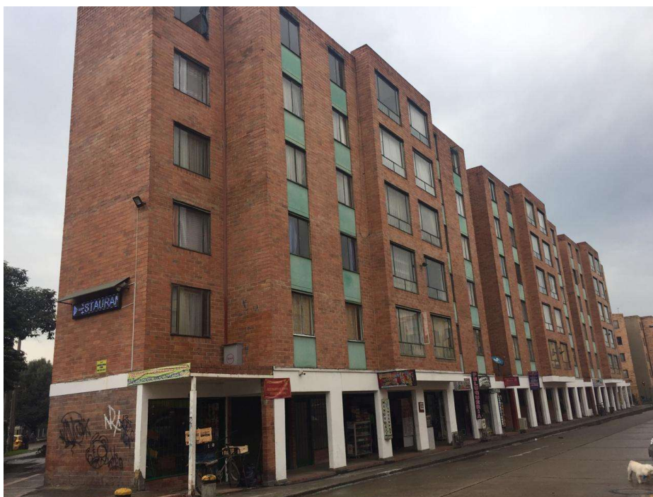
Figura 119. Vista general del edificio (archivo propio)
