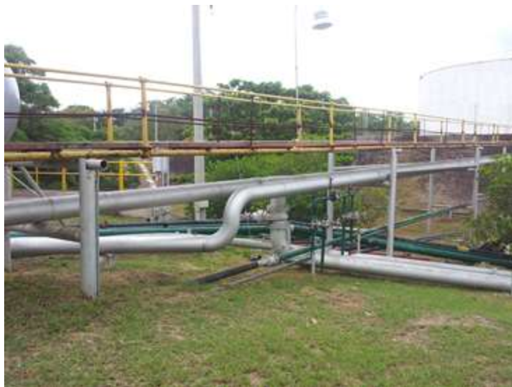
Figura 139. Puente peatonal acceso tanques (archivo contratista)
