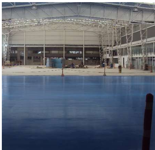
Figura 118. Instalación de pintura en pisos (archivo contratista)
