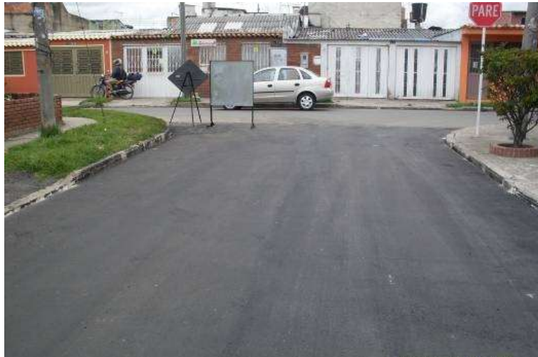
Figura 112. Segmento vial terminado (archivo propio)
