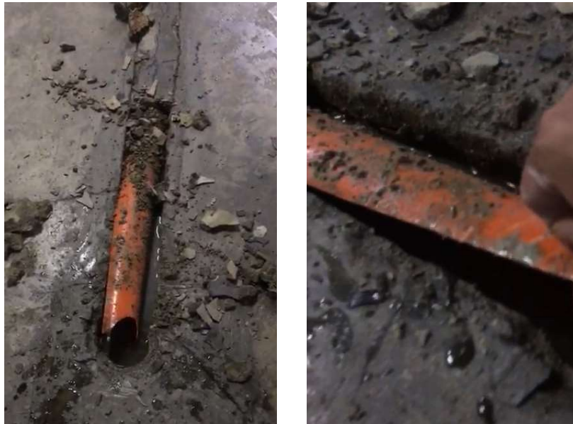
Figura 44. Regata en drenaje existente, drenajes conformados por medios tubos (archivo propio)
