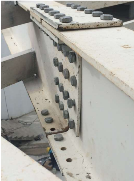
Figura 81. Conexiones incompletas (archivo propio)
