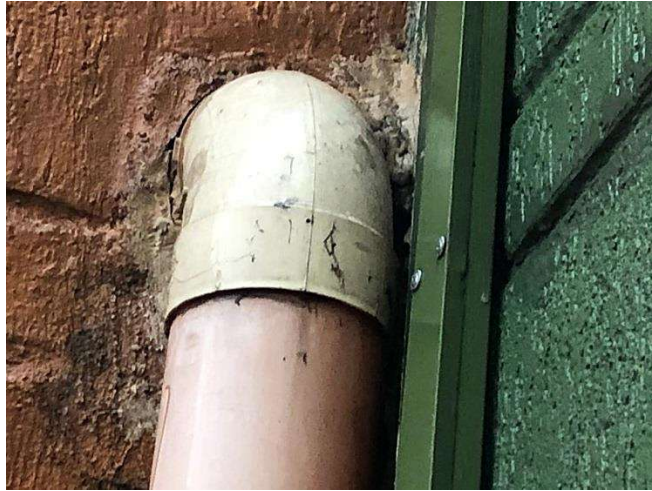
Figura 85. Conexión codo bajante (archivo propio)
