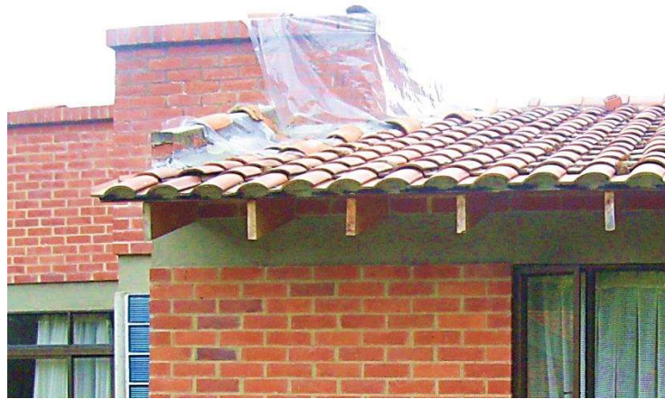
Figura 31. Gotera a lo largo de muro del baño (archivo propio)
