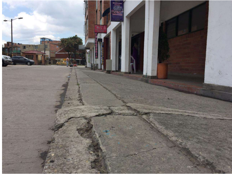
Figura 120. Detalle del asentamiento del edificio respecto al andén (archivo propio)
