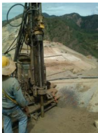
Fotografía 2.1. Perforación exploratoria. Fuente del autor.
