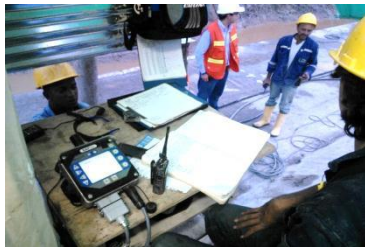
Fotografía 11.1. Inspector revisando los procedimientos de inyección. Fuente del autor
