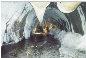
Fotografía 13.3. Flujos y avalanchas de material hacia la excavación en el túnel de fuga. Tomado de “Experiencias de excavación de túneles con métodos convencionales y maquinas TBM en la cordillera de los Andes. Casos históricos”. Marulanda, C. 2015.
