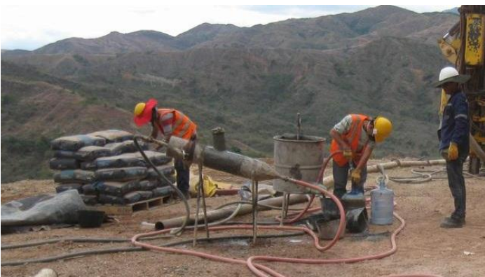
Fotografía 8.5. Preparación de la mezcla en el sitio con planta pequeña. Fuente del autor.
