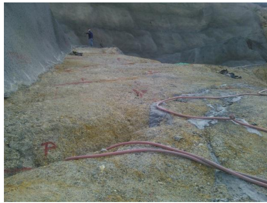
Fotografía 10.3. Cizallas rellenas con mezcla de inyección. Fuente del autor.
