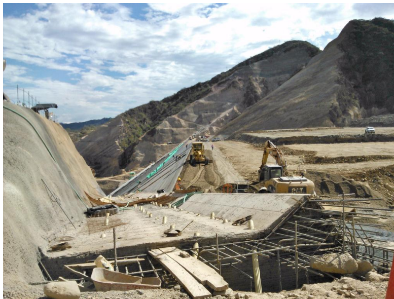
Fotografía 3.5. Ubicación de pasantes de PVC en plinto para la posterior perforación e inyección de los tratamientos con inyecciones desde el plinto.
