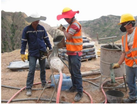
Fotografía 8.7. Mezcla preparada en el sitio vertiéndose en la bomba. Fuente del autor.
