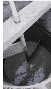
Fotografía 8.10. Mezcladora homogenizando la mezcla a base de cemento. Fuente del autor.
