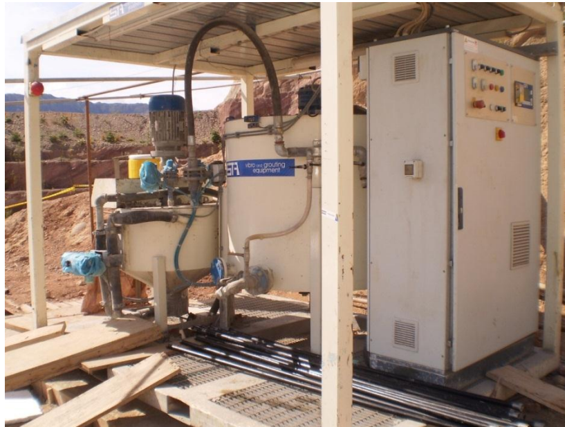
Fotografía 8.4. Planta modular de inyecciones. Fuente del autor.
