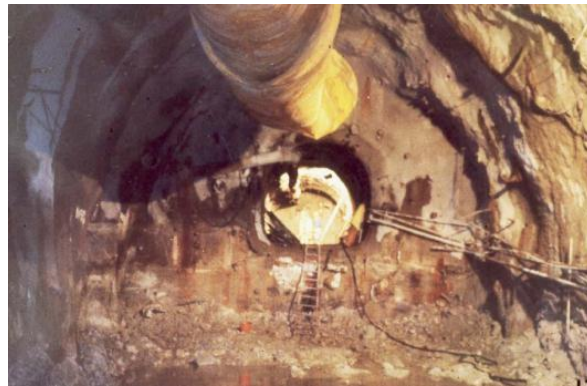
Fotografía 13.8. Excavación de galería piloto a través de estratos de arenisca friable. Tomado de “Experiencias de excavación de túneles con métodos convencionales y maquinas TBM en la cordillera de los Andes. Casos históricos”. Marulanda, C. 2015.
