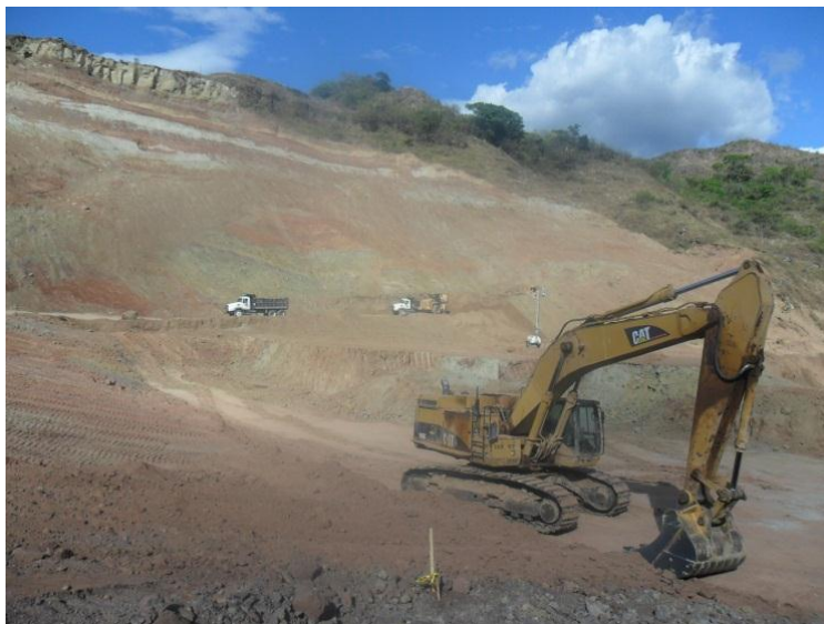
Fotografía 10.1. Preparación del terreno para ubicar las perforaciones del tratamiento. Fuente del autor.
