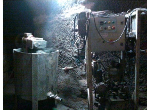
Fotografía 8.8. Planta pequeña de inyección en galería de inyección. Fuente del autor.
