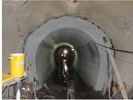
Fotografía 4.2. Inyecciones de contacto para rellenar espacios entre roca y revestimiento. Fuente del autor.
