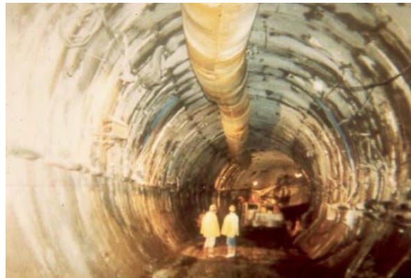
Fotografía 13.11. Excavación de la sección completa del túnel de fuga.
