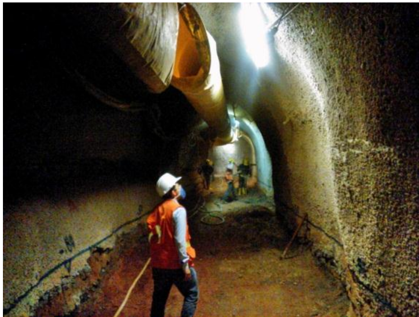
Fotografía 3.2. Excavación de galería de inyección y drenaje. Fuente del autor.
