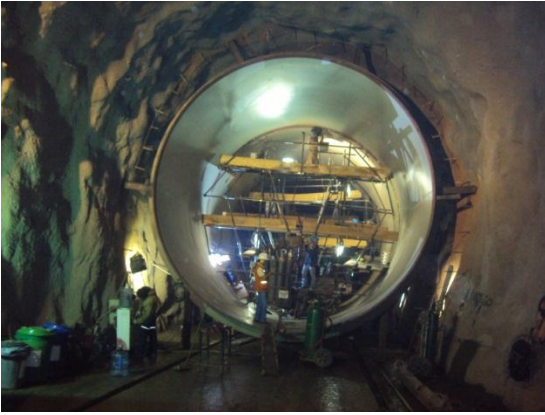
Fotografía 4.1. Inyecciones de contacto para rellenar espacios detrás de blindajes. Fuente del autor.
