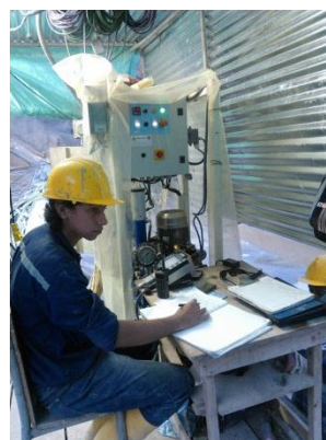
Fotografía 11.2. Inspector anotando en el libro de obra las novedades encontradas durante los procedimientos de inyección. Fuente del autor.
