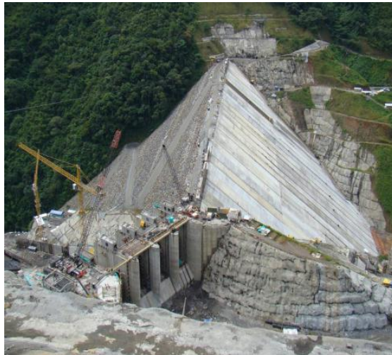
Fotografía 13.3. Presa CFRD Porce III. Tomado de “Descripción de obras Porce III”. EPM, 2019
