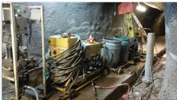
Fotografía 3.10. Equipos de inyección en Galería de inyección. Fuente del autor.
