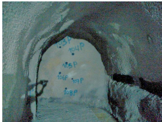
Fotografía 3.1. Ejemplo de continuidad del tratamiento con inyecciones en galería de inyección. Fuente del autor.
