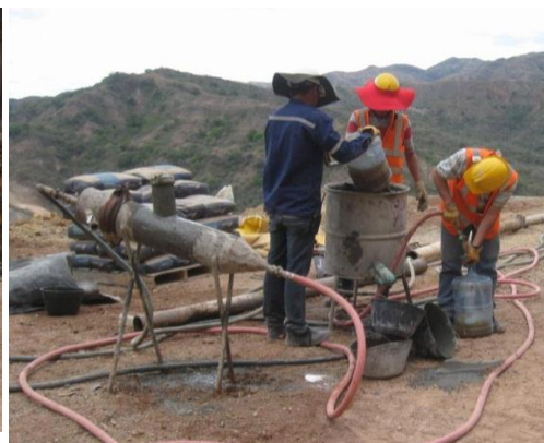
Fotografía 8.6. Adición de aditivos en la mezcladora. Fuente del autor.
