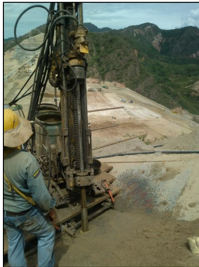
Fotografía 2.2. Perforación exploratoria. Fuente del autor.
