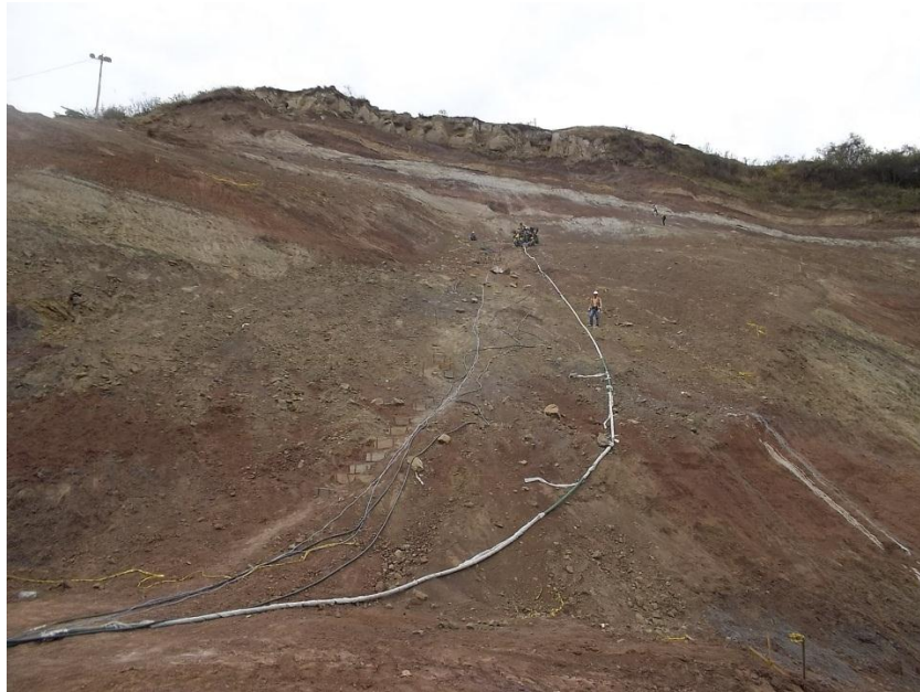
Fotografía 3.6. Trabajos de inyección en terrenos escarpados. Fuente del autor.
