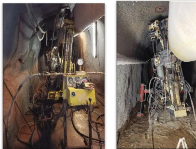
Fotografía 3.11. Equipos de perforación en la galería de inyección. Fuente del autor.
