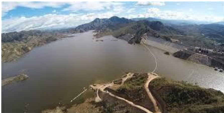
Fotografía 13.1. Presa CFRD El Quimbo. Tomado de “Periódico la buena energía de El Quimbo”. ENEL, 2019
