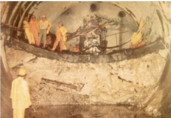
Fotografía 13.10. Excavación de la sección superior del túnel de fuga.
