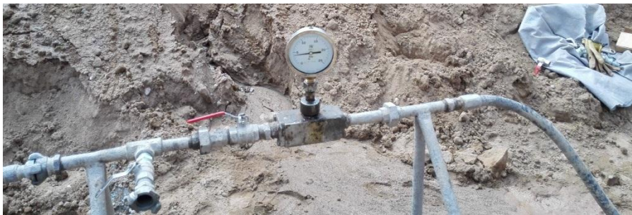
Fotografía 8.12. Manómetro durante procedimiento de inyección. Fuente del autor.
