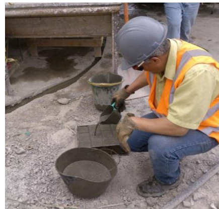
Fotografía 5.2. Preparación de los cubos en el sitio de inyección. Fuente del autor.
