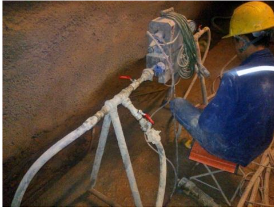
Fotografía 8.11. Cabezal de inyección durante procedimiento de inyección. Fuente del autor.
