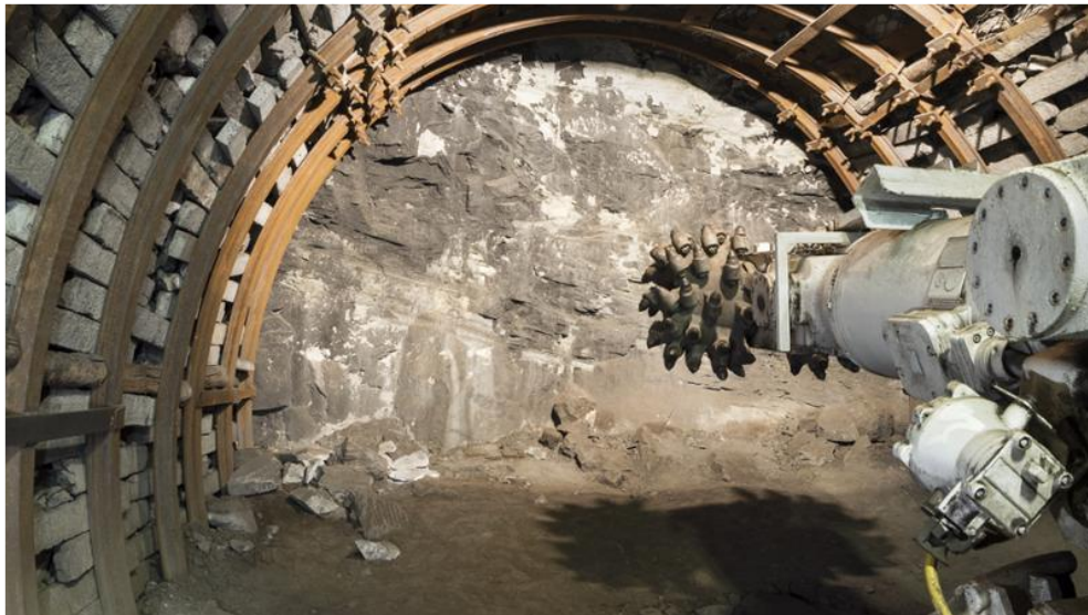
Ilustración 2 - 2: Sistema de perforación con rozadora. (www.structuralia.com).
