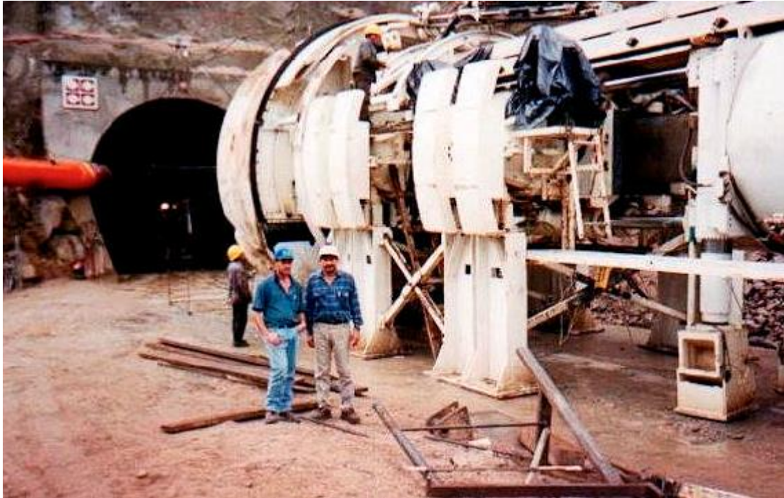
Ilustración 3 - 41: Fotografía de una TBM tipo Kelly MK 15" de la fábrica Robbins en Chimay. (Giraldo, 2010).
