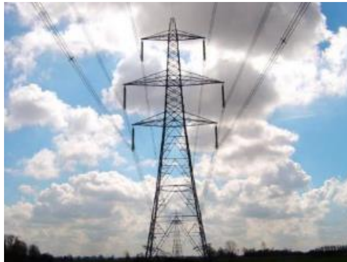
Figura 3. Torre rompe tramos Fuente: autor
