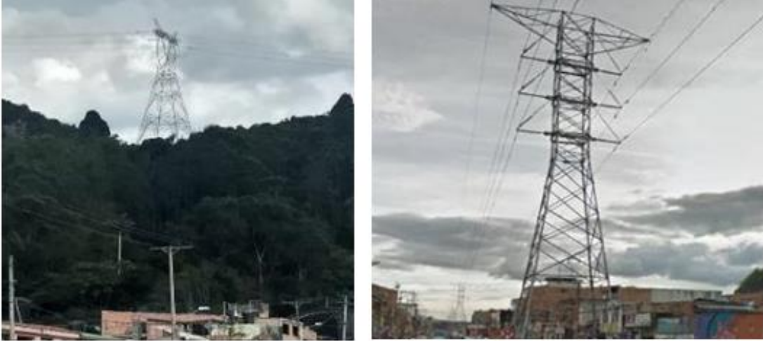
Figura 1. Torre de retención Fuente: autor
