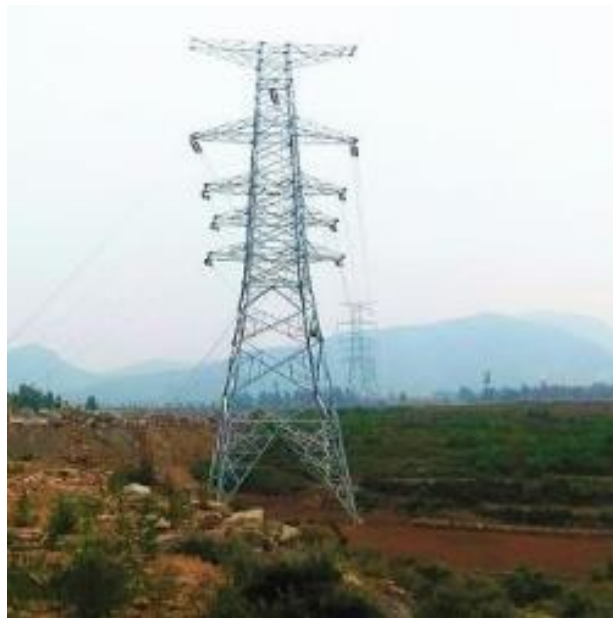
Figura 1. Torre terminal Fuente: autor
