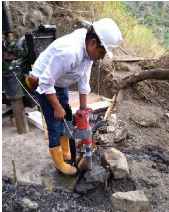
Foto 11. Extracción de núcleos de roca para caracterización físico-mecánica en laboratorio
