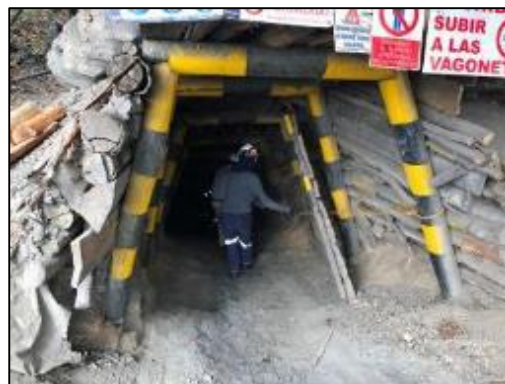
Foto 9. Entrada a las labores de explotación subterránea (bocamina).
