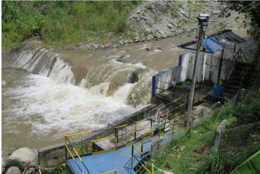
Fotografía 3. Estructura de captación a 2015.
