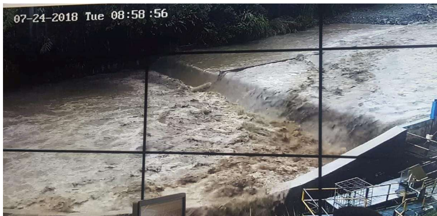
Fotografía 5. Suspensión del servicio por registro de nivel de turbidez de 38000 UNT en la Bocatoma Combeima 24/07/18.
