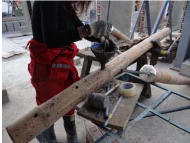
Fotografía 7.2 Proceso de relleno de los canutos.
