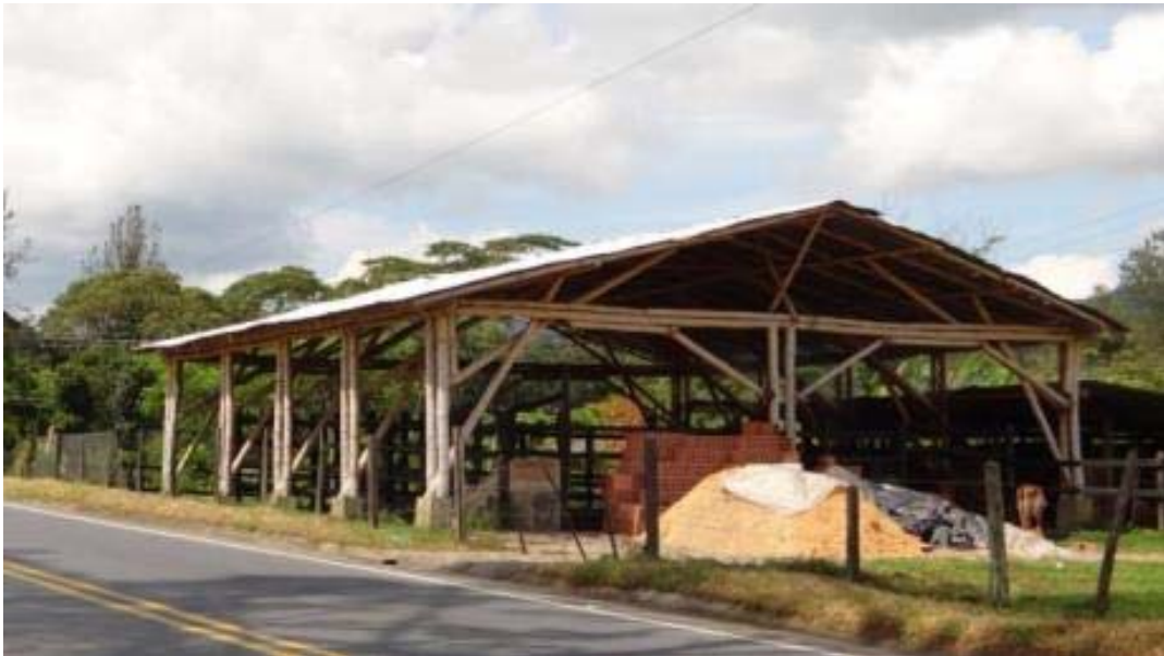
Fotografía 2.2. Edificaciones tradicionales en guadua.
