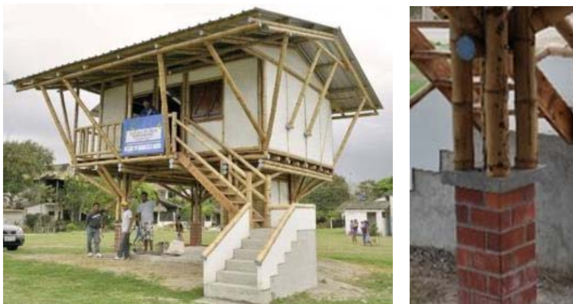
Fotografía 2.5 Estructura con columnas sin conexión rígida a su cimentación 2.
