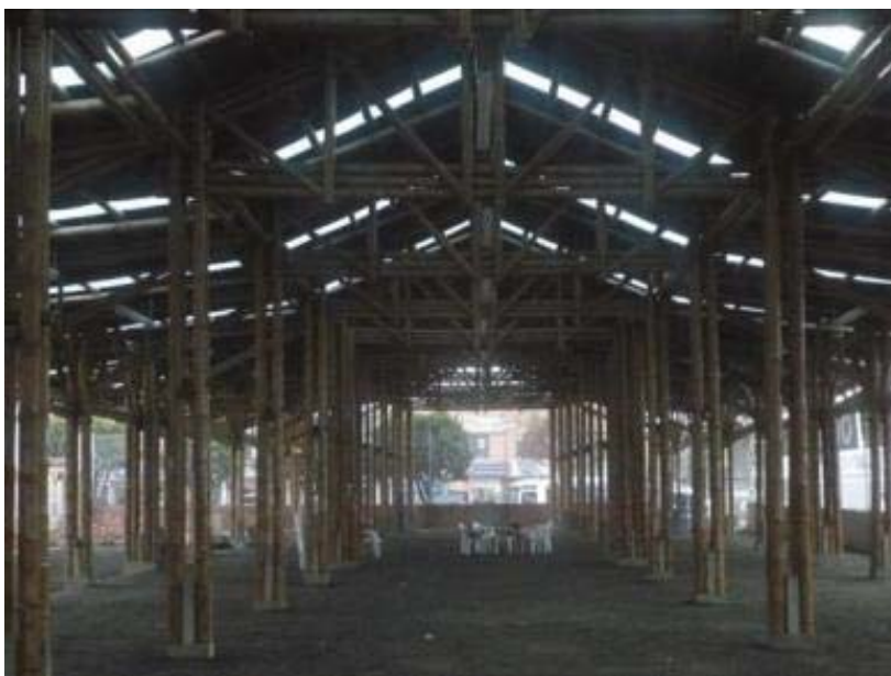
Fotografía 2.10 Estructura con conexión columna-cimentación aparentemente rígida 3.
