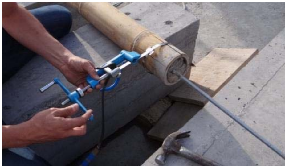
Fotografía 7.3 Proceso de tensionamiento del zuncho.
