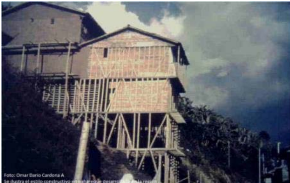
Fotografía 2.1. Edificación de bahareque.
