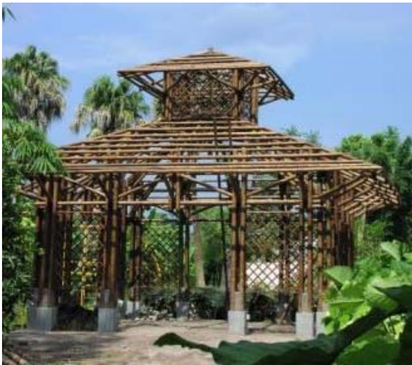
Fotografía 2.9 Estructura con conexión columna-cimentación aparentemente rígida 1.
