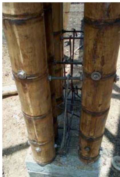
Fotografía 3.2 Conexión para restringir giros en la base de una columna de ocho culmos
