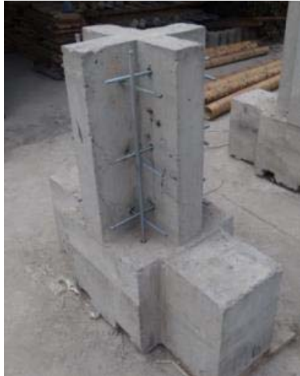
Fotografía 7.5 Localización de los pernos transversales y el perno longitudinal.
