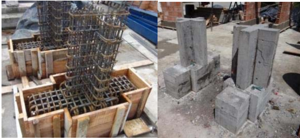
Fotografía 7.4 Proceso constructivo de las vigas de centrado y el pedestal.
