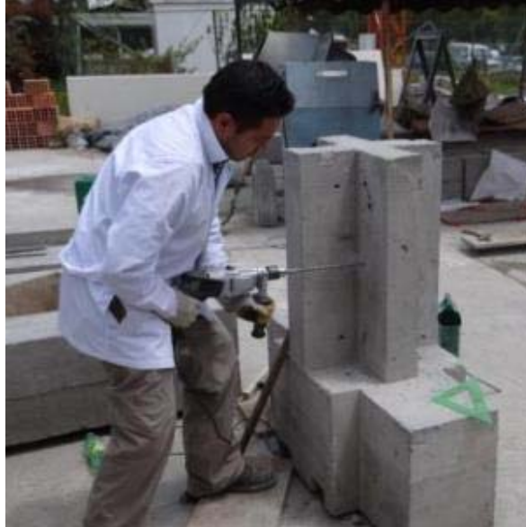
Fotografía 7.6 Abertura de pasos en el pedestal de concreto reforzado.
