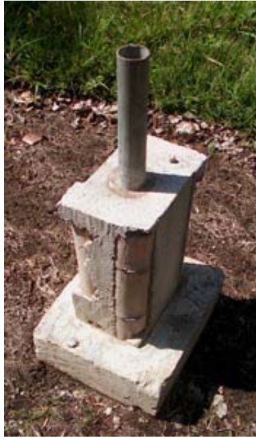
Fotografía 3.1 Conexión para restringir giros en la base de una columna de un solo culmo
