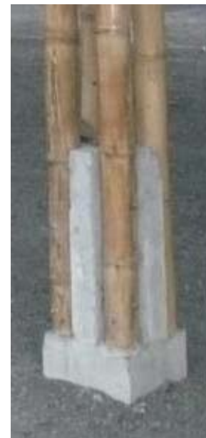
Fotografía 2.10 Estructura con conexión columna-cimentación aparentemente rígida 3.
