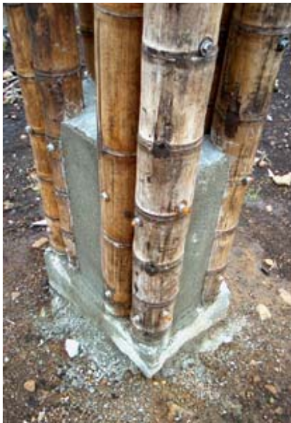
Fotografía 3.2 Conexión para restringir giros en la base de una columna de ocho culmos
