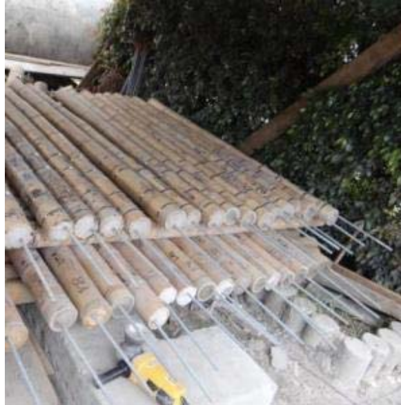
Fotografía 7.1 Culmos con perno longitudinal y rellenos de mortero.
