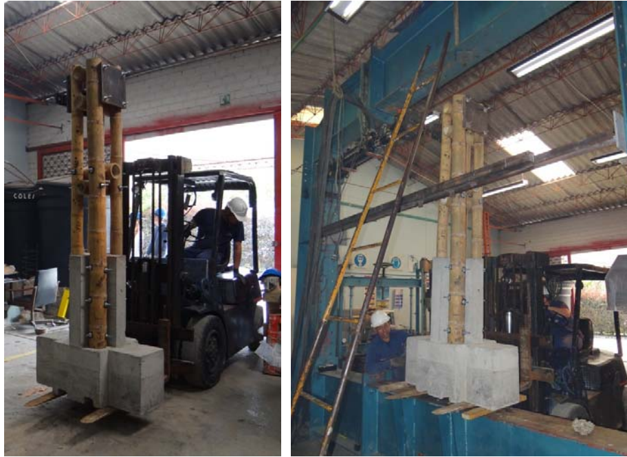
Fotografía 7.7 Montaje de los especímenes en el marco de carga.
