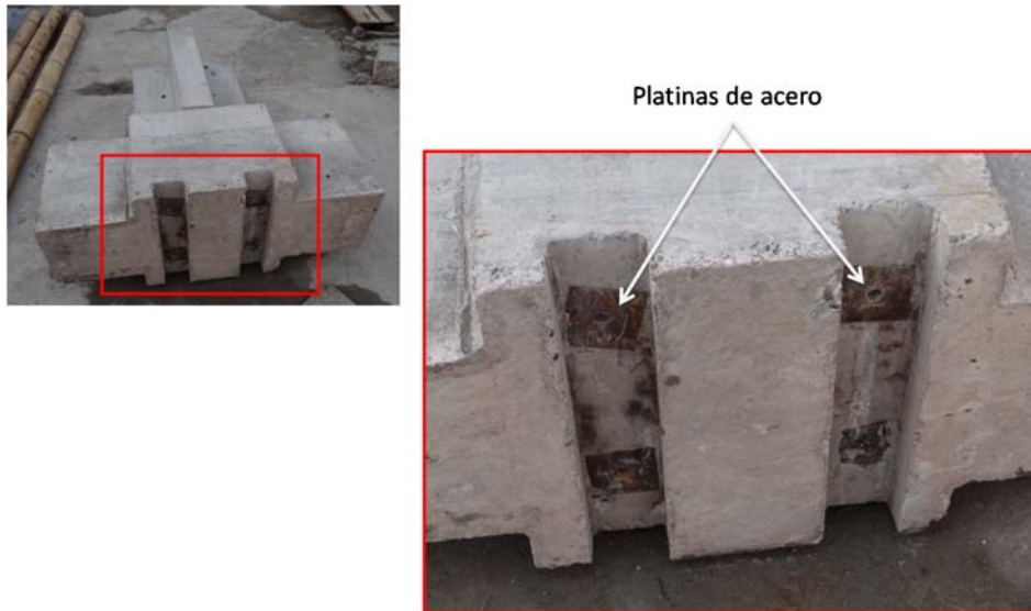
Figura 7.17 Platinas de acero en la base.
