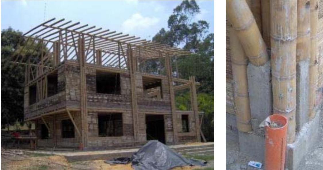
Fotografía 2.8 Estructura con conexión columna-cimentación aparentemente rígida 2.
