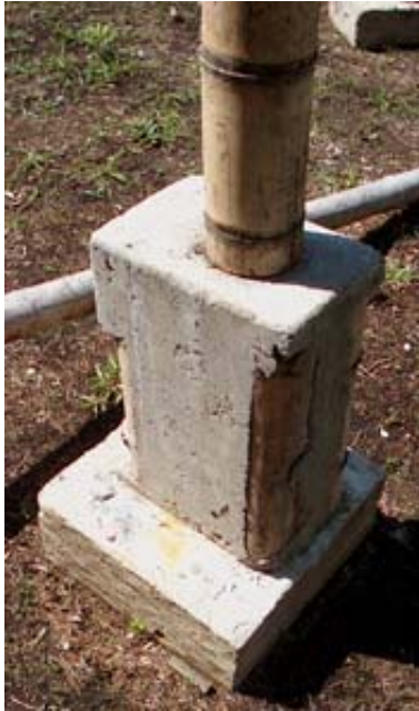
Fotografía 3.1 Conexión para restringir giros en la base de una columna de un solo culmo
