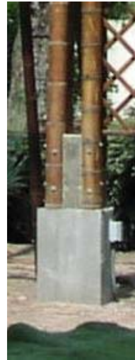
Fotografía 2.9 Estructura con conexión columna-cimentación aparentemente rígida 1.
