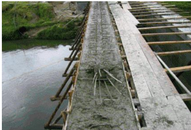
Figura 41. Fundición del concreto de alta resistencia de vigas. Fuente: reproducción autorizada para su publicación por (Fajardo, J., 2009).
