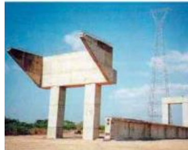
(a) Estiba y pilas del viaducto de la margen izquierda, es decir, del lado de Zambra.
