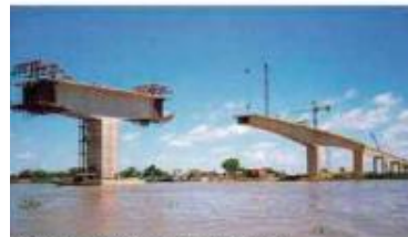
(f) Proceso de voladizos sucesivos de una de las tramos.
