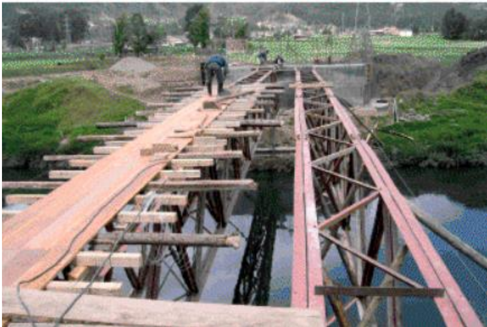
Figura 38. Adecuación de formaleta para la construcción de las vigas postensadas. Fuente: reproducción autorizada para su publicación por (Fajardo, J., 2009).
