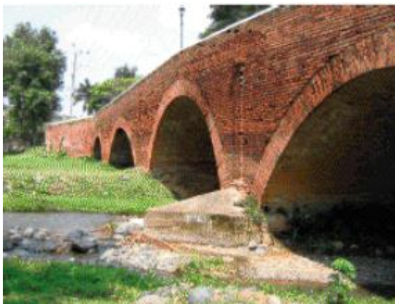
Figura 16. Puente sobre el río Guadalajara, en Buga, construido en 1874-1900. Fuente: reproducción autorizada por (Galindo J. y Paredes J., 2008)
