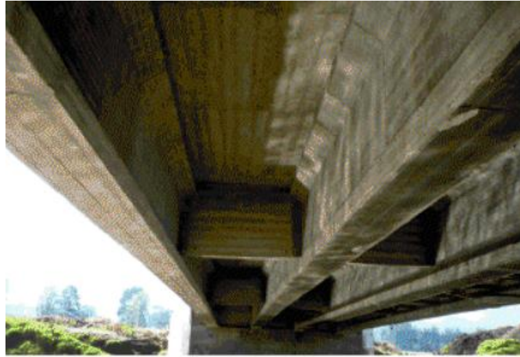
Figura 45. Terminación de vigas, riostras y losa.
