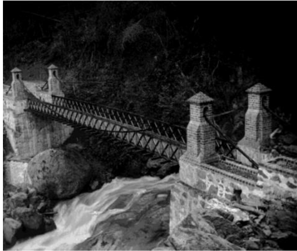
Figura 22. Puente Piedra (1919). Fotografía Rodríguez.
