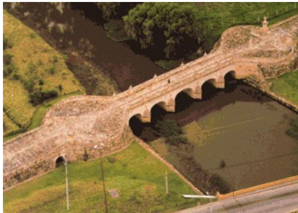
Figura 20. Puente de arco inferior cerrado-Puente El Común. Fuente: reproducción autorizada por (Cadavid M. y Eraso M., 2004)
