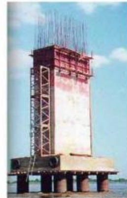
(d) Pila del eje 7 del viaducto, ubicado en la margen derecha.
