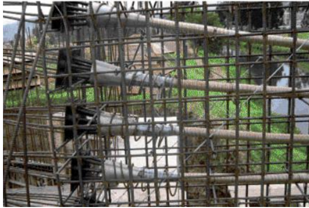
Figura 40. Instalación de cables de postensado para el primer tensionamiento en sección simple Zona de anclajes. Fuente: reproducción autorizada para su publicación por (Fajardo, J., 2009).
