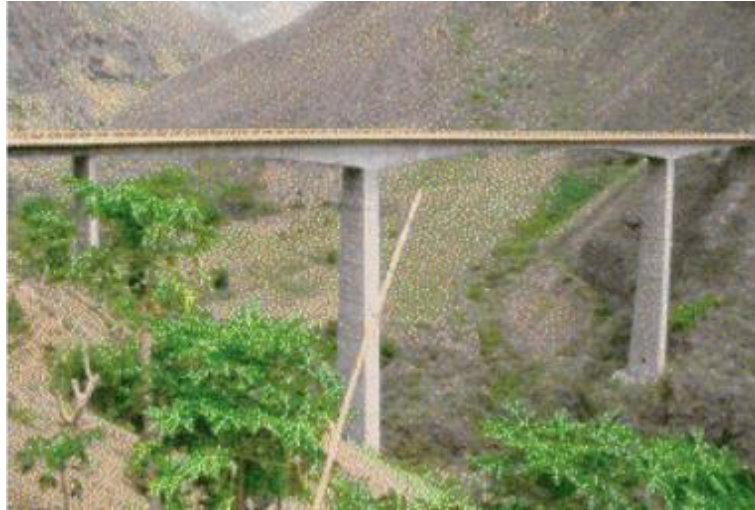
Figura 64. Puente en voladizo sucesivos, Juanambú. Carretera Popayan-Pasto. Regional Nariño.
