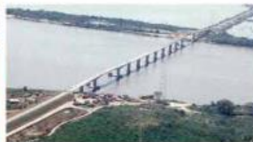
(i) Puente terminado en 1997.
