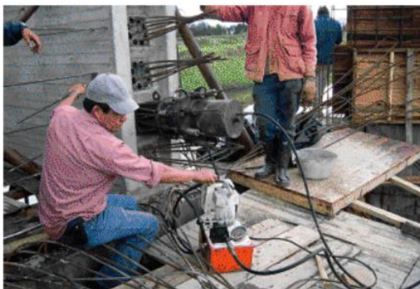
Figura 42. Primer tensionamiento de cada una de las vigas después del fraguado de su concreto.
