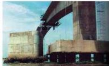
(e) Pila terminada y avance de la superestructura.
