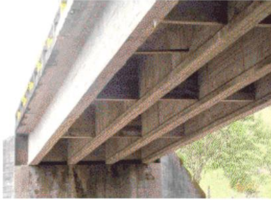
Figura 32. Superestructura de viga y losa en concreto reforzado. Regional Caquetá. Fuente: (Muñoz, E., 2011)
