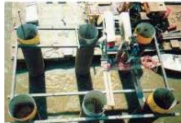
(b) Proceso de bizado de los pilotes. Se observa la formata perdida.
