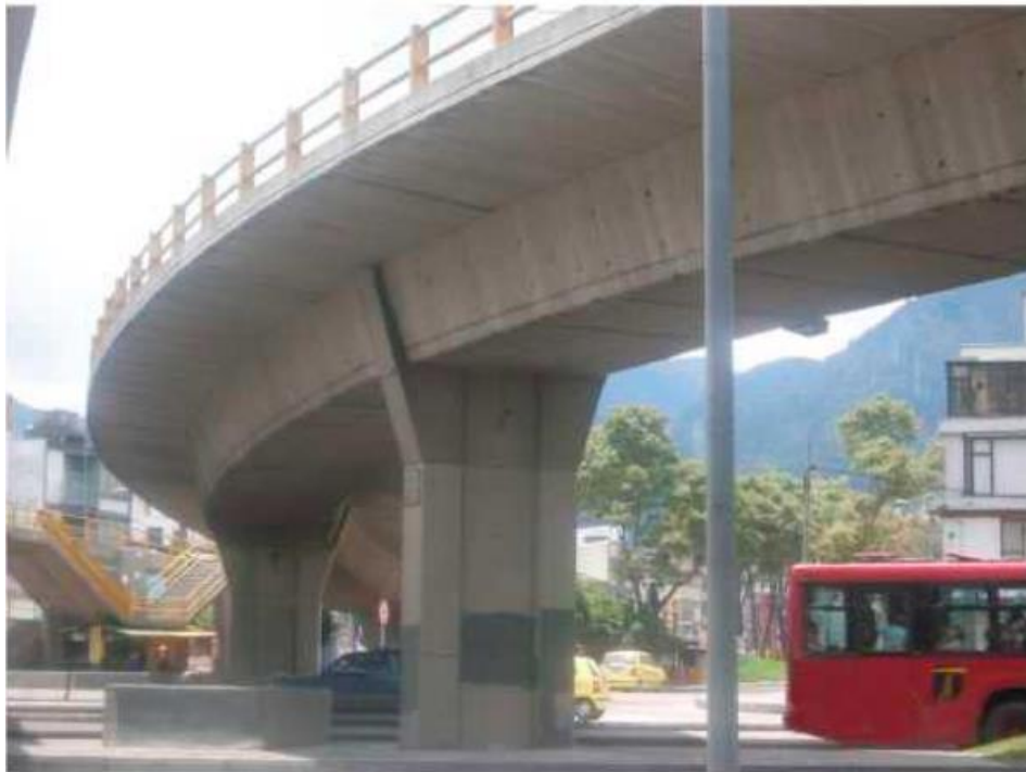
Figura 48. Puente viga cajón en concreto. Puente calle 45 con carrera 30 - Bogotá. Fuente: (Muñoz, E., 2011)
