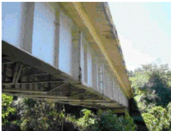
Figura 34. Superestructura de viga y losa de sección mixta en acero y concreto. Regional Boyacá. Fuente: (Muñoz, E., 2011)
