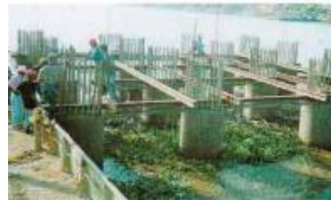
(c) Pilotes fundidos de una de las pilas.
