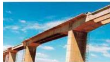
(h) Vigas-Gerbrer postensadas.
