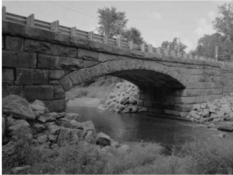
Figura 4. Norman, James (2000). Puente Long-Allen Texas.
