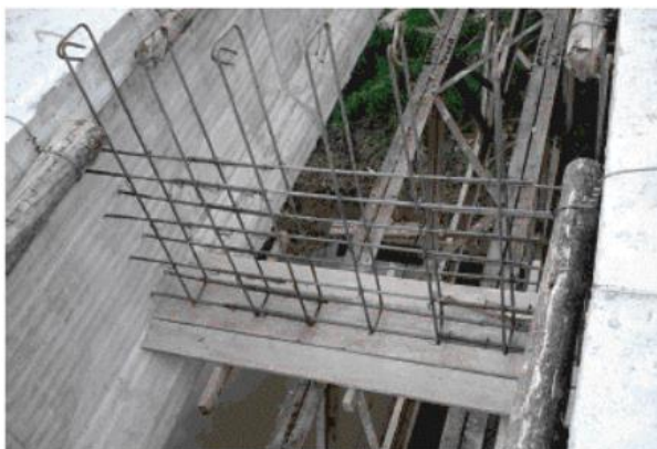
Figura 43. Construcción de vigas riostras con su correspondiente refuerzo.
