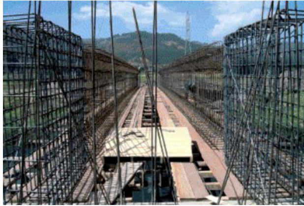
Figura 39. Armado del refuerzo pasivo de vigas. Contienen refuerzo a cortante (flejes) y flexión (longitudinal), en el centro de la luz y en el bloque de anclaje. Fuente: reproducción autorizada para su publicación por (Fajardo, J., 2009).
