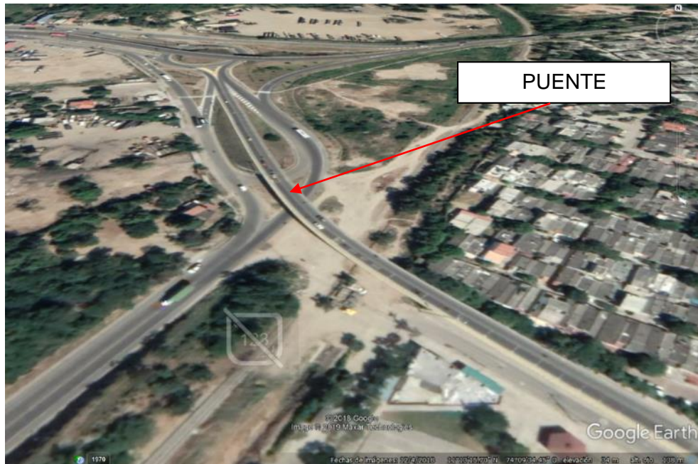
Figura 93. Vista detallada del puente vía a Minca.
