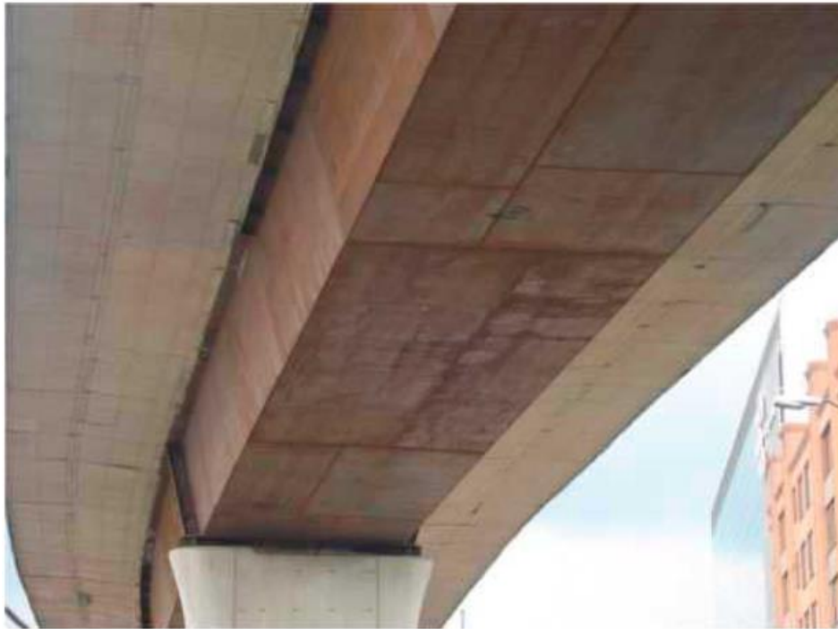
Figura 47. Puente viga cajón en acero curva con losa en concreto reforzado. Calle 93 con Autopista Norte - Bogotá. Fuente: (Muñoz, E., 2011)
