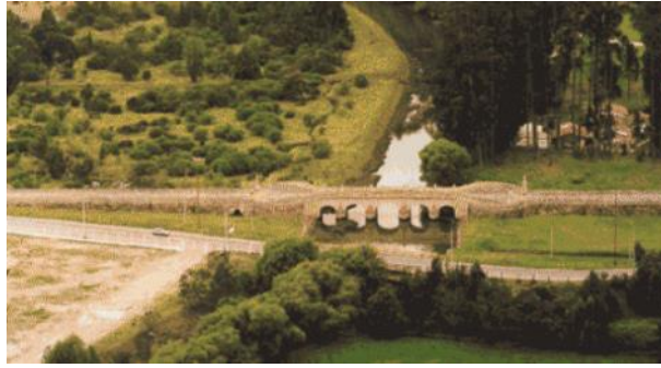
Figura 19. Puente de arco inferior cerrado-Puente El Común. Fuente: reproducción autorizada por (Cadavid M. y Eraso M., 2004)
