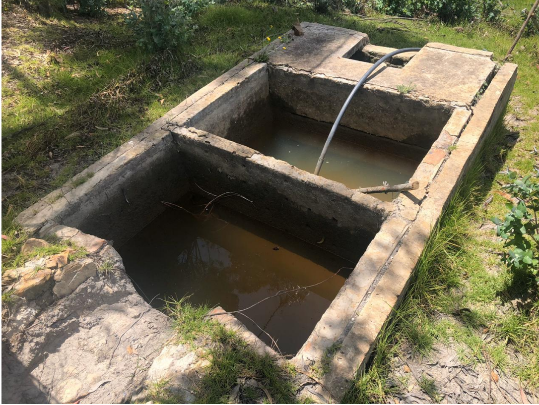
Ilustración 12 Tanque de sedimentación secundaria
