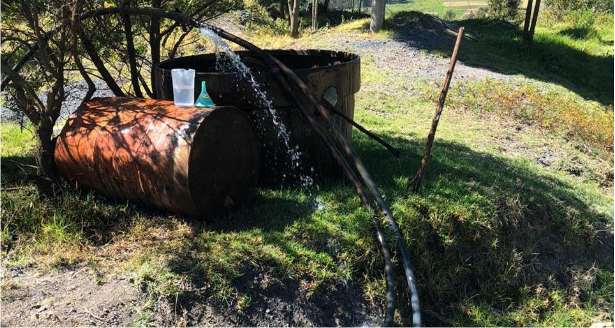
Ilustración 11 Tanque de sedimentación primaria
