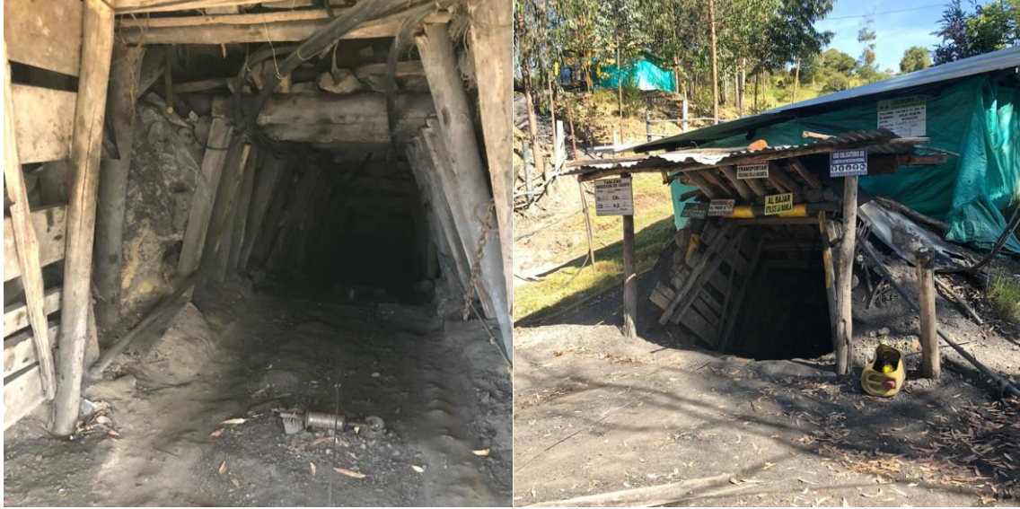
Ilustración 5. Entrada al socavón
