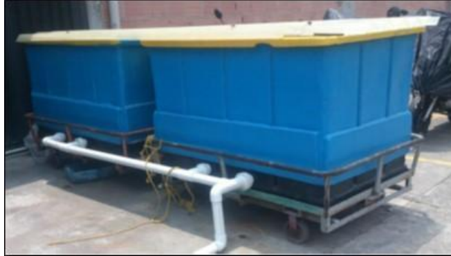
Figura 10 Lechos de Secado, (Fuente: Manual de operaciones planta ASITEX)
