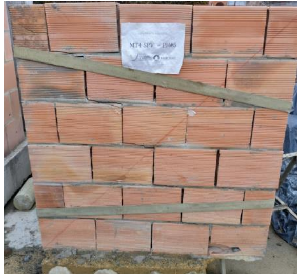
Figura 88. Falla global de murete por compresión diagonal.
