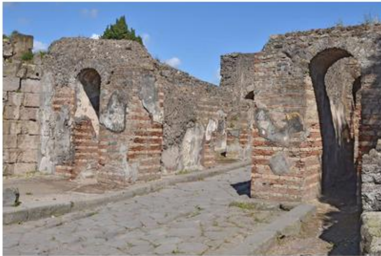
Figura 36. Baños de Caracalla en Roma contruidos con mampostería. Tomado de: https://brickarchitecture.com/about-brick/why-brick/the-history-of-bricks-brickmaking
