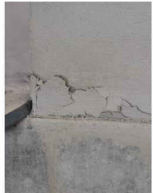
Figura 102. Fisuración en base del muro por ausencia de anclaje; falla por compresión en pañete – MSP2.
