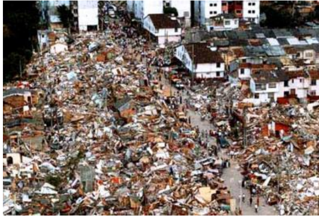
Figura 12. Vista panorámica de la destrucción generada por el terremoto del Eje Cafetero. Tomado de: https://www.elspectador.com/noticias/nacional/se-conmemoran-15-anos-del-terremoto-de-armenia-articulo-470817
