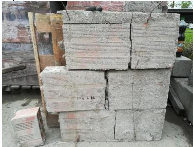
Figura 69. Murete de mampostería no reforzada existente.
