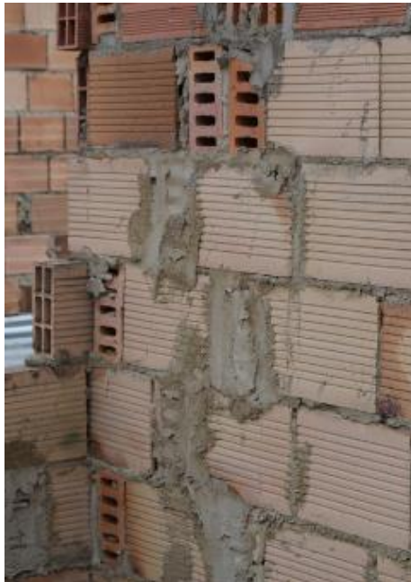
Figura 30. Muro divisorio en vivienda de Bogotá. Foto del autor.
