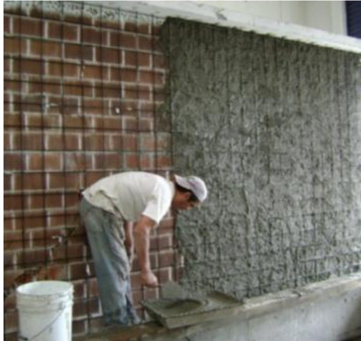
Figura 60. Reforzamiento de muro empleando sistema de mortero y malla electrosoldada (Carrillo, Pincheira, & Flores, 2020).
