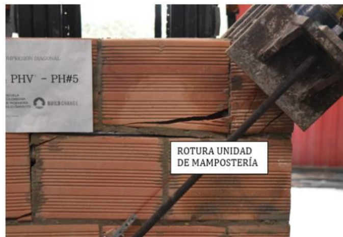
Figura 89. Rotura de unidad de mampostería por compresión diagonal.
