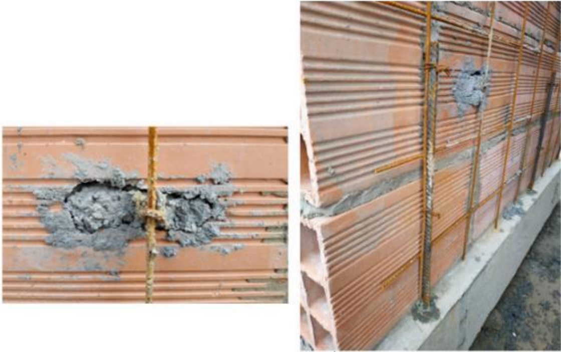
Figura 74. Anclajes para muros reforzados con malla electrosoldada.
