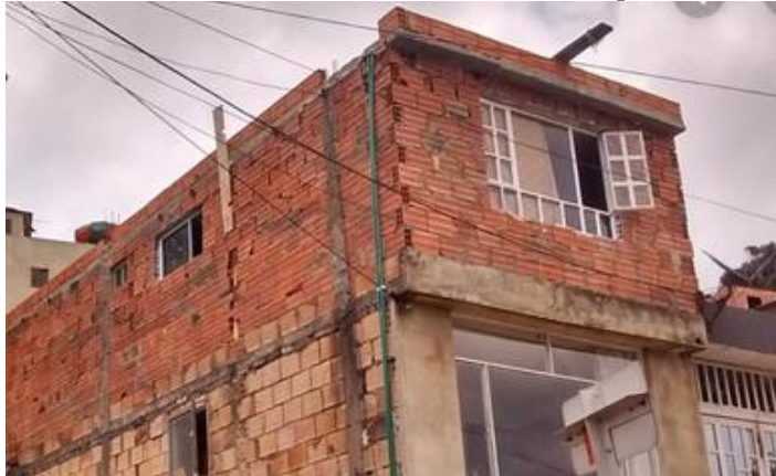
Figura 29. Vivienda construida en MNR. Tomado de: http://edificacionesdecalidad.com/autoconstrucci%C3%B3n-alba%C3%B1iler%C3%ADa-sismorresistente
