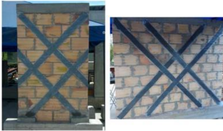
Figura 56. Muros reforzados empleando sistema de FRP con configuración de diagonales (Vega, 2015).
