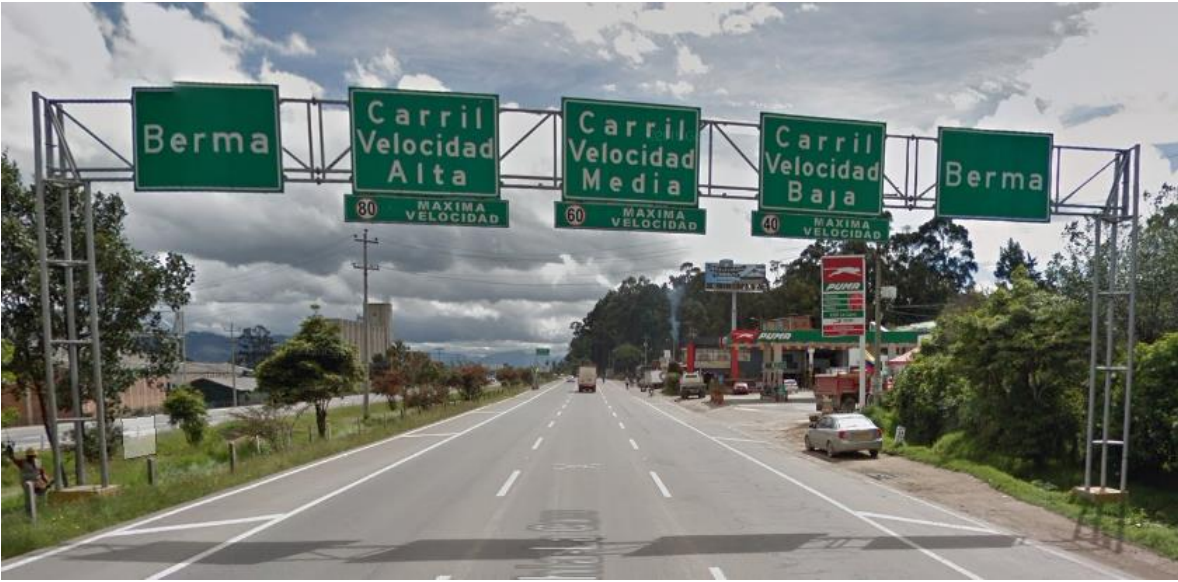
Figura 14 Caso 2 – Pórtico de señales
