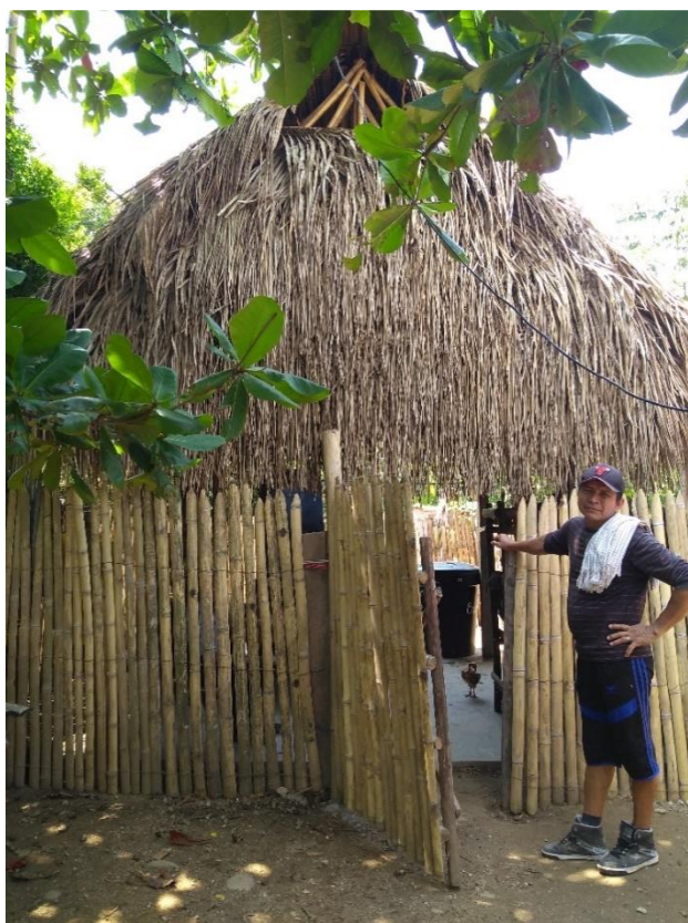
Fotografía 51. Fachada principal cocina M.C.
