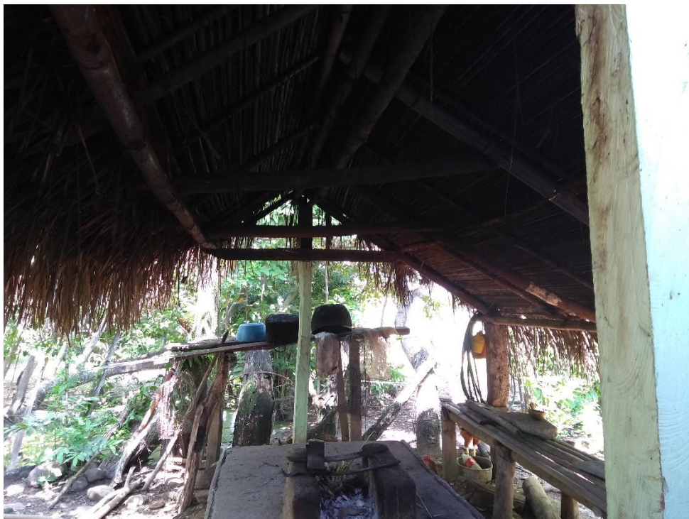
Fotografía 46. Fachada principal cocina de A.L. Y A.M.
