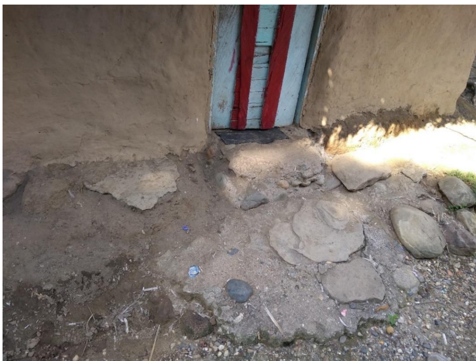
Fotografía 95. Empedrado entrada de casa de E.D.
