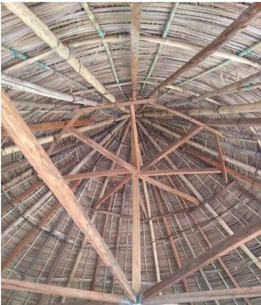
Fotografía 107. Estructura interior de quiosco de Y.D.
