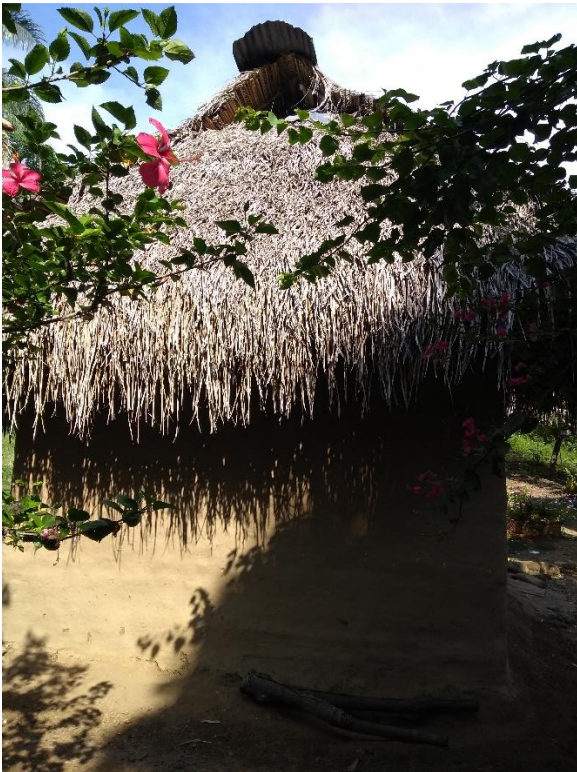
Fotografía 97. Fachada izquierda de casa de E.D.
