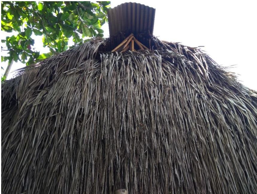
Fotografía 49. Techo en empalmado cocina M.C.
