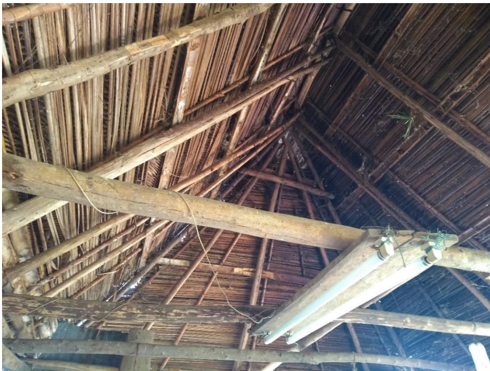
Fotografía 5. Techo empajado Casa de R.C.
