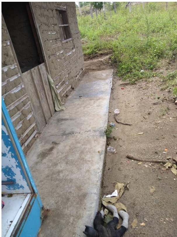
Fotografía 18. Andén en concreto casa de R.C.
