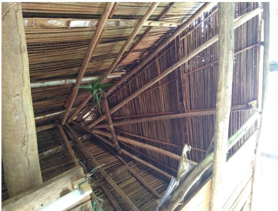
Fotografía 2. Techo en empajado Casa de R.C.
