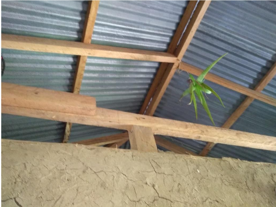
Fotografía 28. Techo en zinc de R.C.
