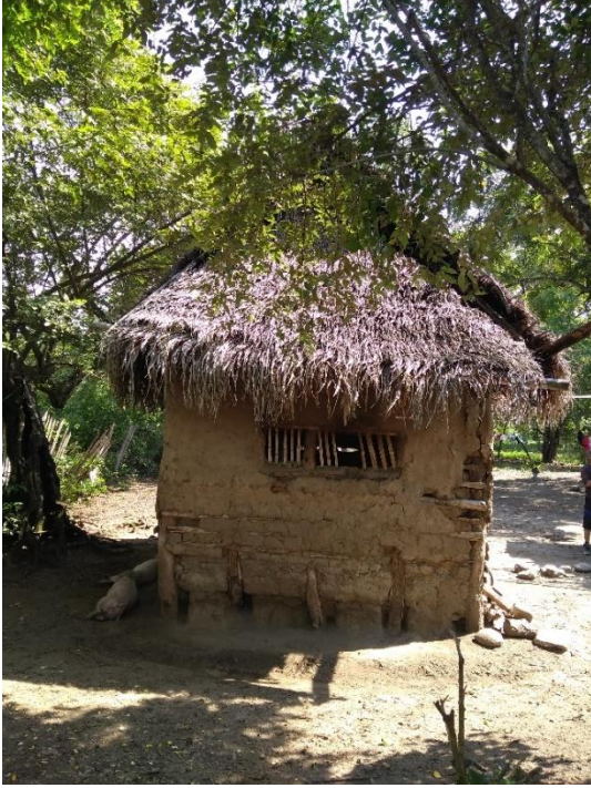
Fotografía 70. Fachada lateral izquierda de E.C.D.
