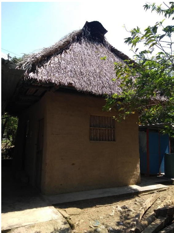
Fotografía 57. Fachada lateral derecha casa Y.M.
