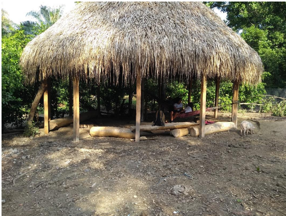
Fotografía 110. Fachada quiosco de Y.D.
