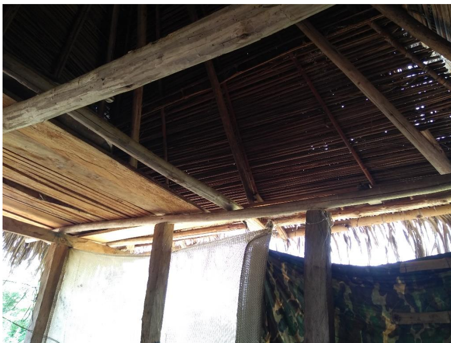
Fotografía 3. Techo empajado Casa de R.C.
