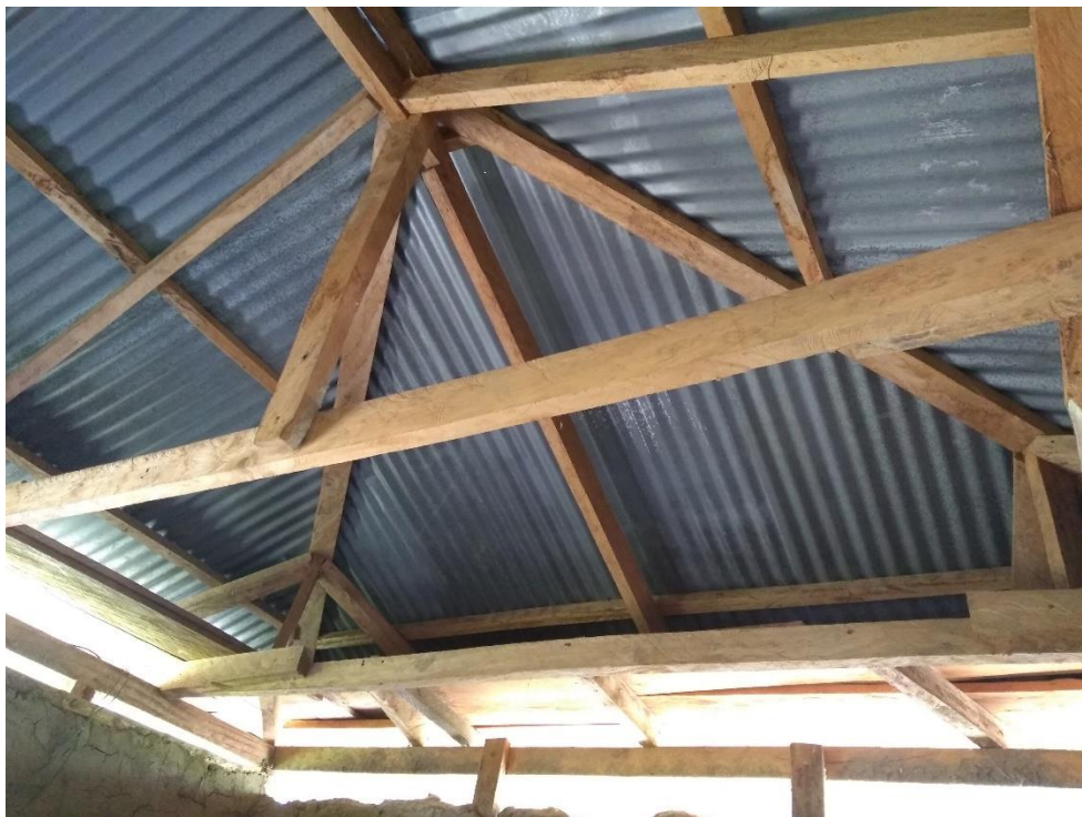
Fotografía 26. Techo en zinc de R.C.
