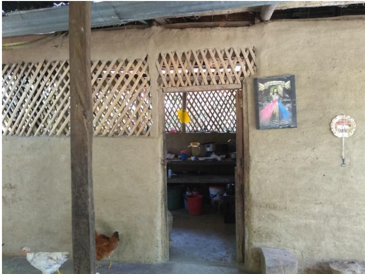
Fotografía 56. Fachada principal casa Y.M.
