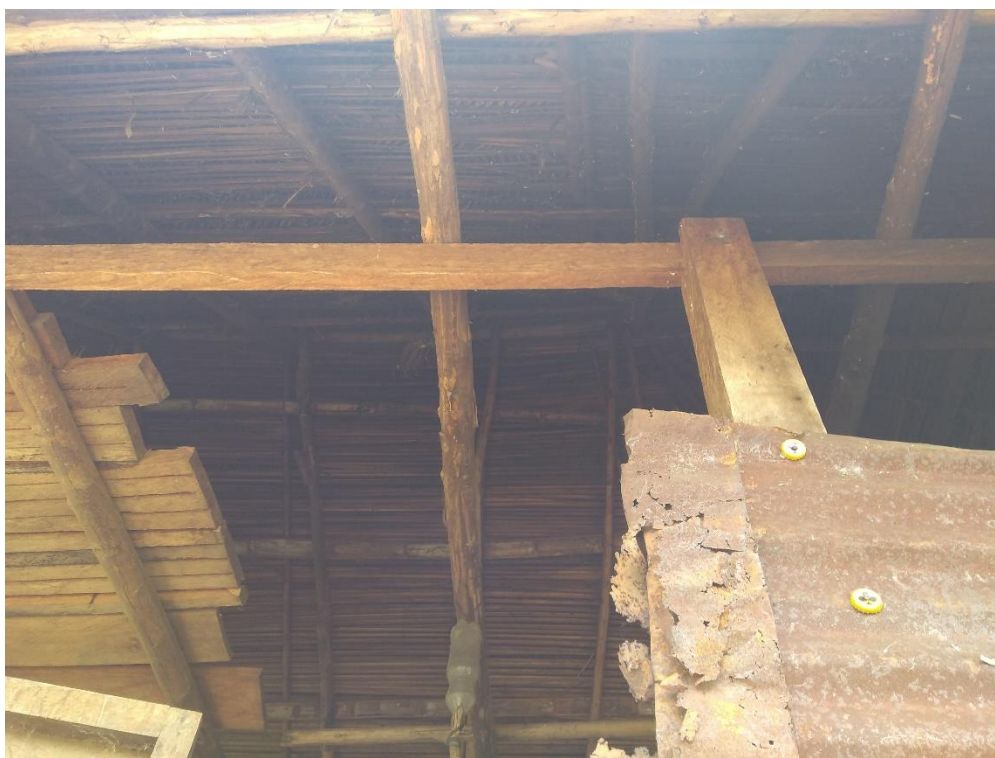
Fotografía 15. Techo empajado Casa de R.C.
