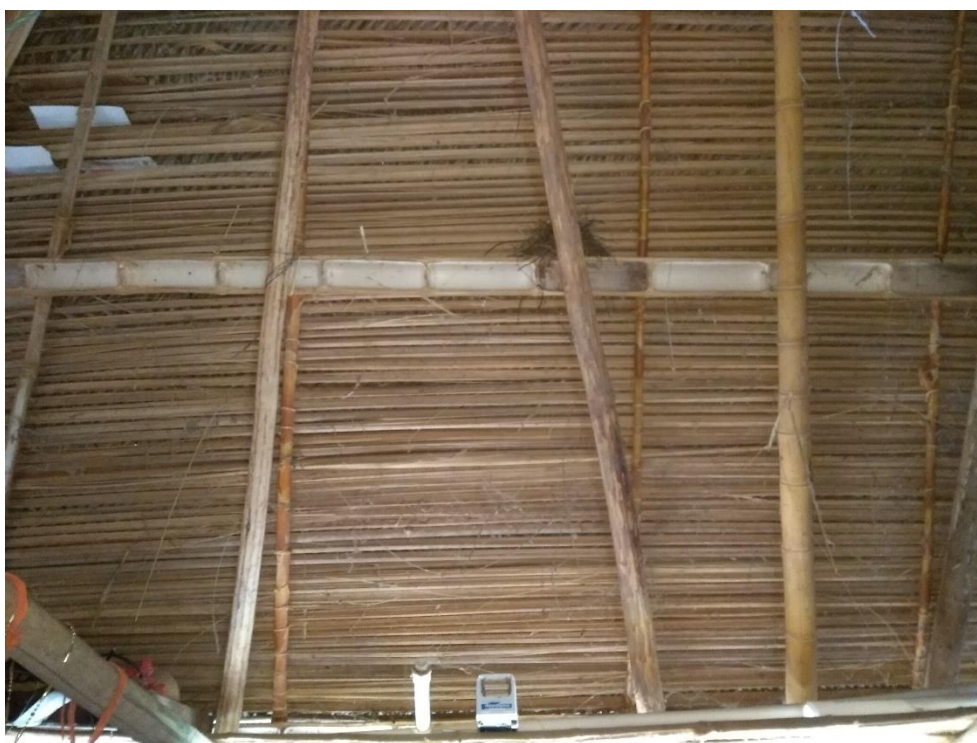
Fotografía 103. Techo en empalmado casa de E.D.
