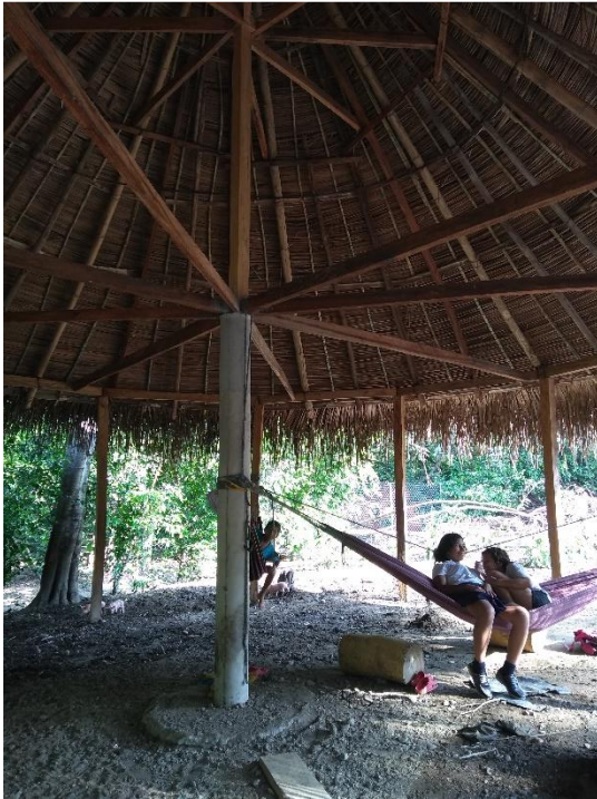
Fotografía 108. Estructura interior de quisco de Y.D.
