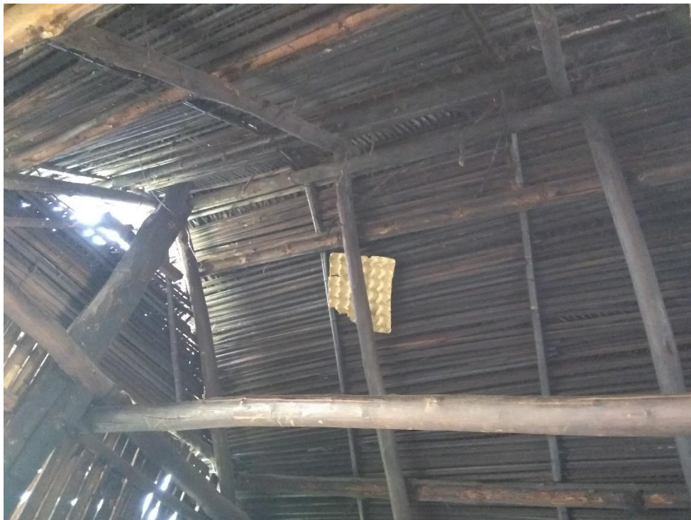
Fotografía 38. Techo en empalmado casa de L.B.C.
