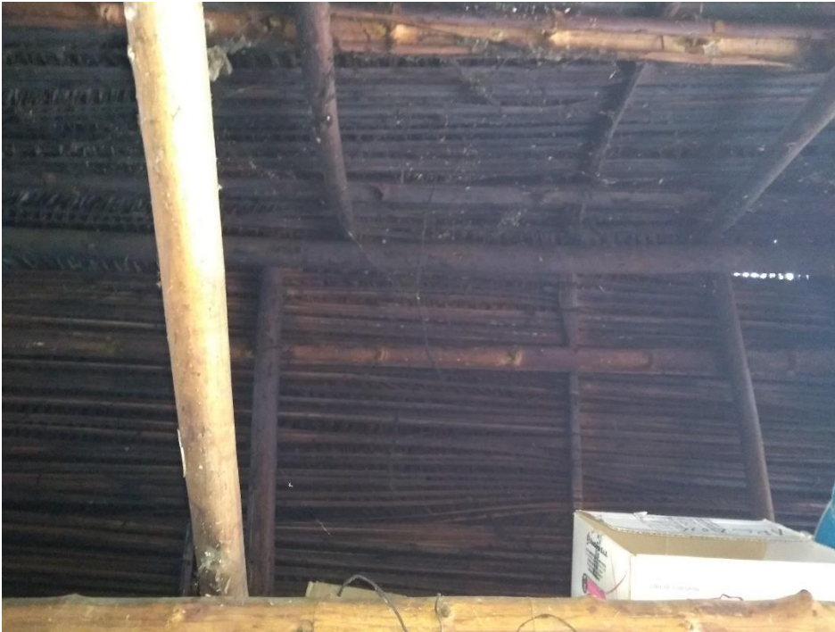
Fotografía 41. Techo en empalmado casa de L.B.C.
