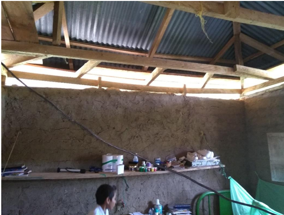
Fotografía 1. Techo en zinc de R.C.
