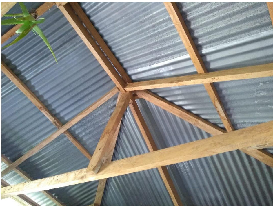
Fotografía 27. Techo en zinc de R.C.
