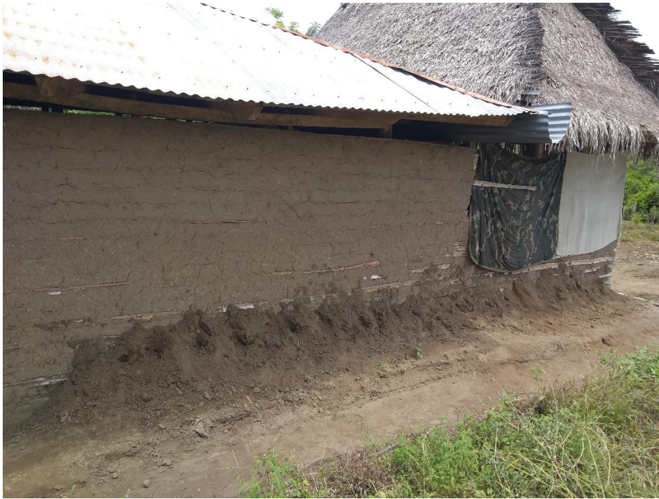
Fotografía 20. Andén en tierra casa de R.C.
