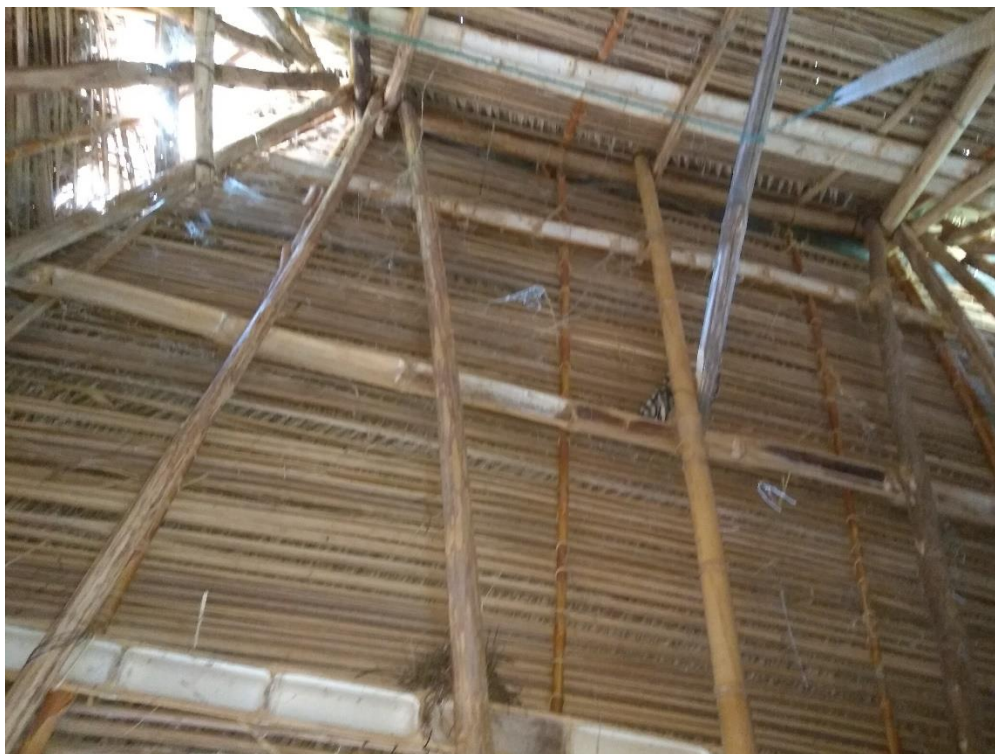
Fotografía 102. Techo en empalmado casa de E.D.
