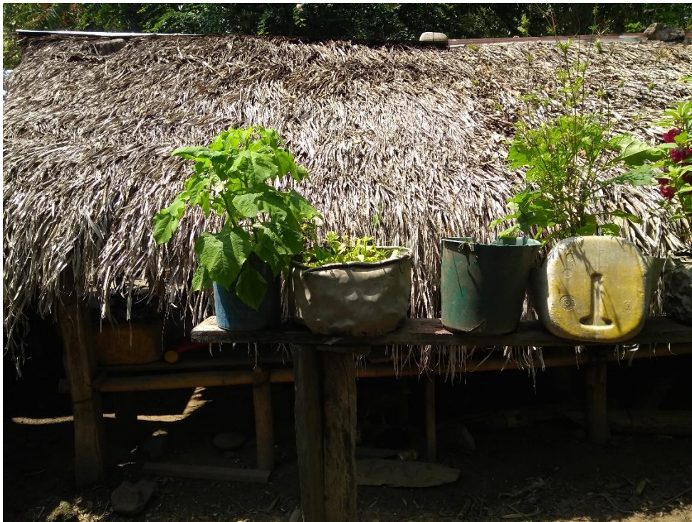
Fotografía 45. Fachada lateral derecha cocina de A.L. Y A.M.
