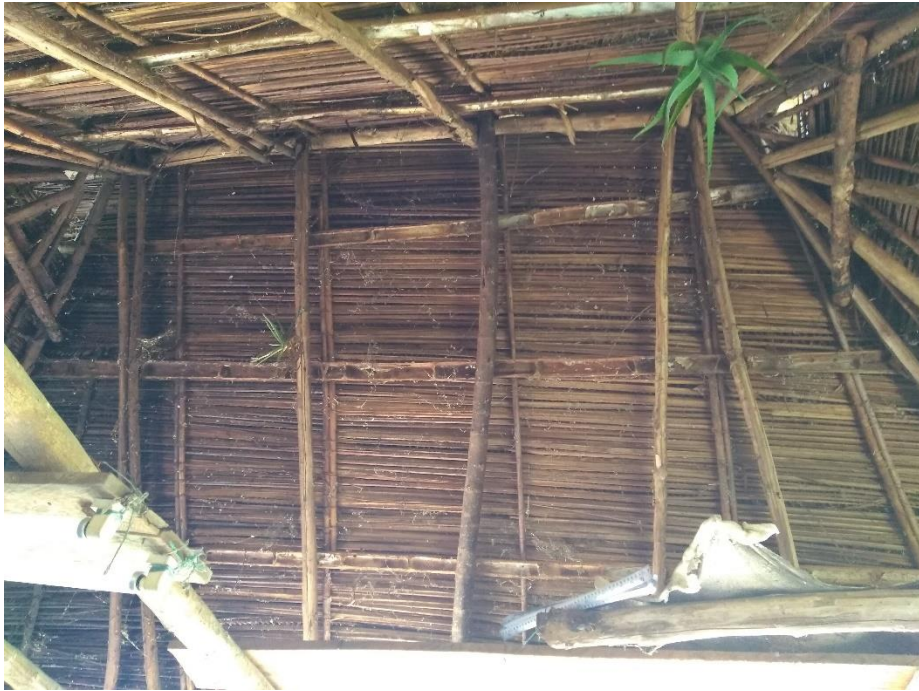
Fotografía 4. Techo empajado Casa de R.C.
