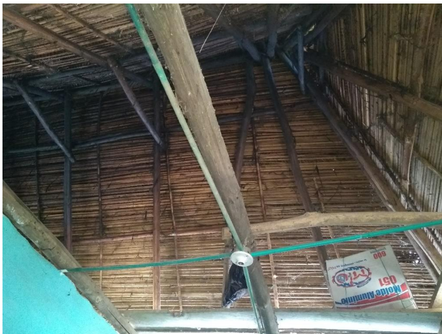
Fotografía 63. Techo empalmado casa Y.C.
