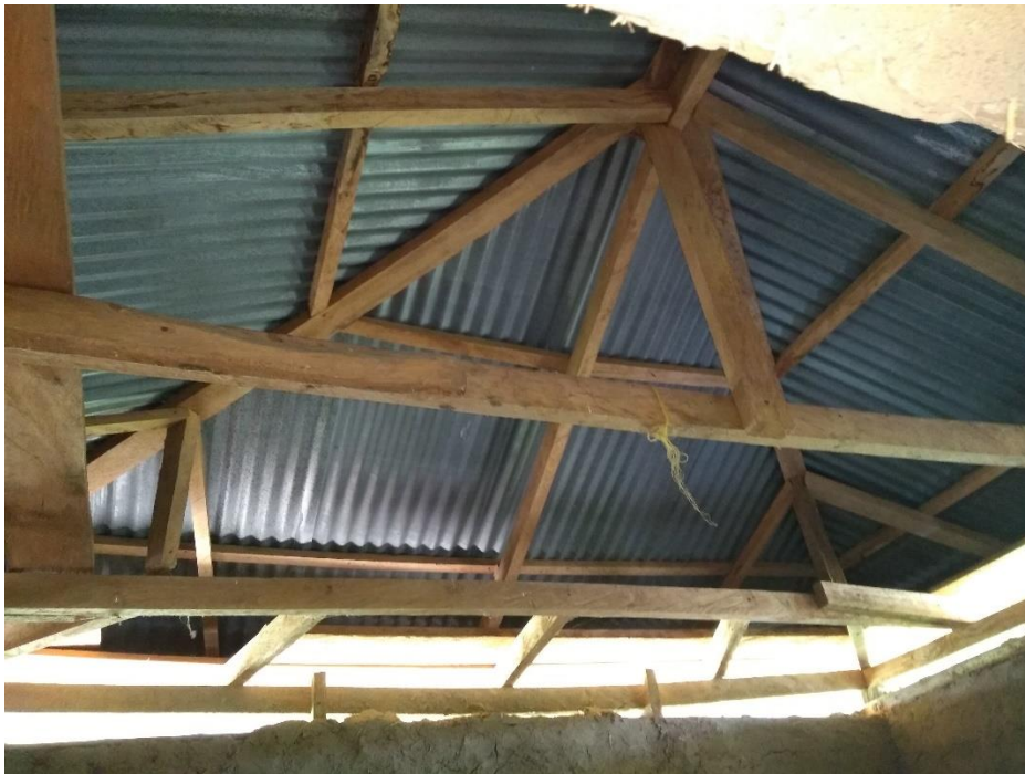
Fotografía 29. Techo en zinc de R.C.
