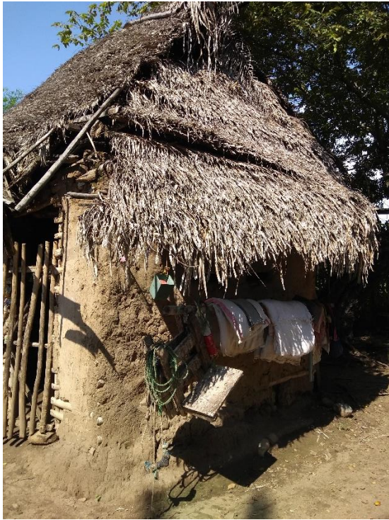
Fotografía 72. Fachada lateral derecha de cocina de E.C.D.
