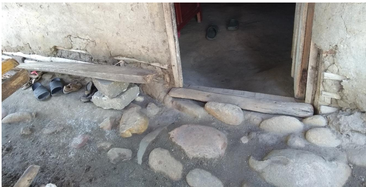
Fotografía 75. Empedrado de base pasa el piso de cocina de E.C.D.
