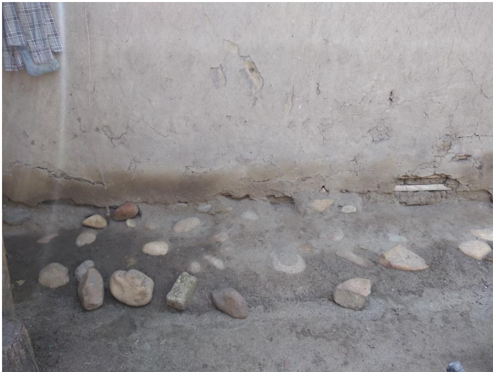
Fotografía 73. Empedrado de base pasa el piso de cocina de E.C.D.
