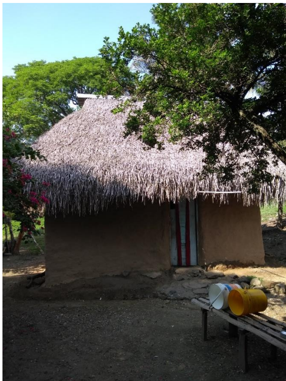
Fotografía 94. Fachada principal casa E.D.
