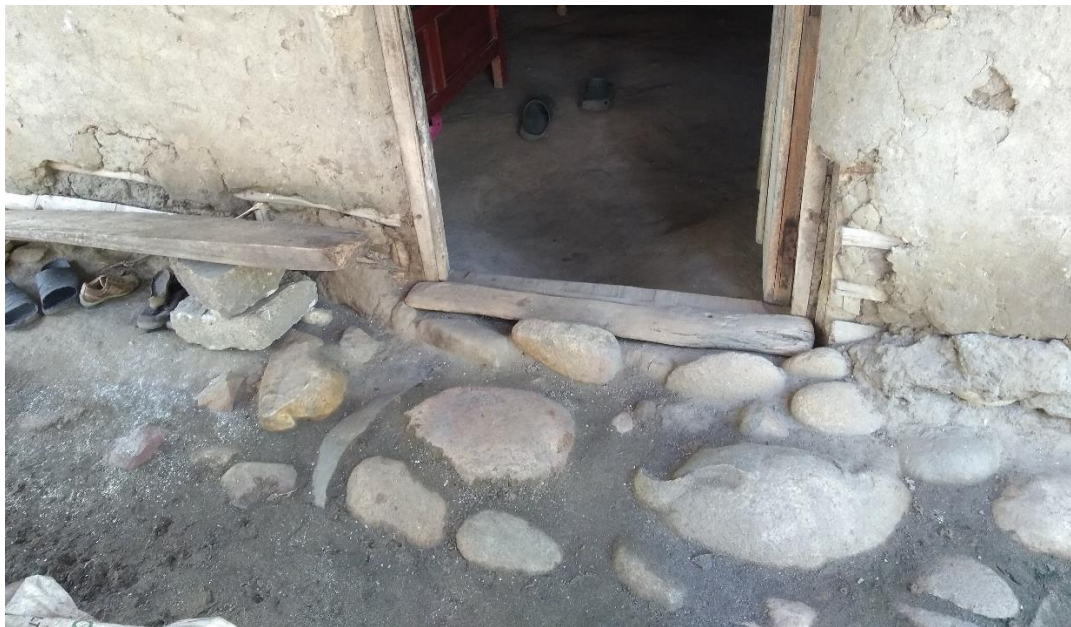
Fotografía 74. Empedrado de base pasa el piso de cocina de E.C.D.
