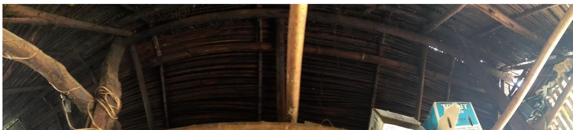
Fotografía 30. Techo en empalmado casa de L.B.C.
