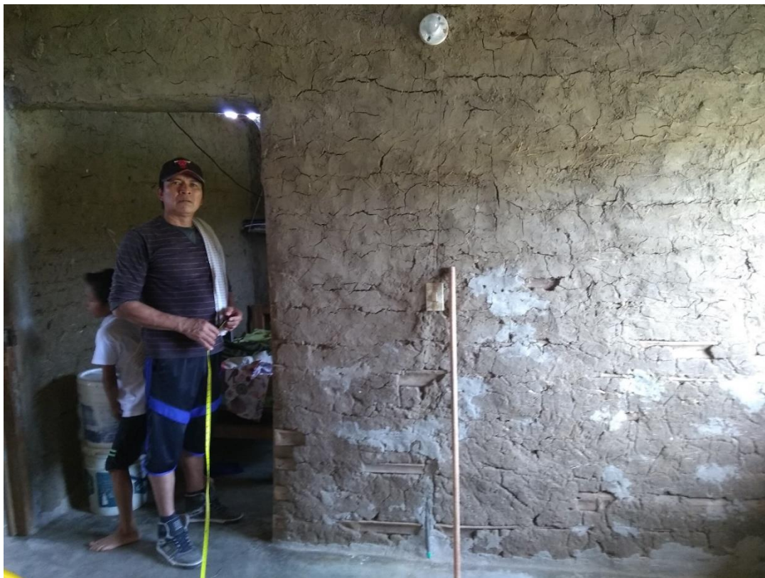
Fotografía 22. Pared de habitación casa R.C.
