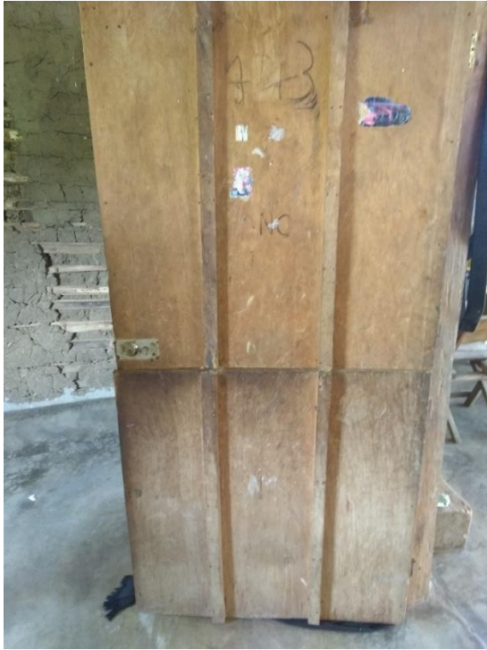
Fotografía 24. Puerta interior de casa R.C.
