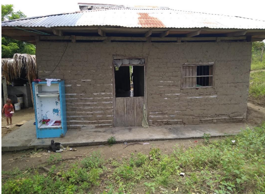
Fotografía 19. Fachada posterior Casa de R.C
