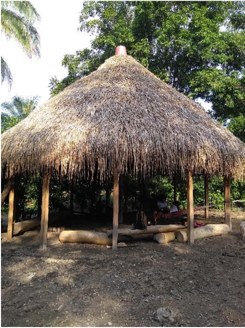
Fotografía 112. Fachada quiosco de Y.D.
