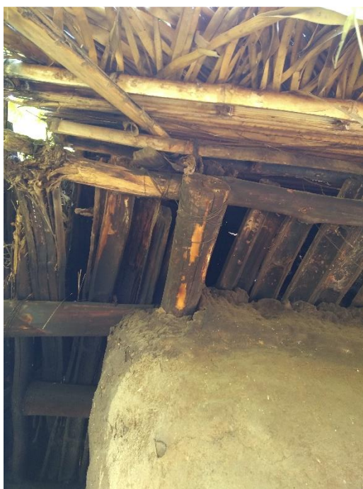
Fotografía 91. Esquina superior posterior derecha de cocina de E.C.D.
