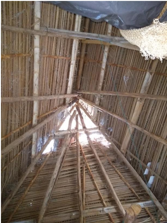
Fotografía 101. Techo en empalmado casa de E.D.
