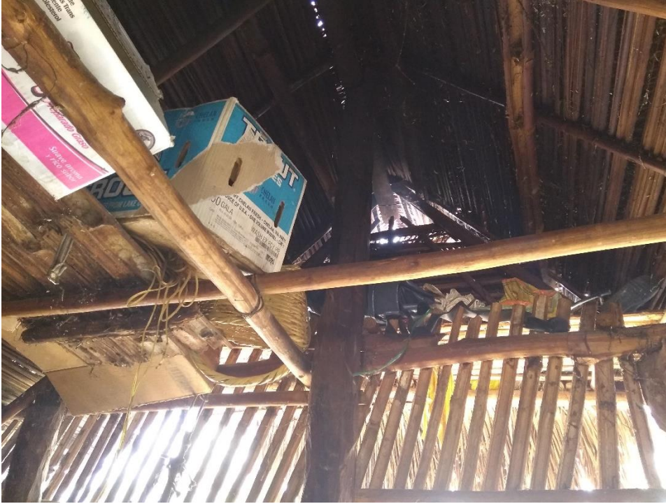
Fotografía 40. Techo en empalmado casa de L.B.C.
