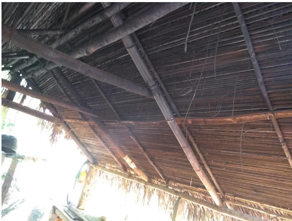
Fotografía 47. Techo en empalmado cocina de A.L. Y A.M.
