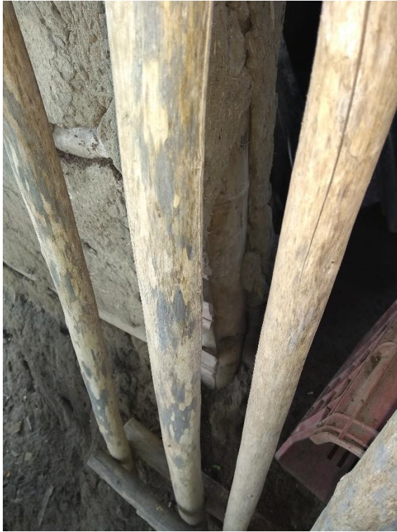
Fotografía 88. Guadua como horcón de la puerta de la cocina de E.C.D
