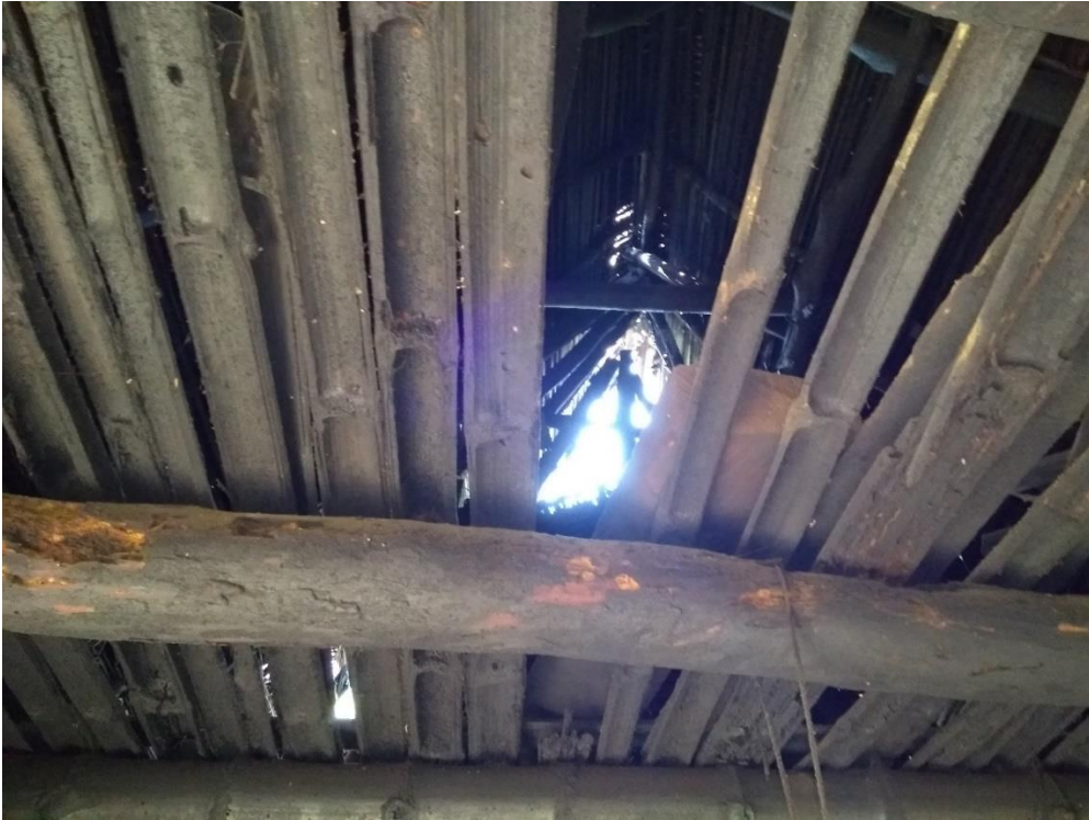
Fotografía 76. Techo en empalmado con cielo raso en guadua de cocina de E.C.D.
