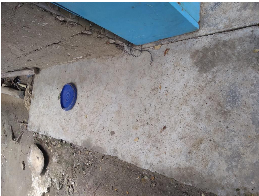
Fotografía 17. Andén en concreto casa de R.C.
