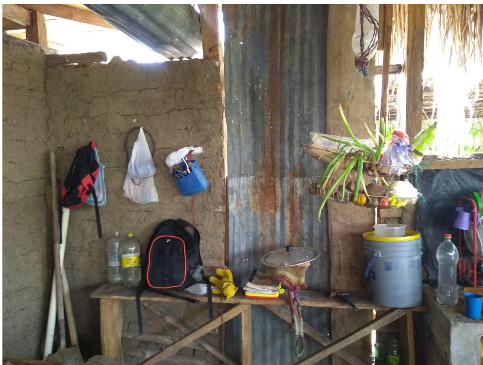
Fotografía 7. Pared de cocina Casa de R.C.
