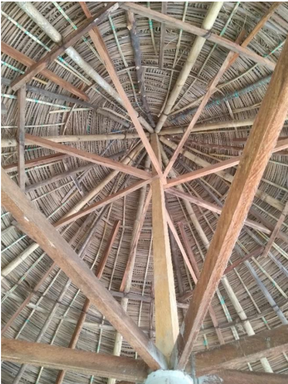
Fotografía 113. Estructura interior de quisco de Y.D.
