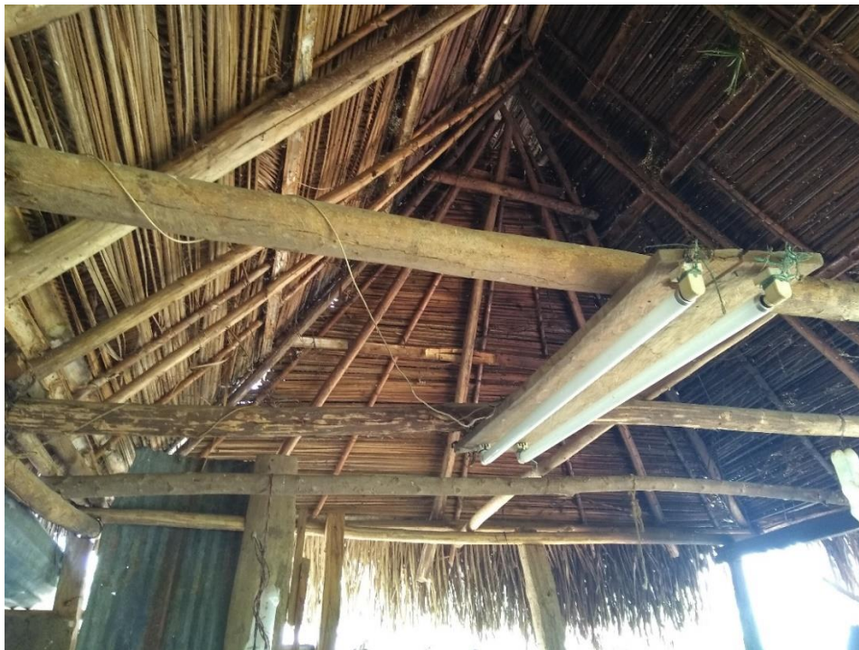
Fotografía 6. Techo empajado Casa de R.C.
