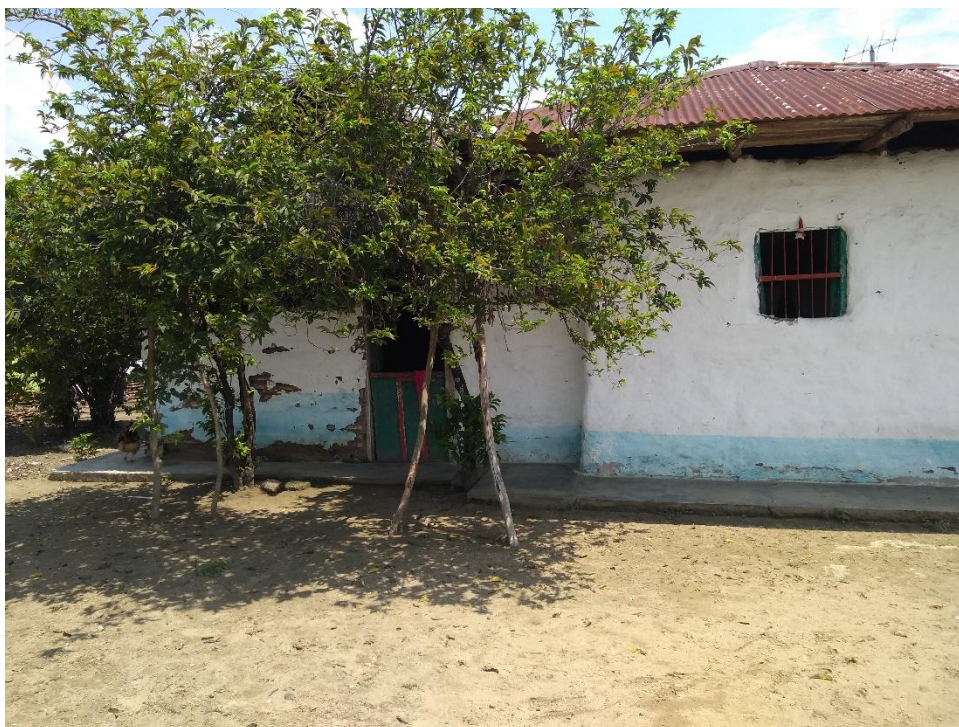
Fotografía 31. Fachada principal casa de L.B.C.
