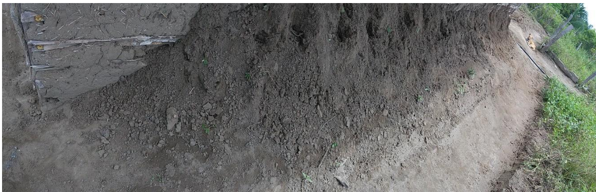
Fotografía 21. Andén en tierra casa de R.C.
