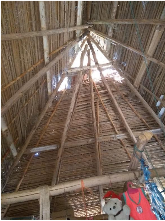
Fotografía 100. Techo en empalmado casa de E.D.
