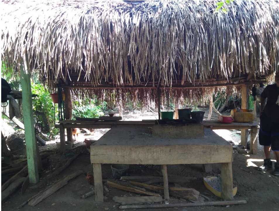
Fotografía 44. Fachada lateral izquierda cocina de A.L. Y A.M.
