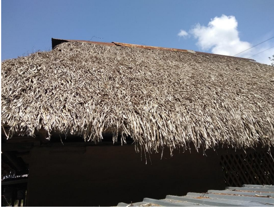
Fotografía 58. Techo empalmado casa Y.C.
