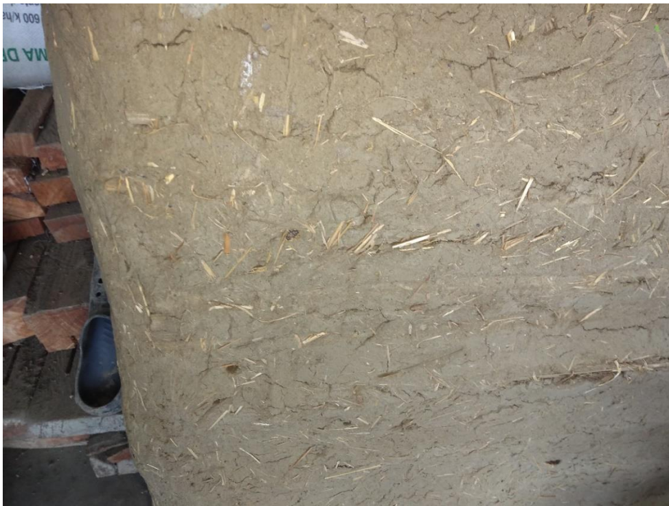
Fotografía 33. Pared de bareque con palma picada casa de L.B.C.
