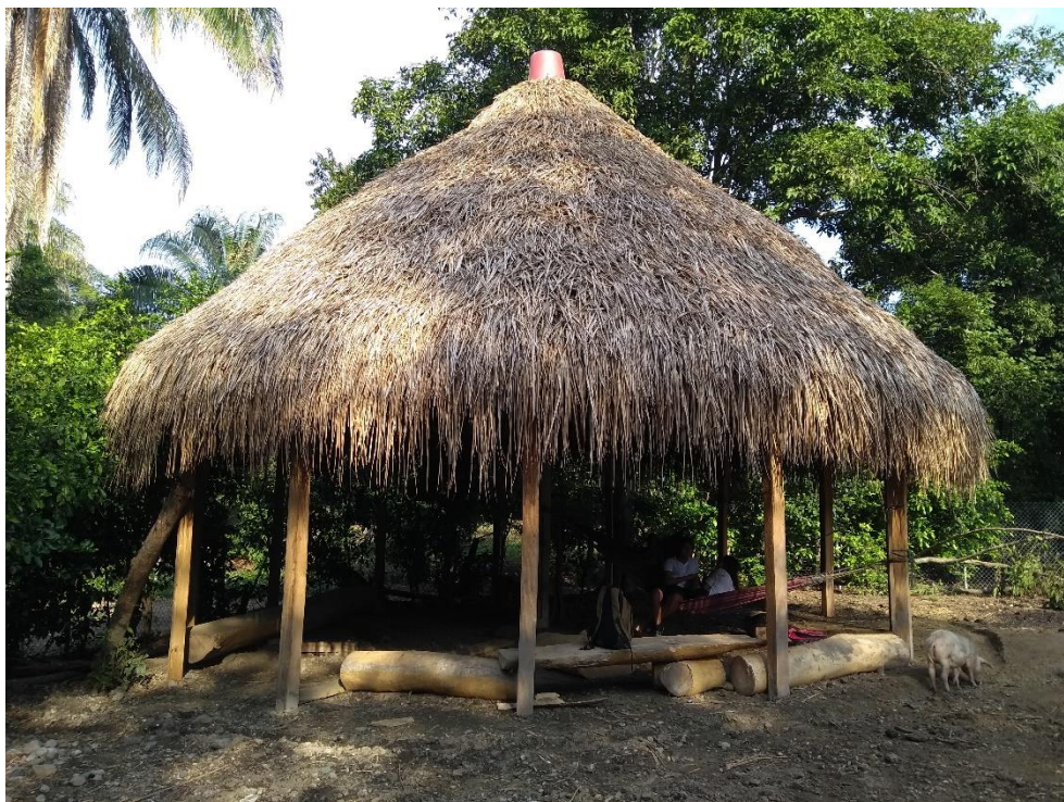
Fotografía 111. Fachada quiosco de Y.D.
