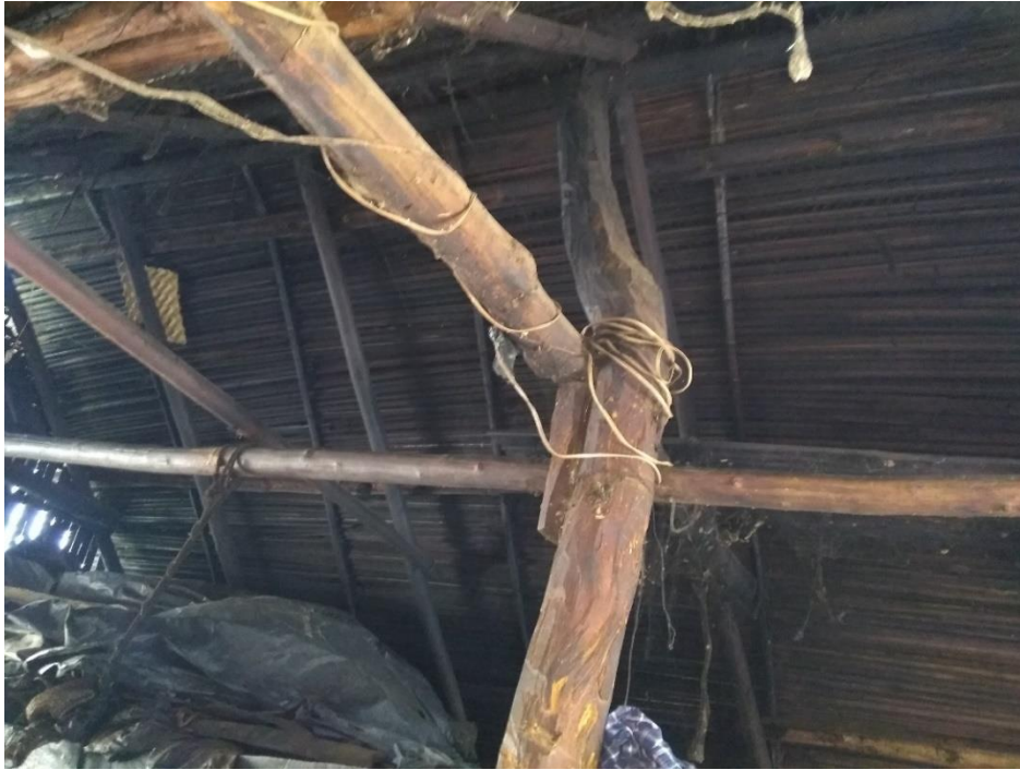
Fotografía 36. Techo en empalmado casa de L.B.C.
