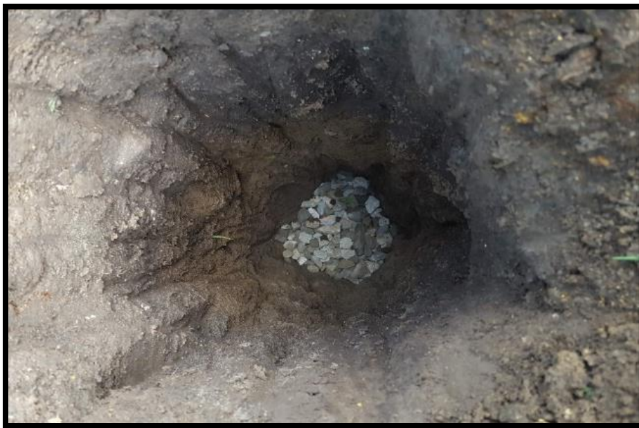
Figura No. 24 Relleno con material granular aproximadamente 5 cm. Fuente: Propia
