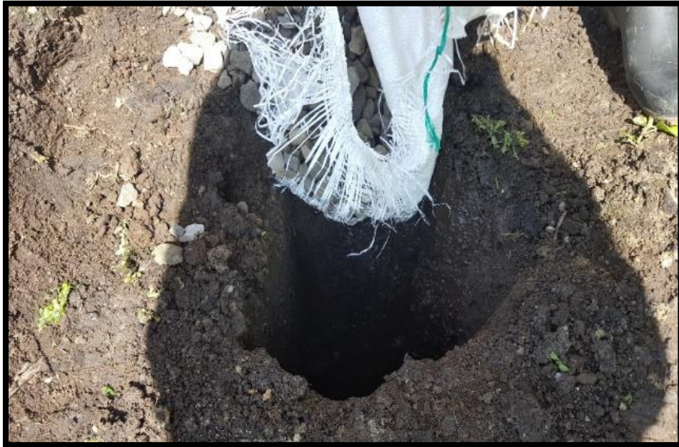
Figura No. 23 Se rellena los 3 huecos con material granular. Fuente: Propia
