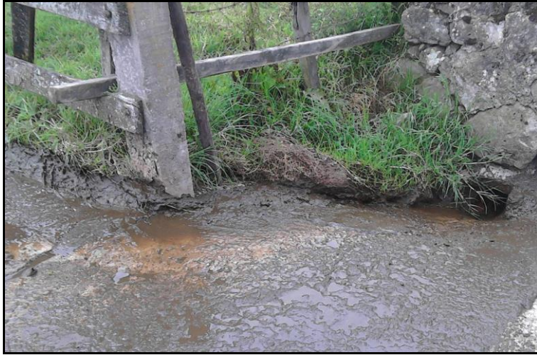
Figura No. 13 Punto de desagüe. Fuente: Propia.
