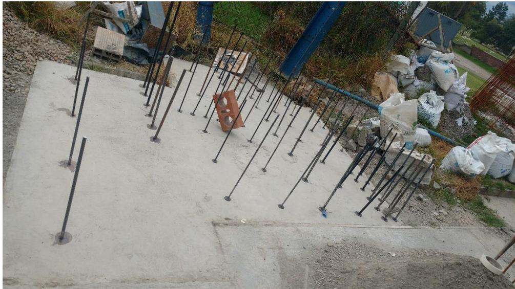
*Figura 25. Anclajes en losas a tracción.*
