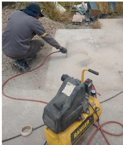
*Figura 21. Limpieza con aire comprimido.*
