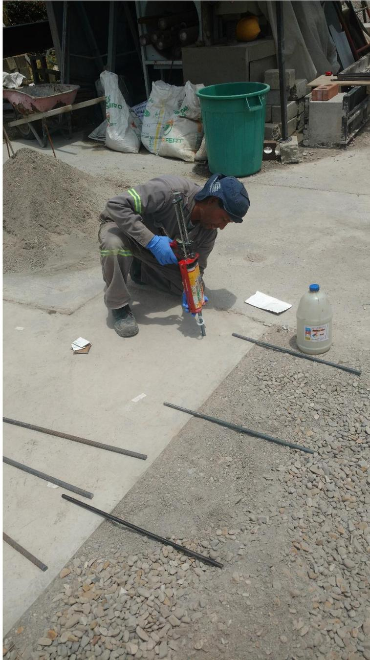
*Figura 24. Aplicación del epóxico.*
