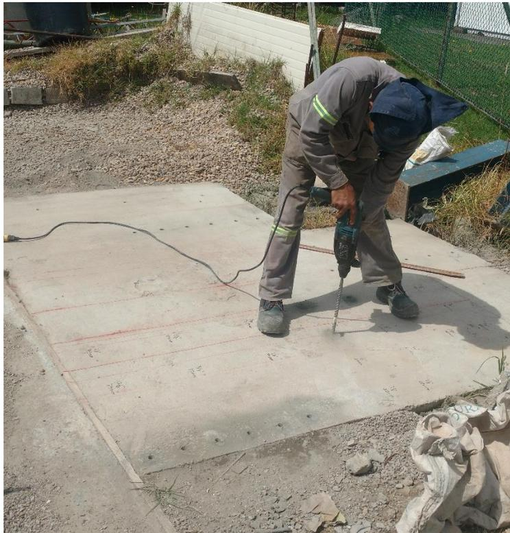
*Figura 19. Perforación de agujeros para anclajes.*
