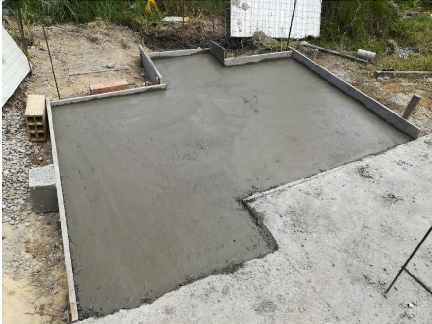
*Figura 15. Losas fundidas para ensayos a tracción.*
