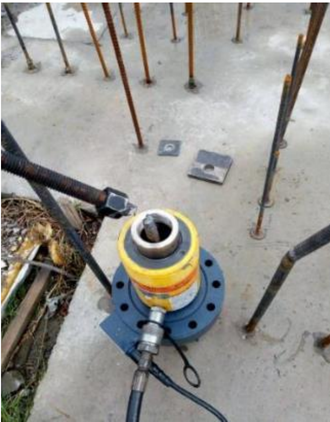
Fotografía 3. Falla del acero.
