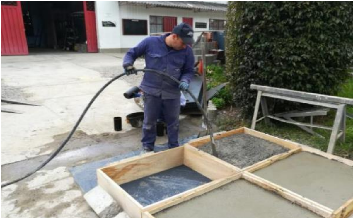
Fotografía 18. Vibración mecánica de placas de concreto aligerado. *Fuente: Propia.
