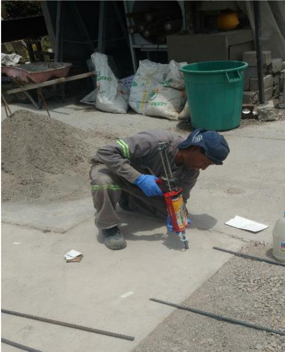
Fotografía 11. Aplicación de resina Epoxica. *Fuente: Propia
