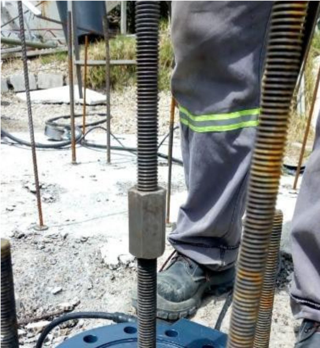
Fotografía 6. Acero de refuerzo tipo enroscado. *Fuente: Propia.
