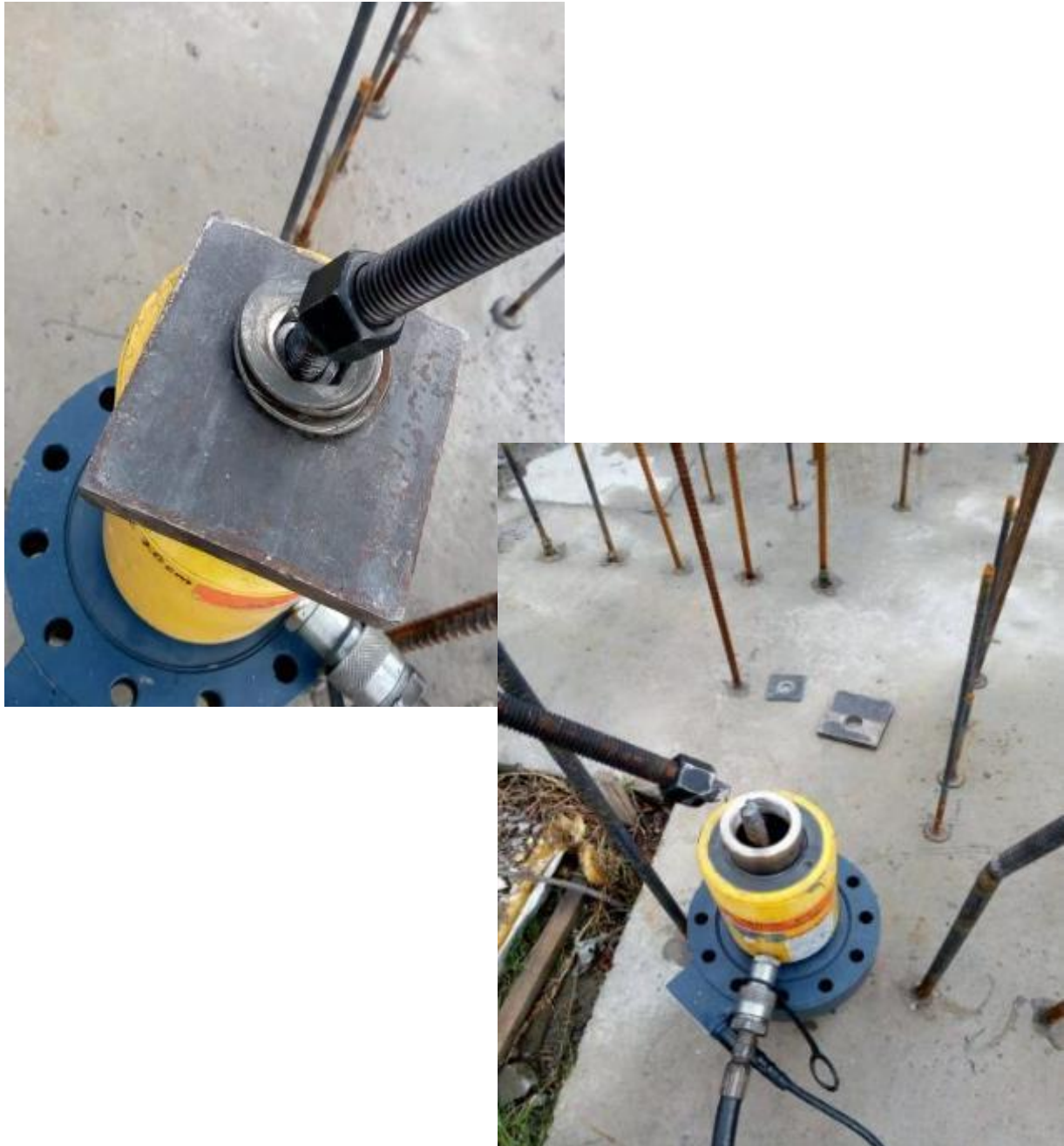
Ilustración 31. Falla del acero. *Fuente: Propia.
