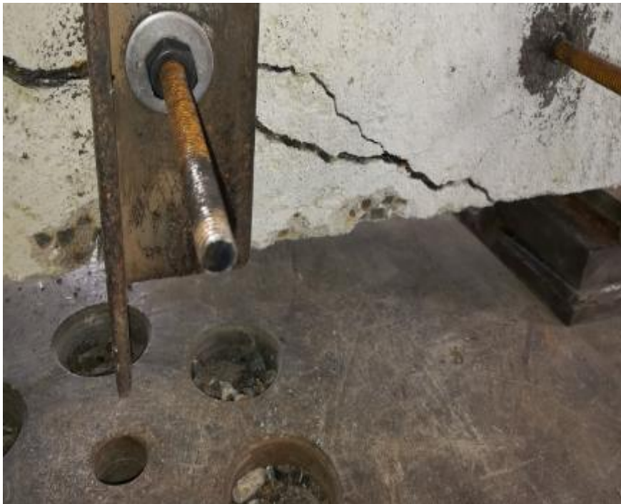
Fotografía 23. Falla por arrancamiento del concreto M6. *Fuente: Propia.
