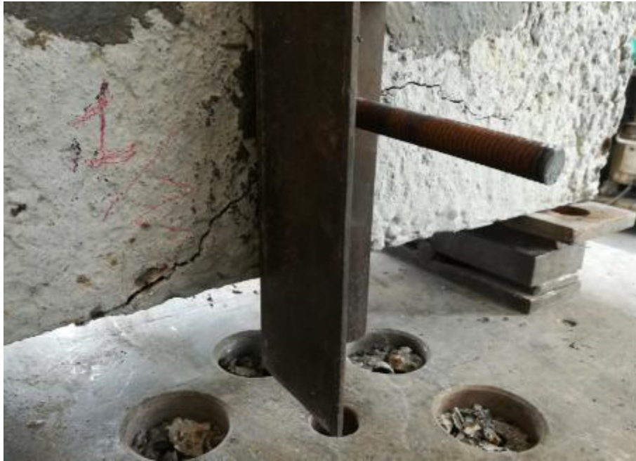
Fotografía 24. Falla por arrancamiento del concreto M1- ½". *Fuente: Propia.
