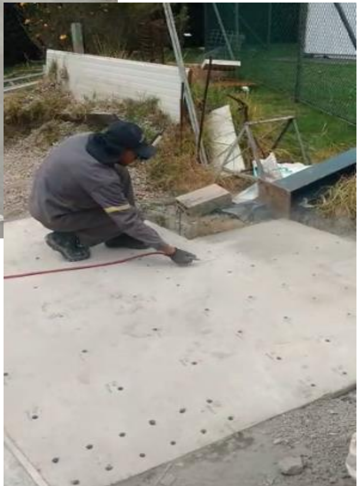
Fotografía 10. Limpieza de la perforación con aire a presión.
