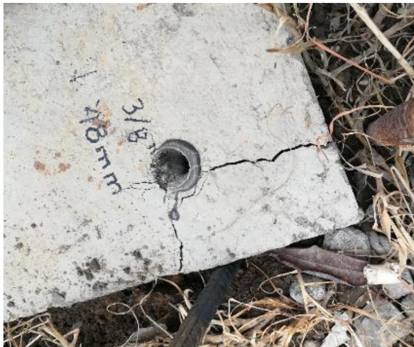
Ilustración 32. Falla por Adherencia y Falla adherencia + borde. *Fuente: Propia.
