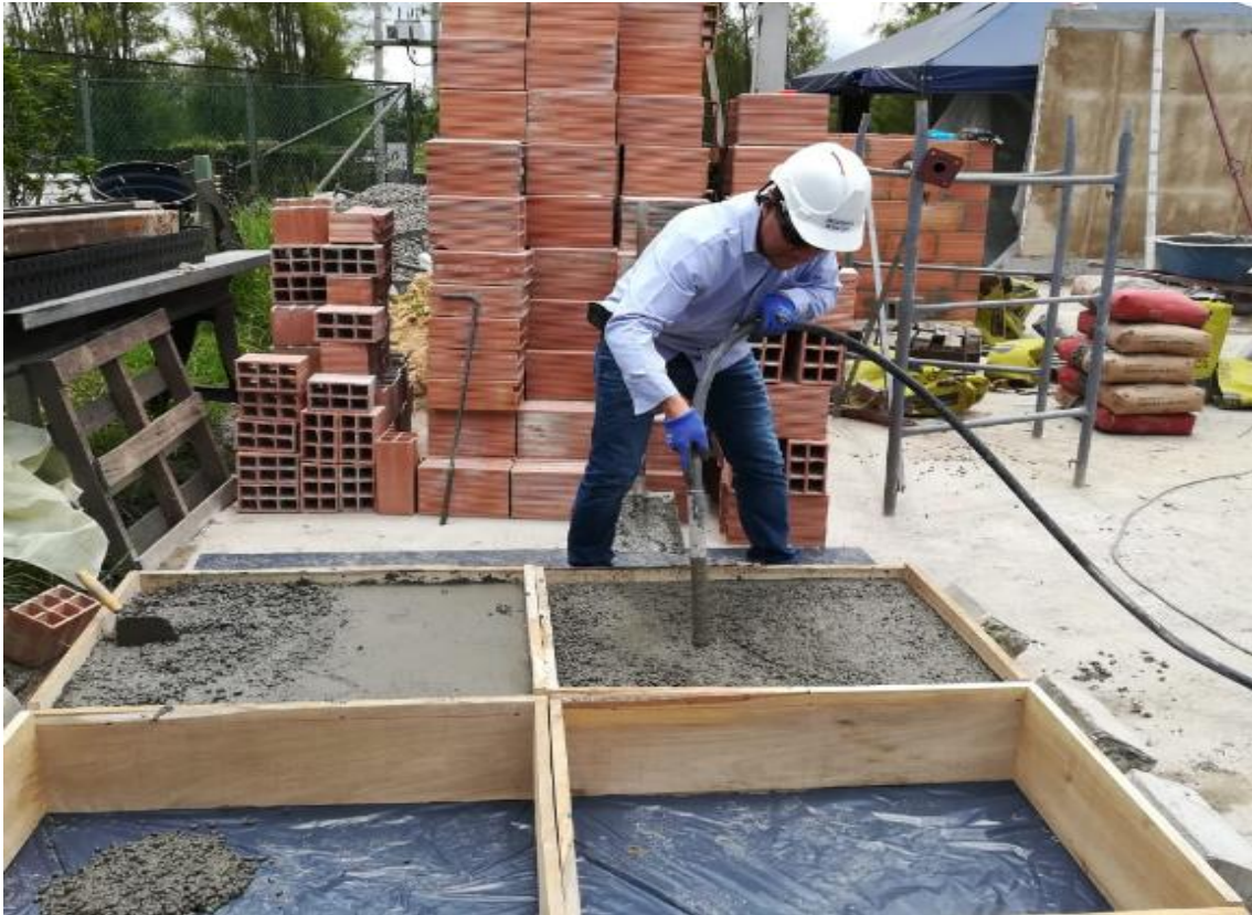
Fotografía 15. Vibrado de placa para ensayo de corte. *Fuente: Propia
