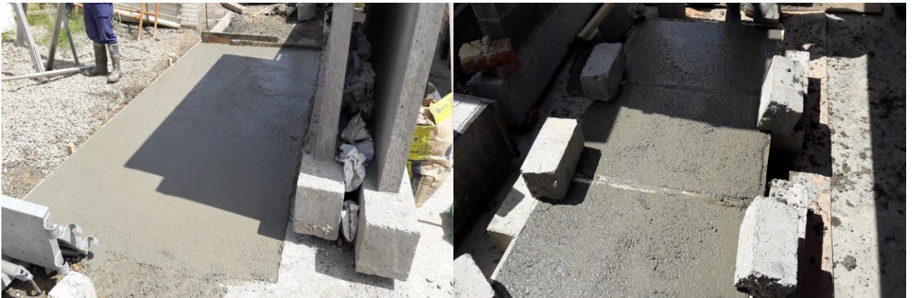
Ilustración 10. Losas fundidas para ensayos de tracción y cortante. *Fuente: Morales Monroy, H. (2018).
