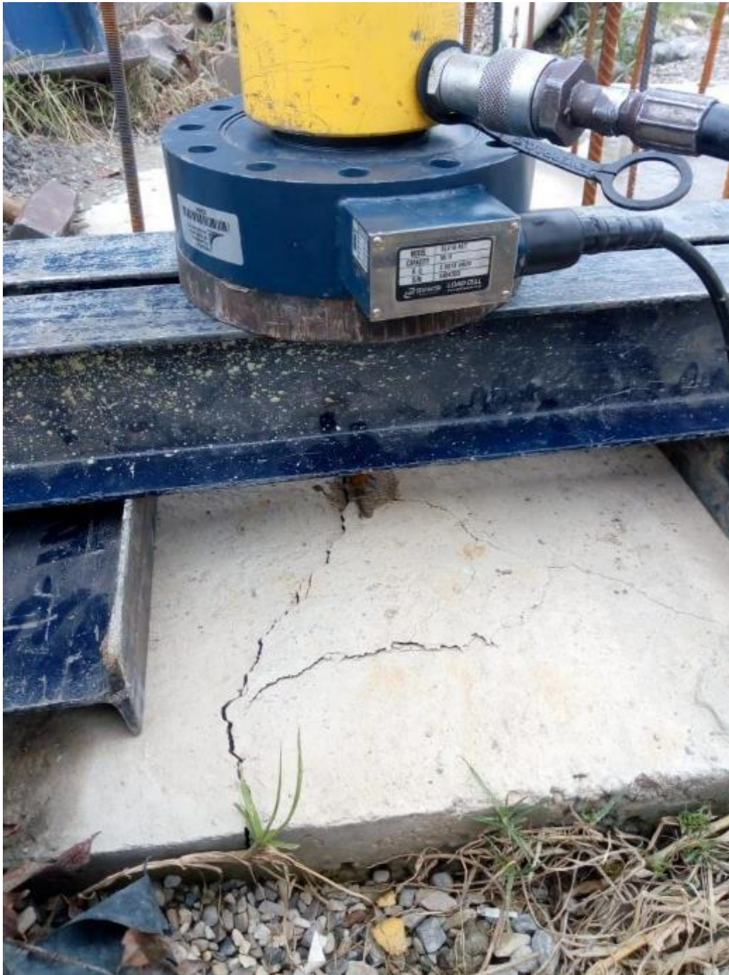
Ilustración 30. Falla por barra de acero. *Fuente: Propia.
