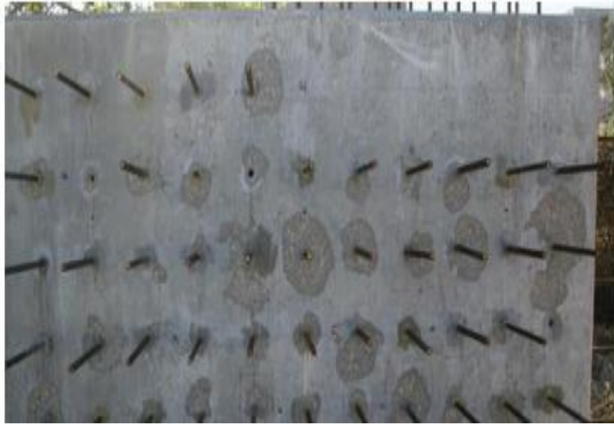
Ilustración 9. Anclajes embebidos en uno de los muros.
