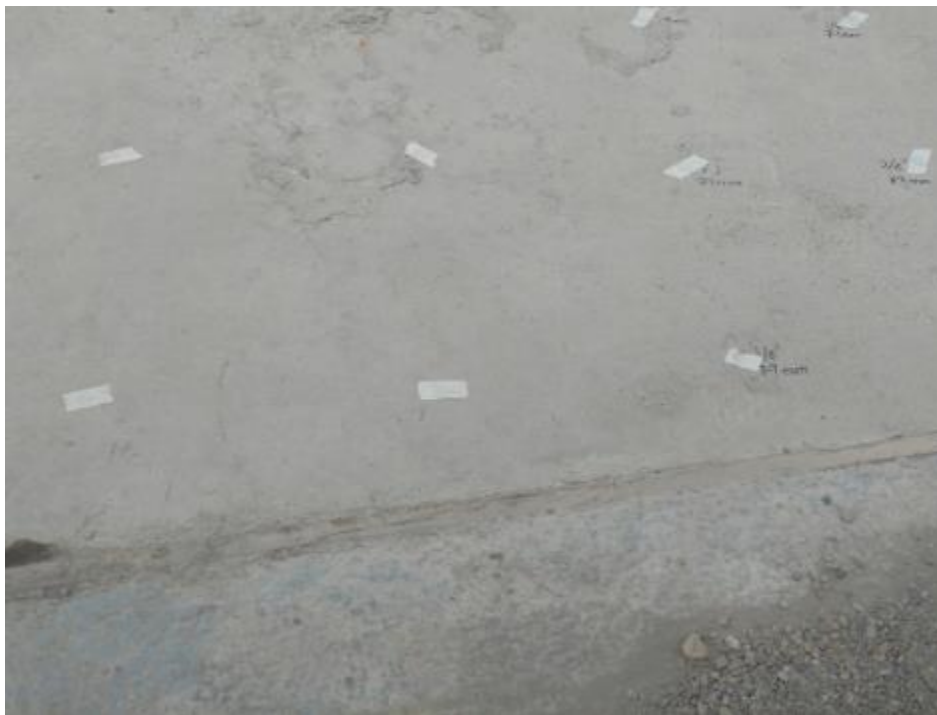
Fotografía 9. Protección de perforaciones *Fuente: Propia
