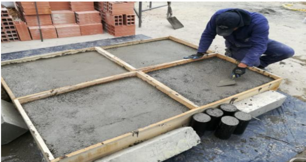
Fotografía 19. Fundida de placas y toma de muestras para la elaboración de ensayos de resistencia a la compresión. *Fuente: Propia.
