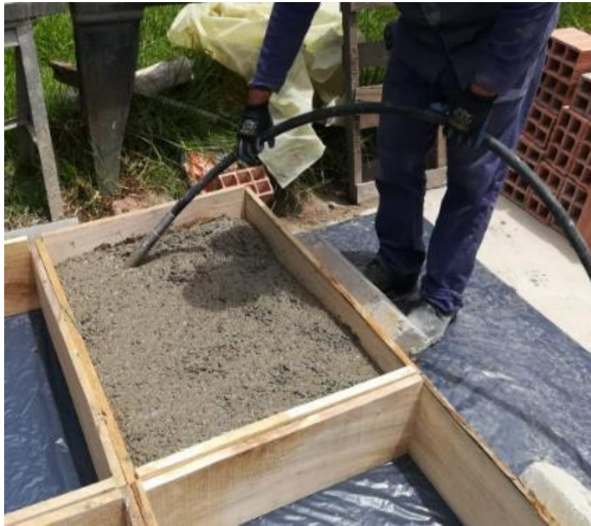
Fotografía 16. Vibrado de placa de espesor variable II. *Fuente: Propia
