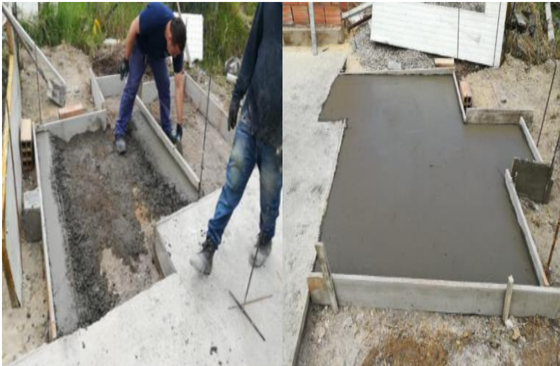
Fotografía 14. Fundida de placas aligeradas de espesor variable. *Fuente: Propia.
