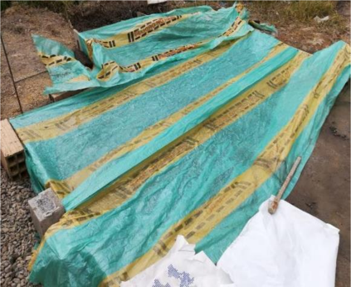
Fotografía 13. Curado de placas de concreto. *Fuente: Propia
