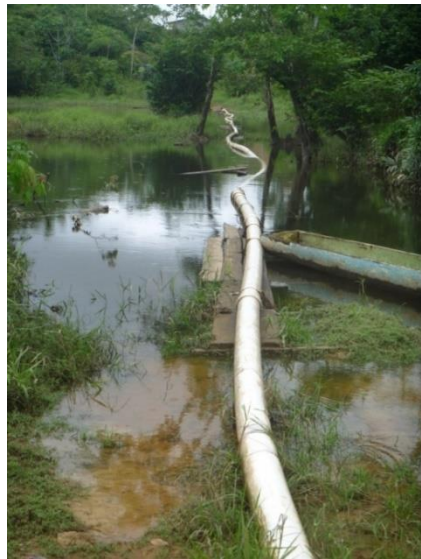
Ilustración 16. Línea de aducción sobre aguas estancadas del río Atrato.
