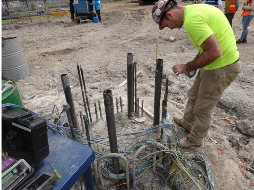
**Fotografía 8.** Extensómetro de barra de compresión (Compression Telltales).
