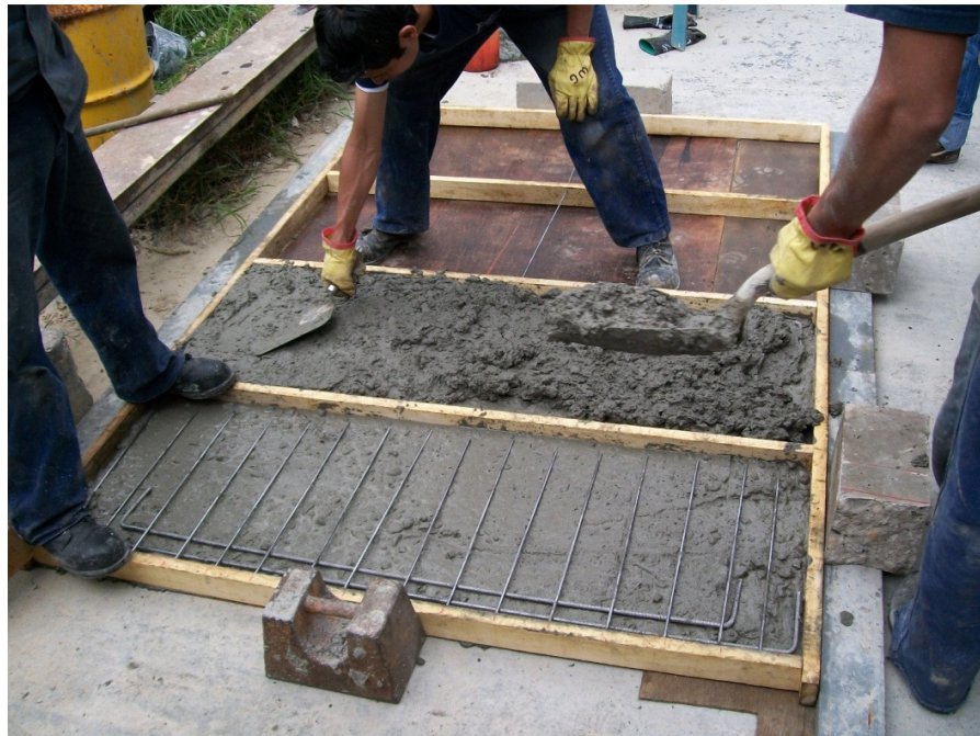
Armaduras de refuerzo típicas
