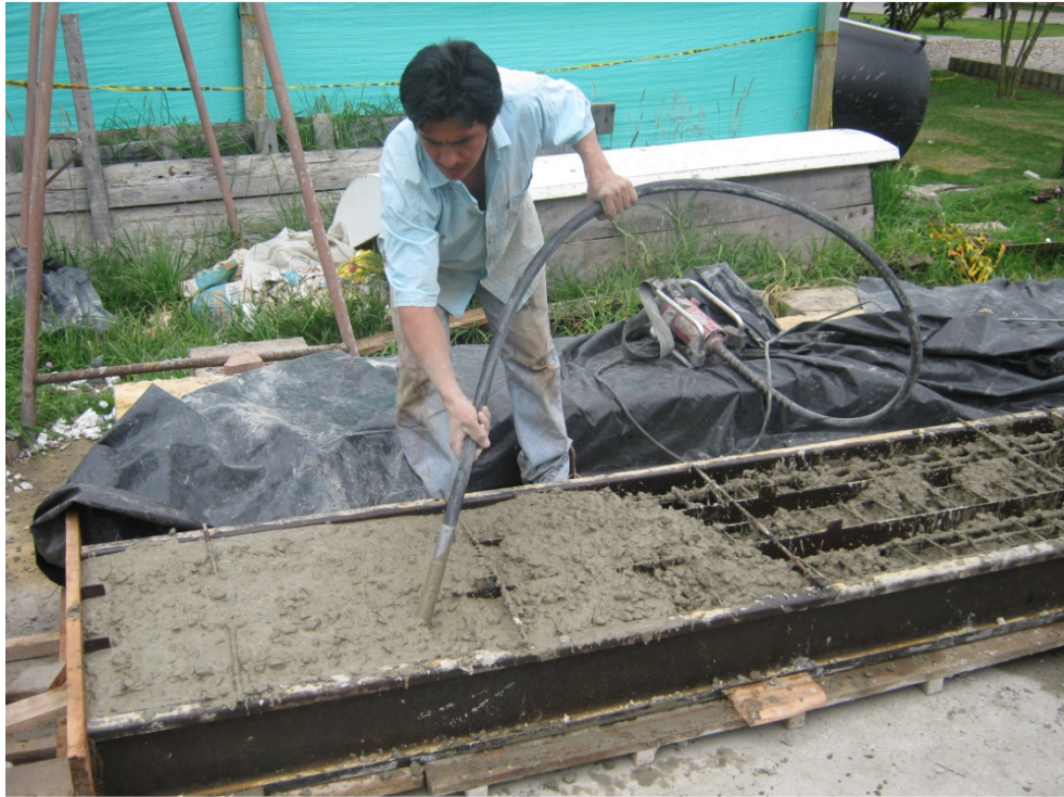
Vibración del concreto (CR)
