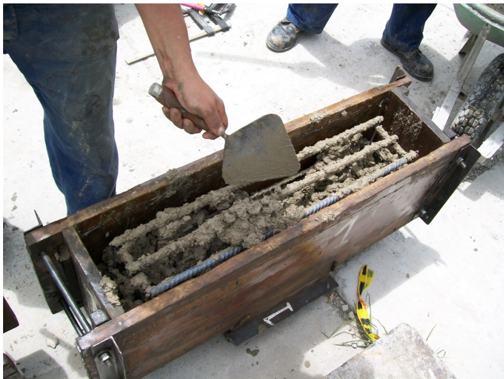
Colocación de armadura y vaciado concreto
