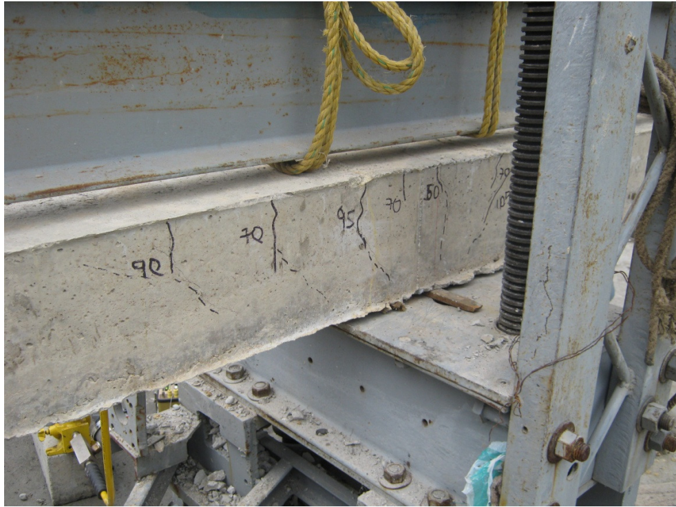
Fisuras apoyo central
