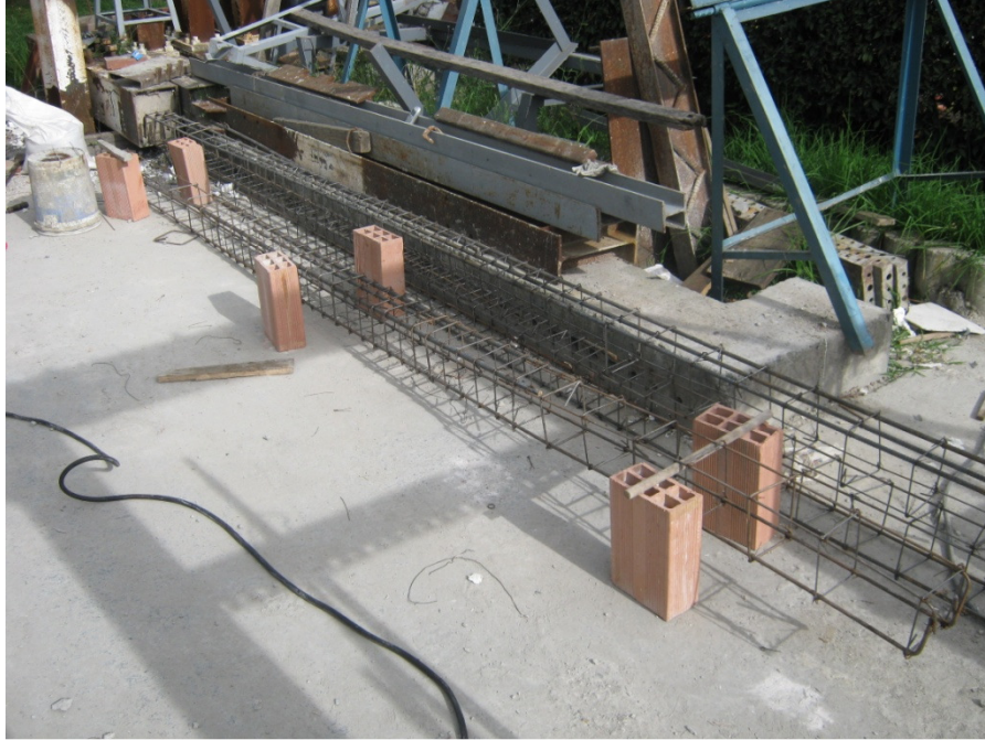
Armaduras de refuerzo típicas
