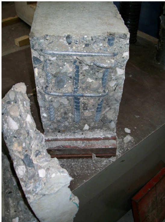
Exploración acero de refuerzo
