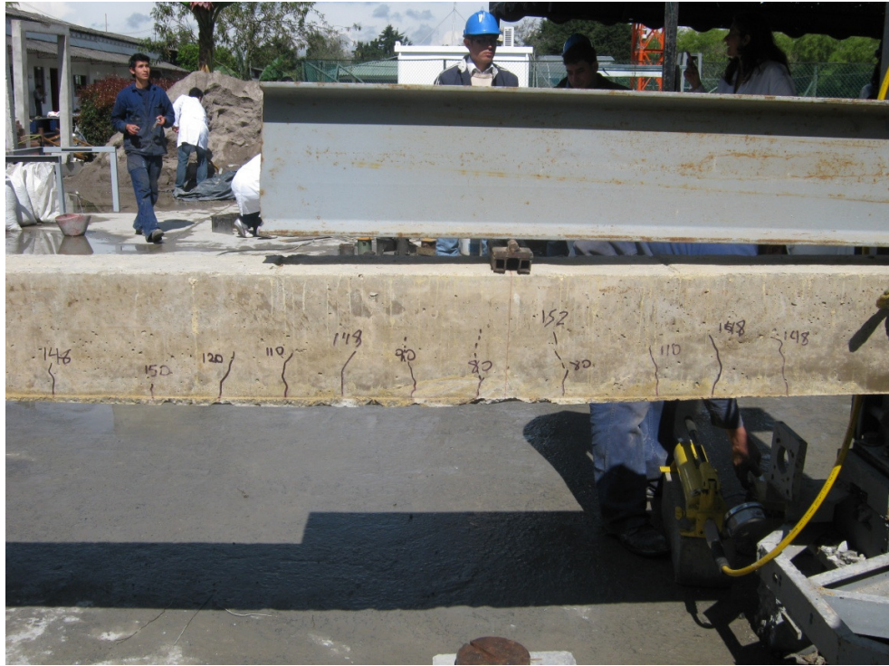
Fisuras luz derecha
