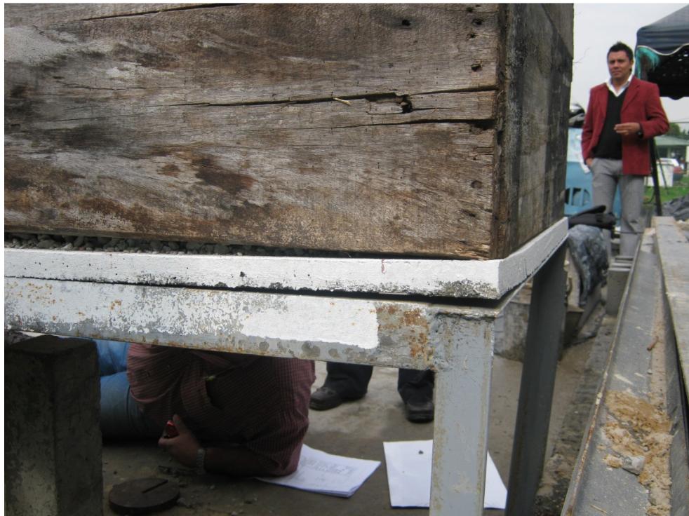
Levantamiento esquina vista apoyo longitudinal
