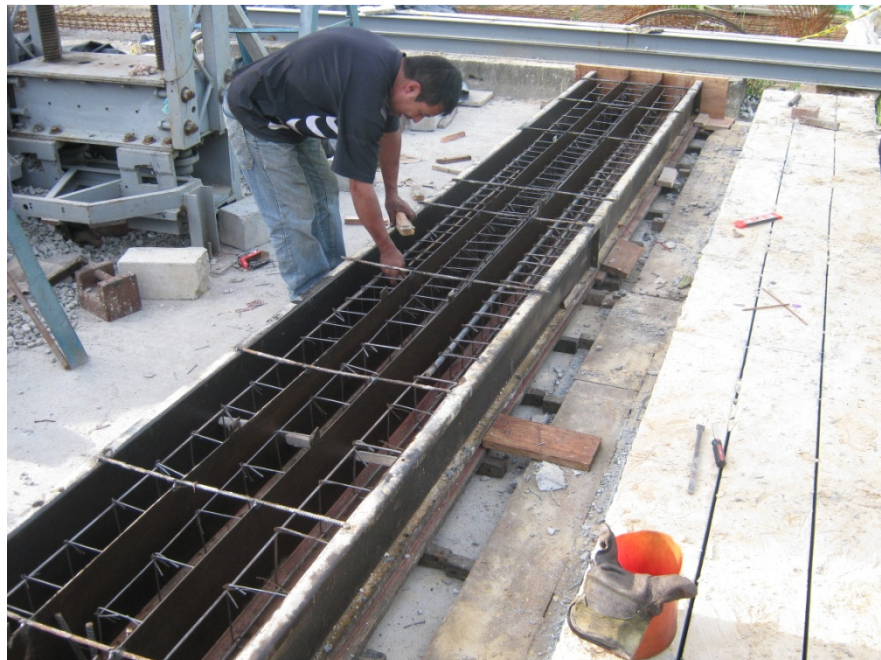
Armado de formaleta (CR) y vigas fundidas (CC)
