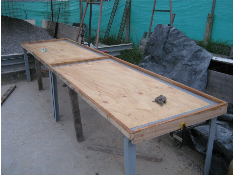
Armado de formaleta
