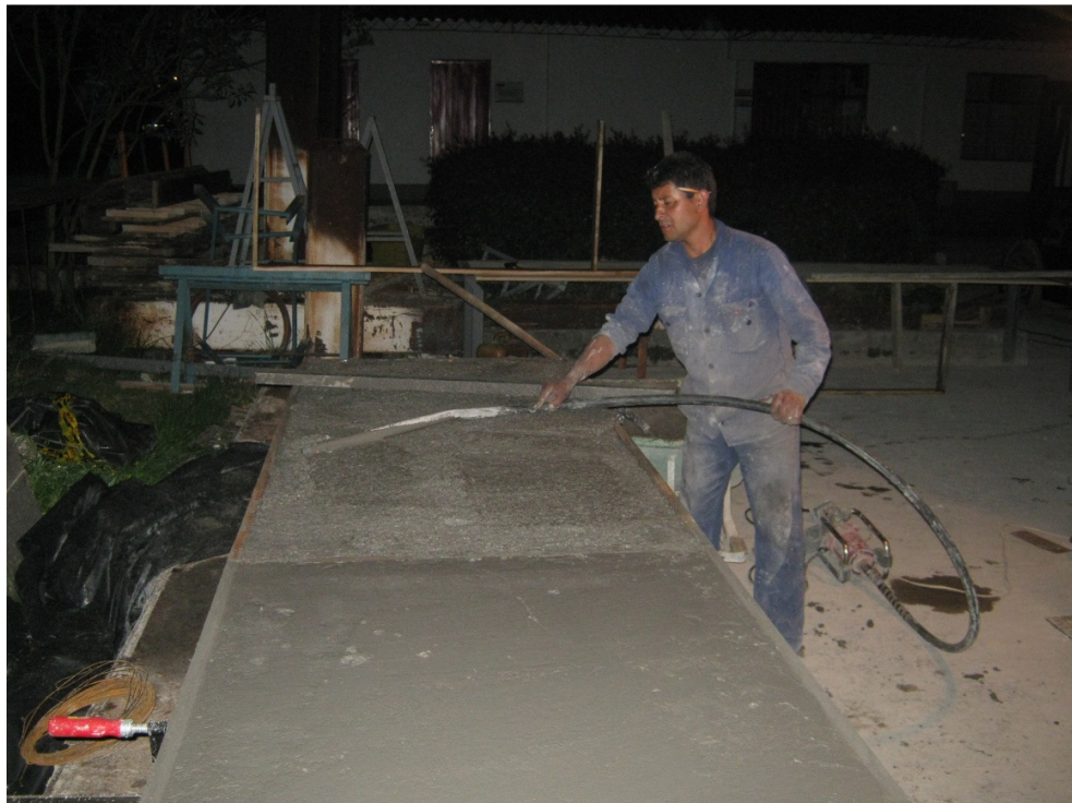
Vibración del concreto (CR)
