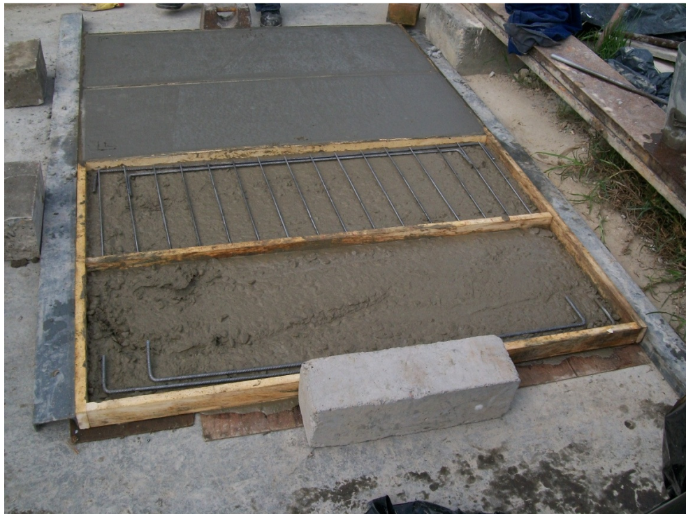
Armaduras de refuerzo típicas
