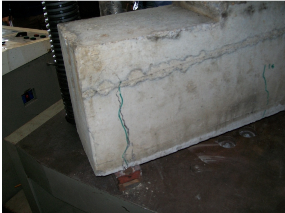
Mecanismo de falla cara 2
