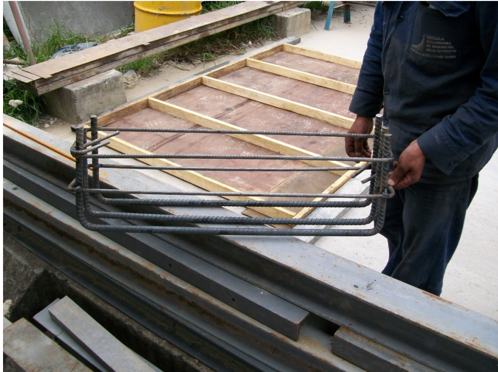
Armadura de refuerzo tipo 2
