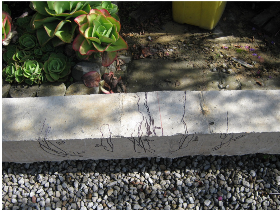
Vista superior apoyo central
