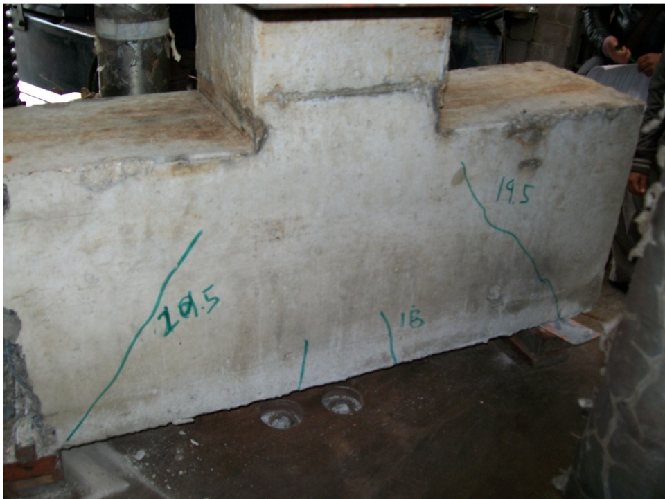
Mecanismo de falla cara 2
