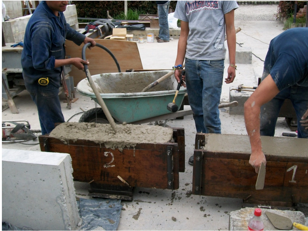
Vibración del concreto
