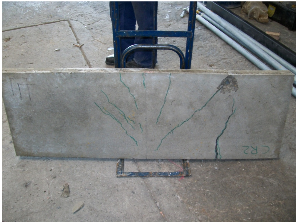
Exploración acero de refuerzo
