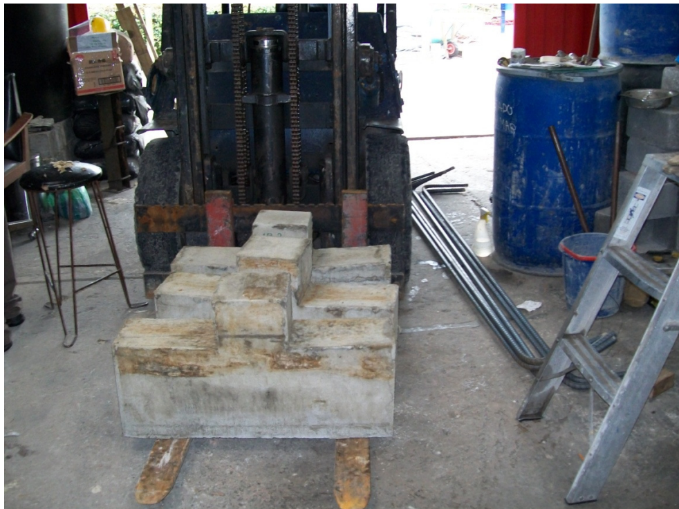
Transporte de ménsulas
