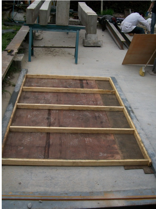
Armado de formaleta
