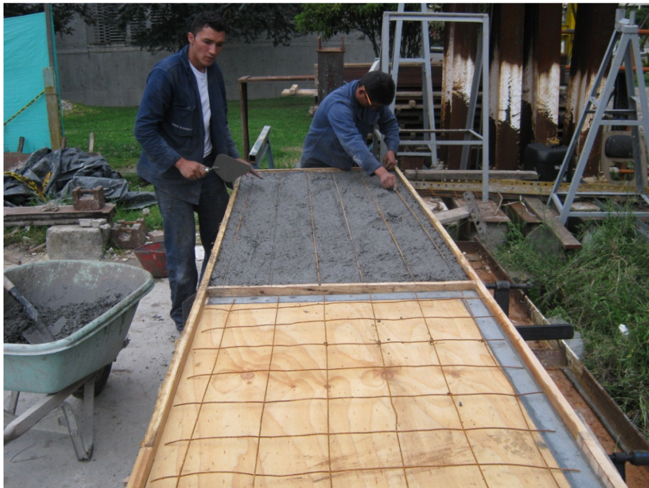
Armaduras de refuerzo típicas
