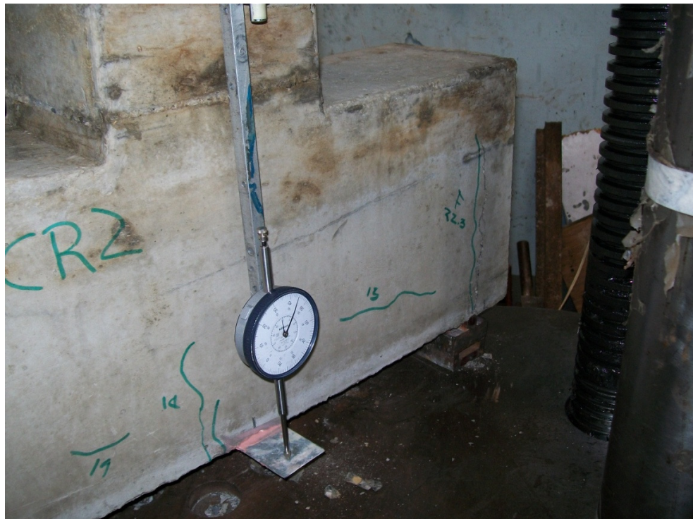
Mecanismo de falla cara 1
