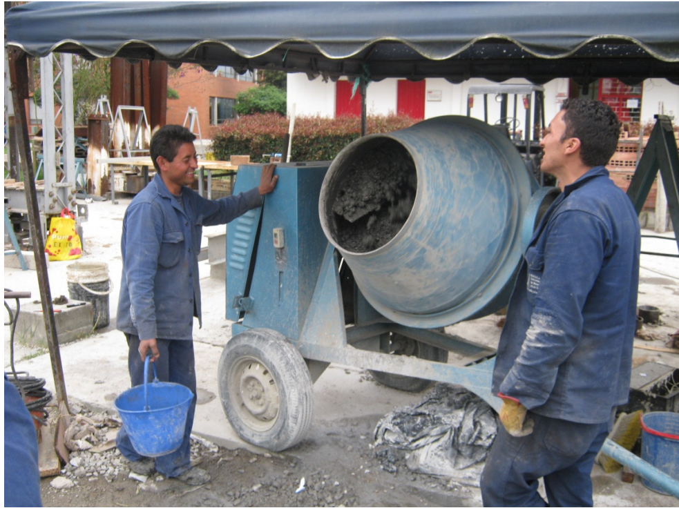
Mezcla del concreto
