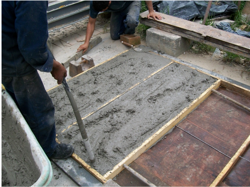
Vibración del concreto (CR)
