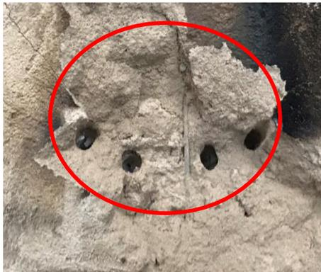
(c) Extracción de anclaje de cuatro puntos
