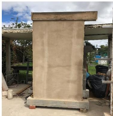
*(a) Instalación de la formaleta en la parte superior del panel.*
