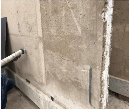
(c) En el mortero se ubican cordones verticales de epóxico con una longitud de 300 mm
