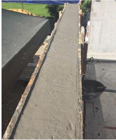
(c) Vaciado del concreto.
