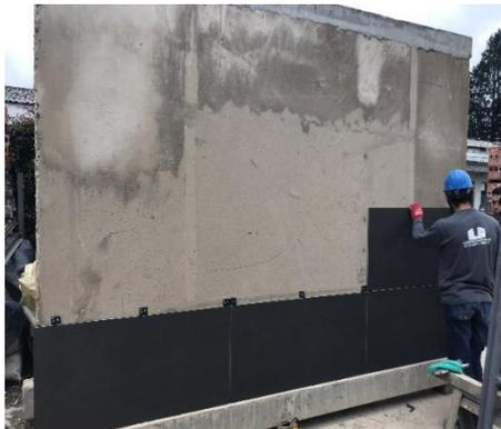
(g) Reproducción del proceso de instalación de la tableta de porcelanato, se dejó una dilatación de 5 mm en su perímetro 5 mm
