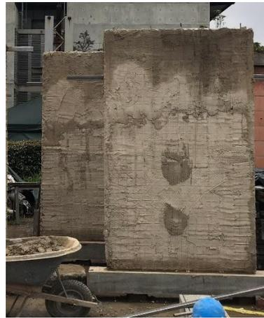
(j) Revoque de la primera capa de mortero tipo S con espesor de 15mm, cubriendo la malla
