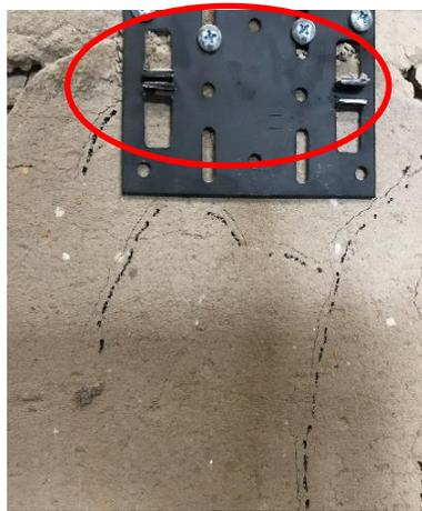
(c) Agrietamiento del panel a lo cerca del anclaje
