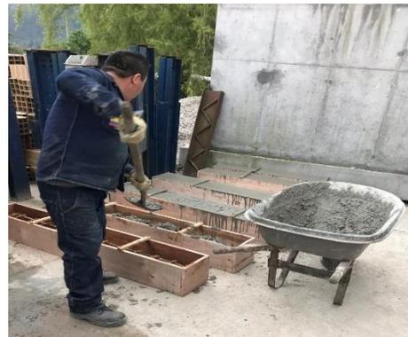
(d) Colocación y vibrado del concreto.
