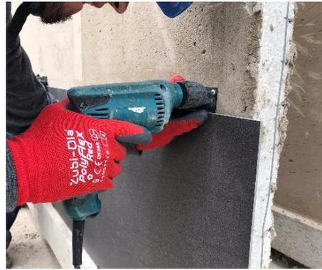
(f) Sujeción de platina superior por medio del sistema chazo y tornillo.
