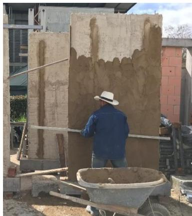
(k) Lanzado de la segunda capa de mortero Tipo N, con espesor de 10 mm
