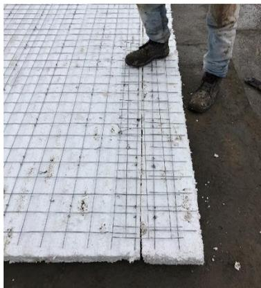
(e) Unión de panel y amarrado de mallas mediante procedimiento manual con traslapo de la malla de 225 mm.
