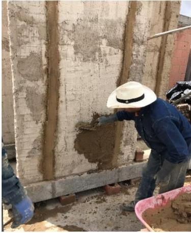
(e) *Espesores de mortero variable*
