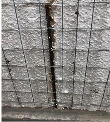
(g) Anclaje de la barra de 3/8" a la viga de cimentación.
