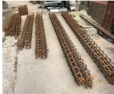
(b) Acero figurado para las vigas
