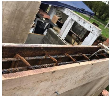
*(b) Colocación de la canasta de acero.*
