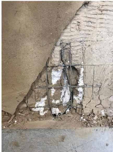
*(b) Detalle de falla desprendimiento del mortero alrededor de varilla.*
