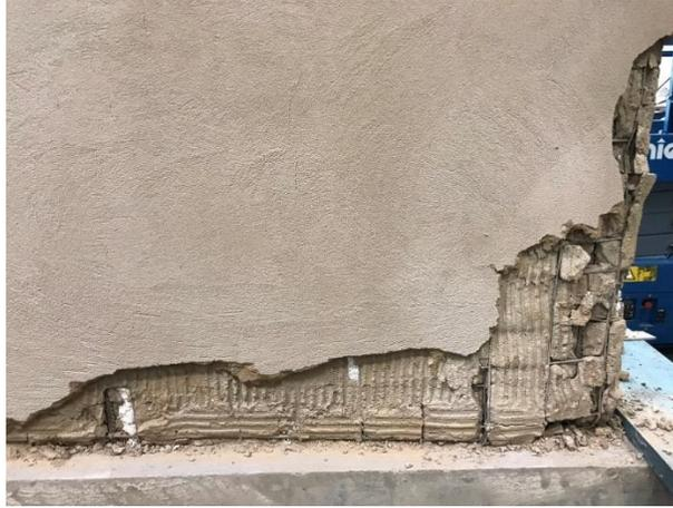
*(a) Falla en el panel en la zona de tensión y compresión alternadas*
