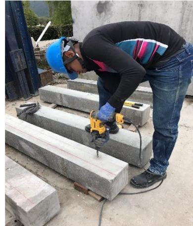
(b) Marcado de puntos de perforación, con profundidad de 50 mm.
