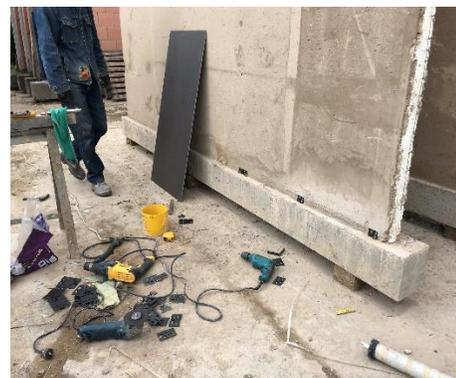
(b) Se fija la platina al muro por medio del sistema chazo y tornillo.
