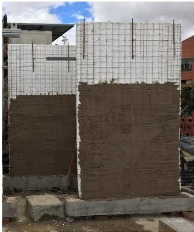
(i) Instalación de los anclajes en la parte superior del panel.
