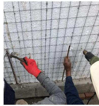
(f) Se desliza la barra de 3/8" entre la malla y la lámina de poliestireno.
