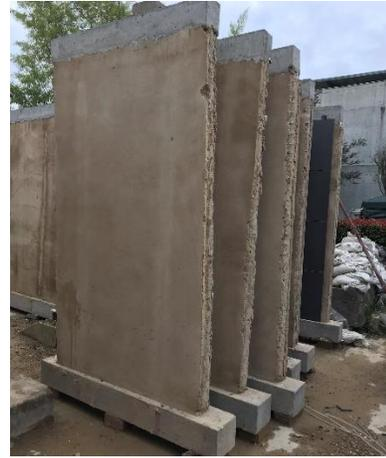
(d) Viga superior después de su fraguado y retiro de la formaleta.
