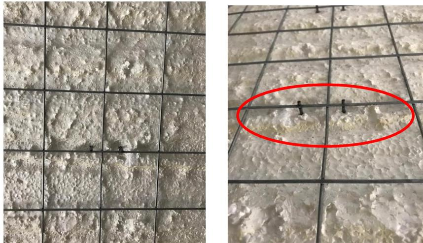
**Fotografía 5-1** Distribución de malla y detalle de conectores.
