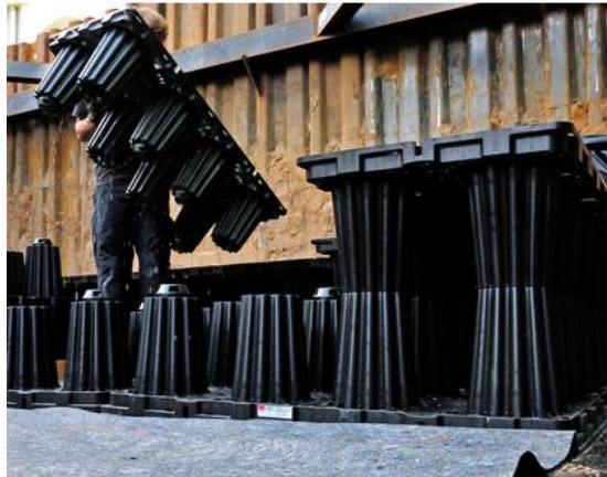
Figura 57. Gestor de aguas pluviales Stormbrixx ACO Fuente: (ACO, 2019)
