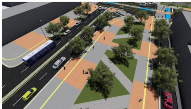
Figura 74 Imagen de andenes Calle 38 sur avenida Tintal Fuente: Propia basado en Sedic-Concol 023 (2017)
