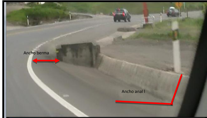
Figura 25. Estructuras hidráulicas en borde de berma PR4+500
