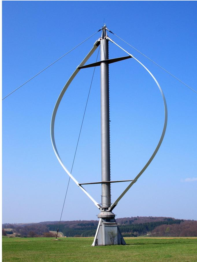
Figure 2.7: Turbina Dorier Darrieus 55, ubicada en Alemania con una capacidad de generacion de 55kW [21].
