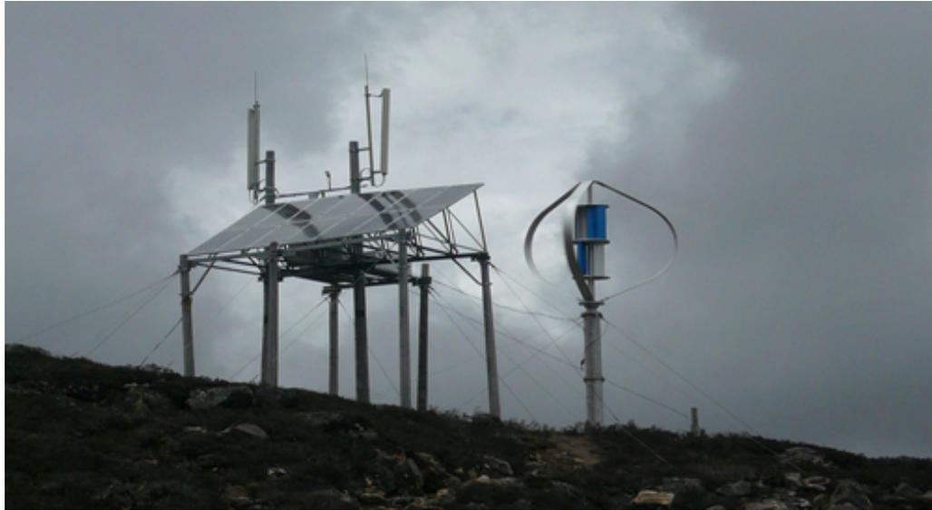
Figure 2.8: Turbina híbrida eólica vertical DS300, con capacidad para generar 3kW de potencia, instalada cerca de una torre de telecomunicaciones a la cual le brinda energía con ayuda también de paneles solares [23].
