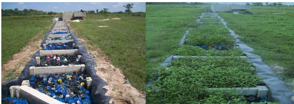
Fotografía 4 Humedal artificial empleado en tratamiento de aguas residuales de Caño Gandul
