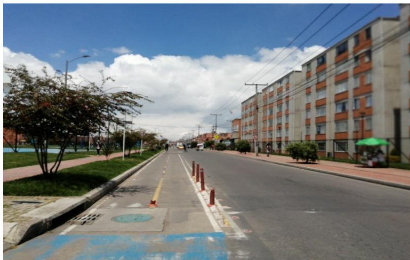
Fotografía No. 64. Acceso sur de la Carrera 100 por Calle 54 Sur. Vista al Sur. Fuente: Visita de campo 11/09/2020
