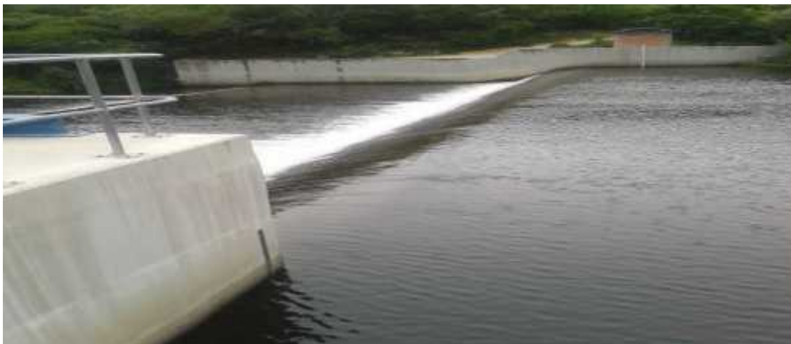
Figura 9-6: Presa derivadora. Imágenes captación (Fuente ADR, 2020)
