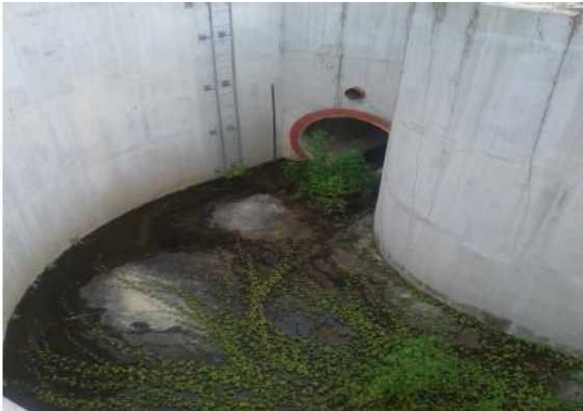
Figura 9-7: Canal de aducción de la conducción Ranchería
