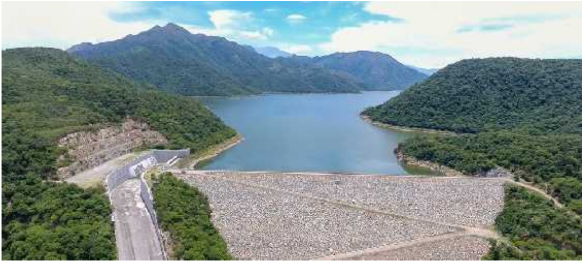
Figura 9-3: Vista de la presa El Cercado (Fuente: ADR, 2020)
