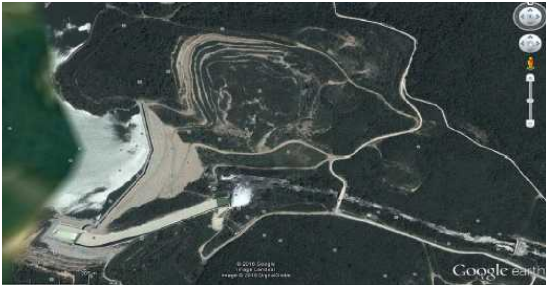
Figura 9-2: Represa el Cercado, estado actual (Fuente: GoogleEarth)
