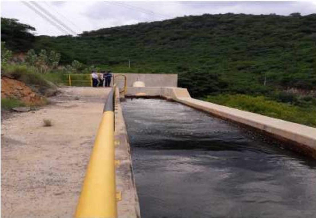
Figura 9-8: Tanque de amortiguación K0+000
