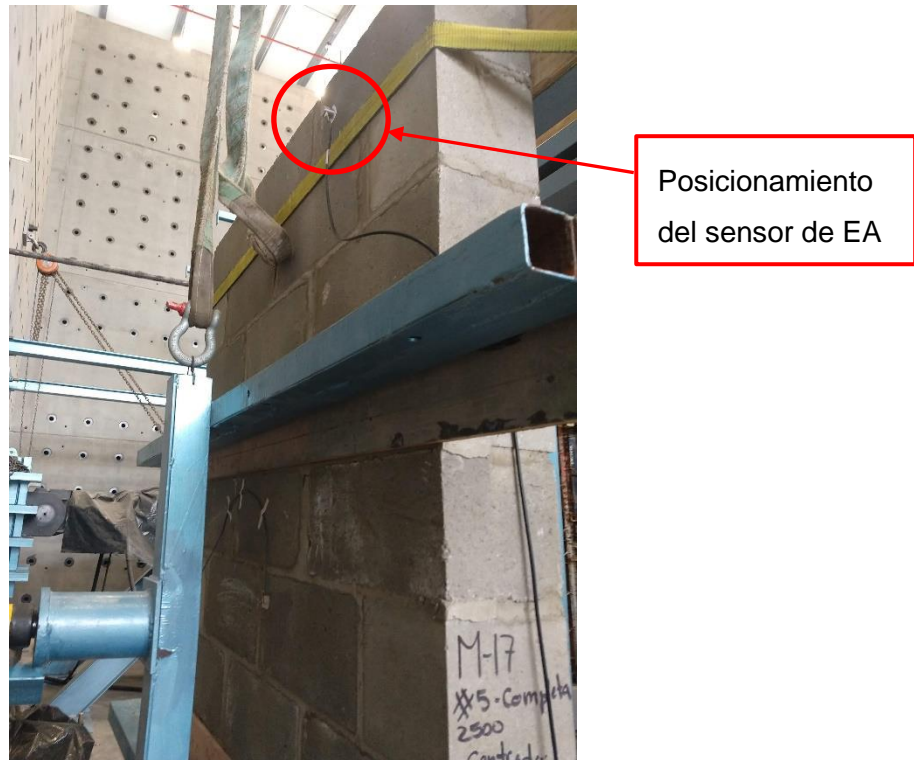
Figura 11. Colocación del sensor de Emisión Acústica. (Ensayo realizado por el grupo GIMECI de la Escuela Colombiana de Ingeniería)
