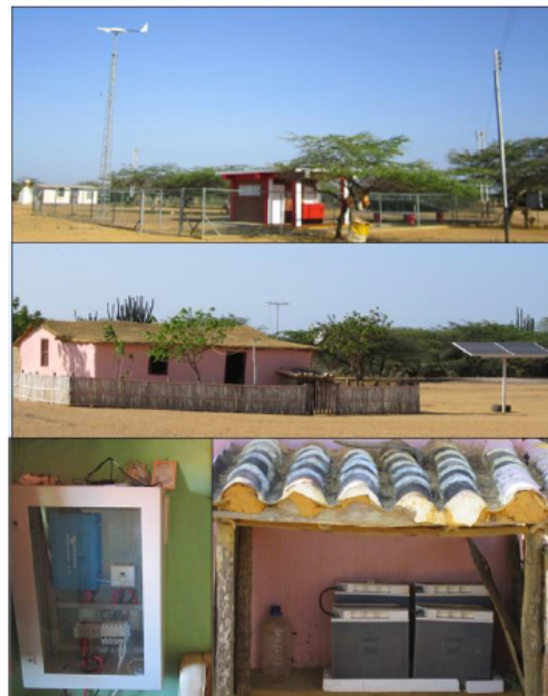
Figura 1.2: Micro-red de Jacuque en Venezuela; encima: micro-red, centro: sistema individual, abajo: Baterías e inductor. [5]
