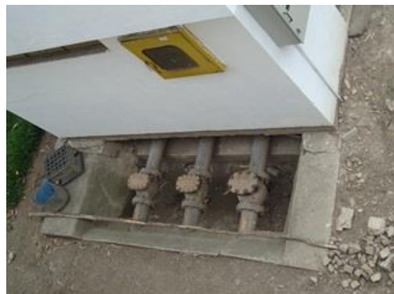
Figura 5. Salida de la estación de bombeo
