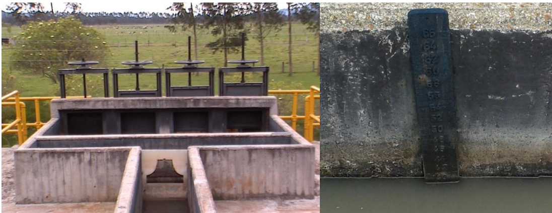
Figura 11. Vertedero tipo Sutro y regla para medición de caudal.
