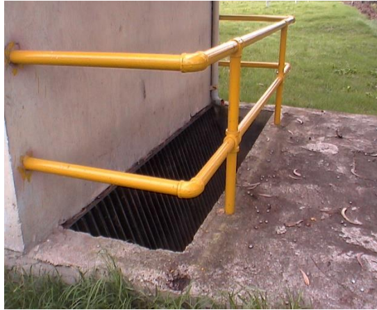
Figura 6. Rejillas de protección para bombas
