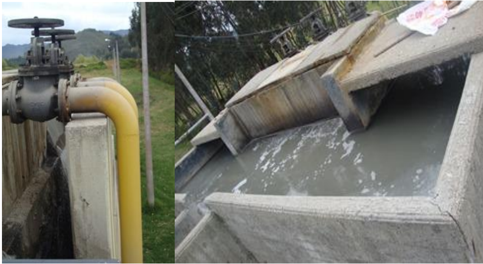
Figura 8. Vertedero de rebose de caudales de exceso
