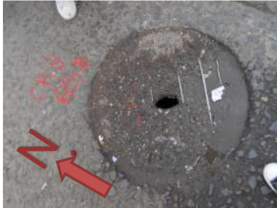
Fotografía 1 Marcado de pozos de inspección. Fuente: IEH GRUCON S.A.
