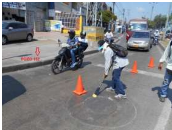
Fotografía 2 Marcado de puntos de referencia. Fuente: IEH GRUCON S.A.
