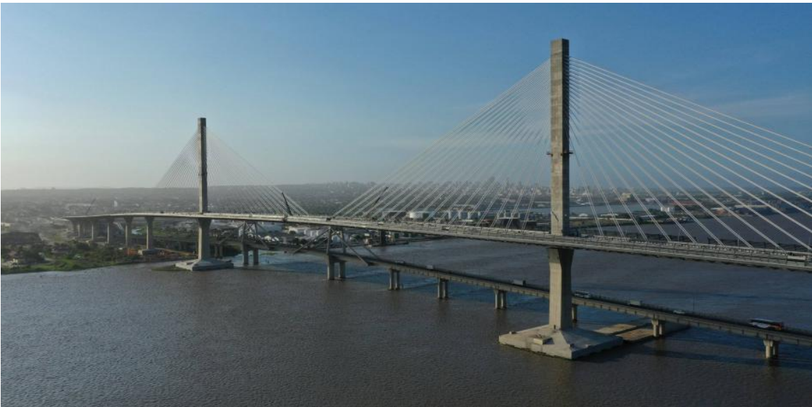
Figura 52. Fotografía panorámica nuevo puente Pumarejo Fuente: (SACYR Colombia, 2019)
